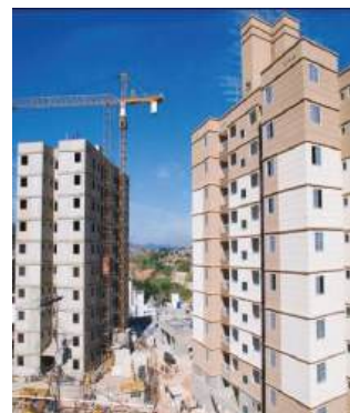
Figura 76: Montagem de painéis em edifício residencial – Condomínio Piemonte, em 2008 – Belo Horizonte (MG)
