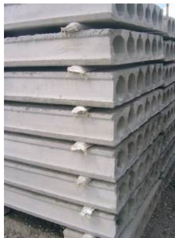
Figura 82: Situações transitórias: armazenamento de lajes alveolares pré-fabricadas
