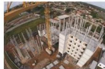
Figura 4: Sistema construtivo em pré-fabricados em concreto aplicados no segmento habitacional (Font: ABCIC)
