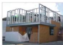
Figura 43: Veda o com Placas Ciment cias – com Placas OSB e MCMV – Paran  (Fonte: Saint-Gobain)
