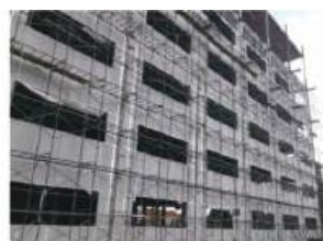
Figura 45: Fachada em light steel framing com veda o em Placas Ciment cias (Fonte: Saint-Gobain)
