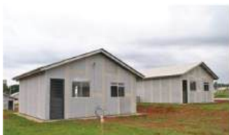
Figura 42: Veda o com Placas Ciment cias – MCMV – Paran  (Fonte: Saint Gobain)
