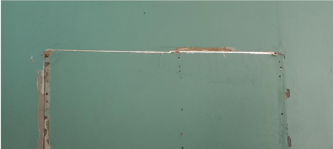
Paredes de tapume nos dormitórios da Passarela da Cidadania.
