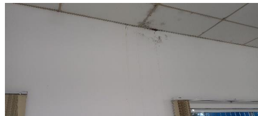
Buracos, infiltrações e mofo nas paredes e teto do abrigo provisório de Palhoça.
