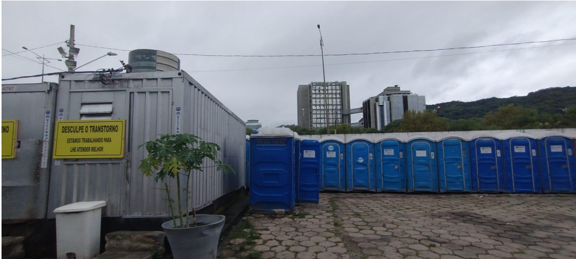
Banheiros químicos para a população em situação de rua na Passarela da Cidadania.
