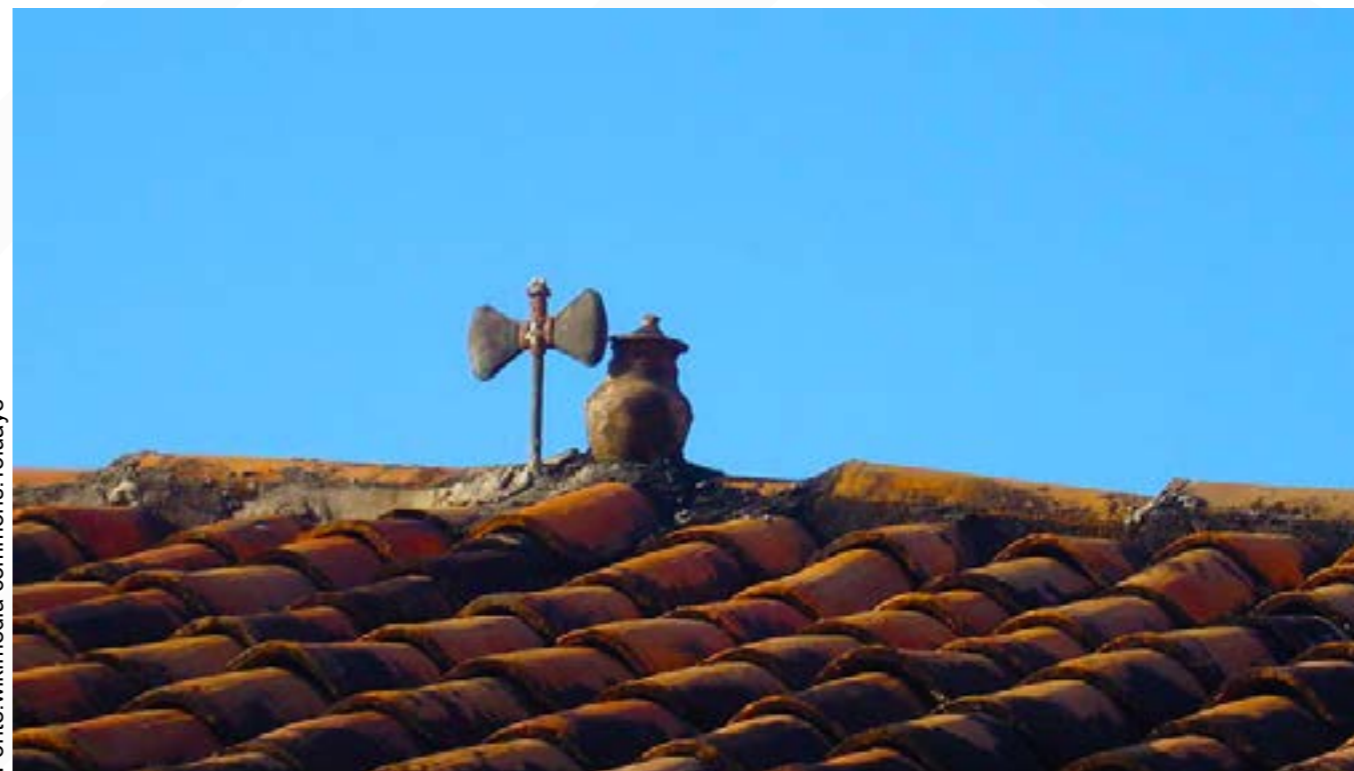
Telhado do Terreiro da Casa Branca
