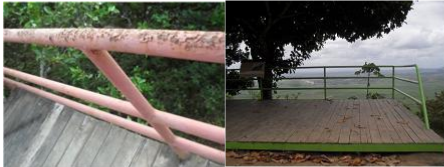
Figura 7 - Mirantes do Parque antes e depois da restauração
