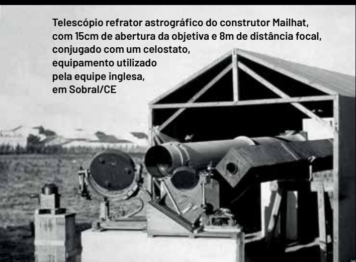
Telescópio refrator astrográfico do construtor Mailhat, com 15cm de abertura da objetiva e 8m de distância focal, conjugado com um celostato, equipamento utilizado pela equipe inglesa, em Sobral/CE
