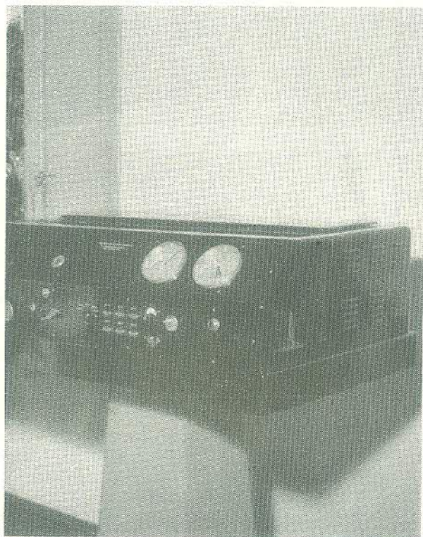
Transmissor eletrônico de sinais rádio-horários.
