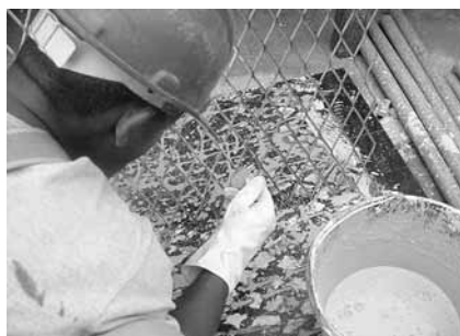
3 e 4 Tratamento de recuperação da estrutura metálica secundária.
