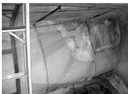
5 Complementação e recomposição da argamassa interna.
