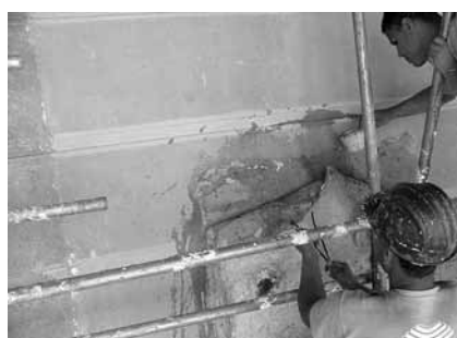
5 Complementação e recomposição da argamassa interna.
