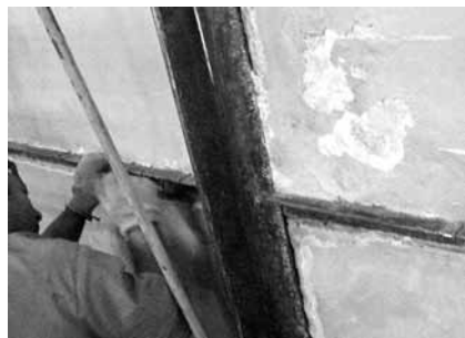
1 Pré-consolidação da face interna da argamassa externa.
