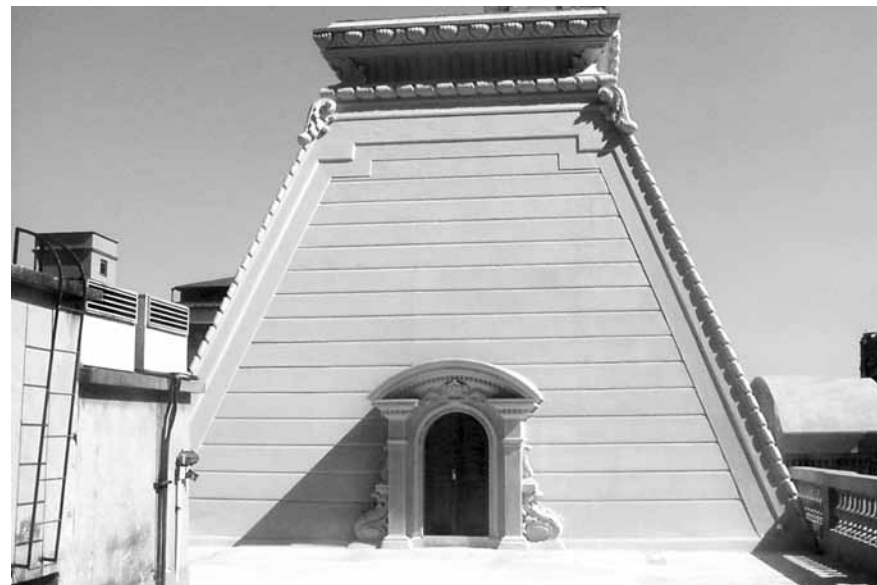
7 Vista da cúpula sul
