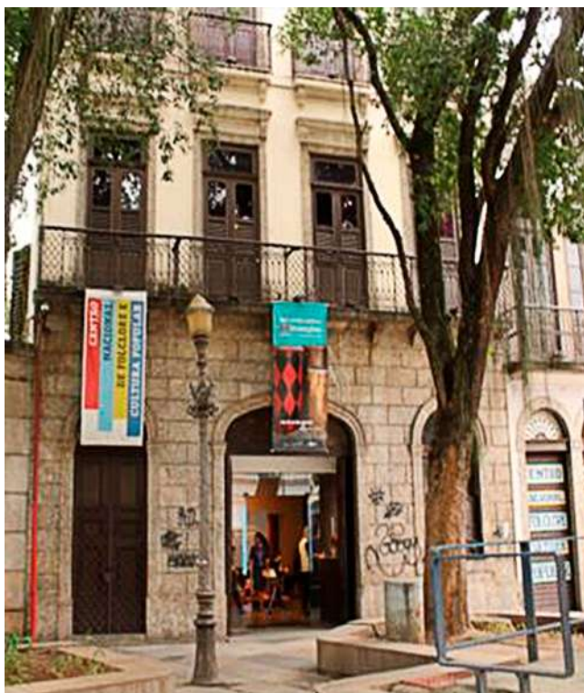
Figura 2: Fachada do Museu do Folclore, no bairro do Catete, Rio de Janeiro. Fonte: Acervo dos autores, 2019.
