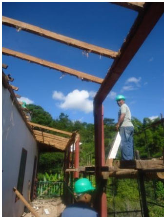
Figura 1: recuperação parcial da cobertura finalizada
