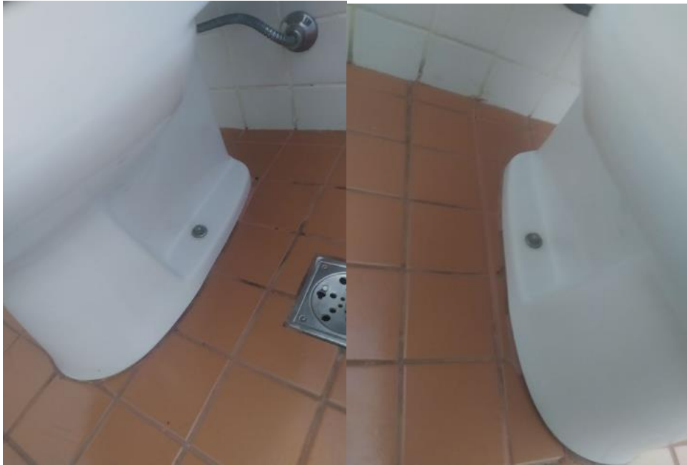
Fotos 115 e 116: Visão detalhada Cabine 01 - Base do vaso (vazamento na base do vaso)
