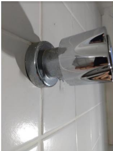
Foto 135 e 136: Visão detalhada Cabine 02 – Feminino – Registro (vazamento)
