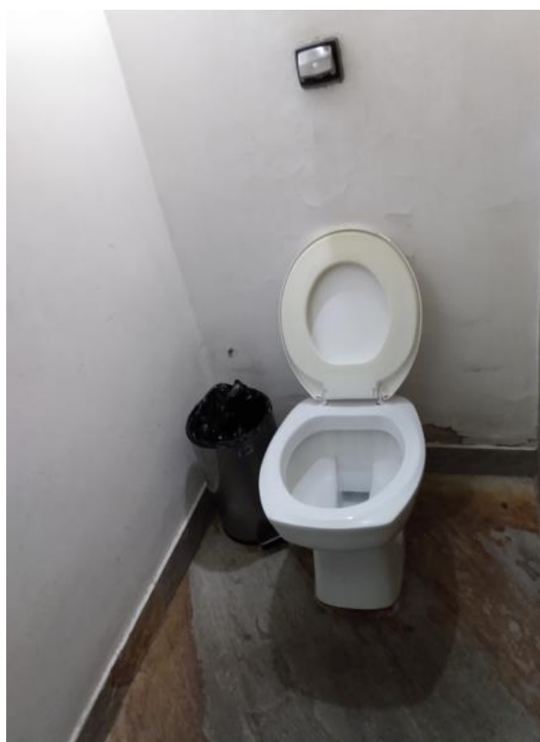
Fotos 46 e 47: Visão detalhada Cabine 02 – feminino – Vaso Sanitário; desprendimento de reboco
