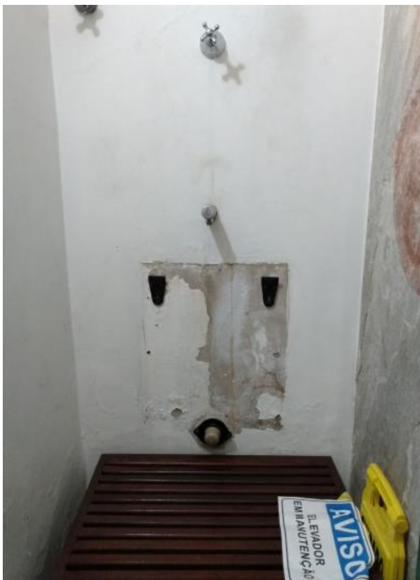
Fotos 23 e 24: - Visão detalhada Cabine 03 – registros desativados, ponto de descarga desativado e ponto de saída do antigo mictório desativado.
