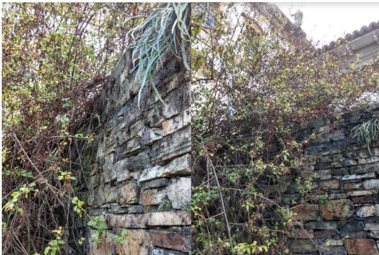
Fotos XX e XX: Visão detalhada - Banheiro do Anexo I – Vegetação Espessa sobre as paredes do lado esquerdo
