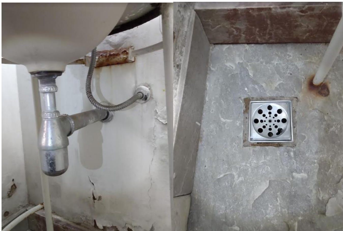
Foto 158: Visão detalhada Cabine 01 – Feminino – Sifão Foto 159: Visão detalhada Cabine 01 – Feminino – Ralo
