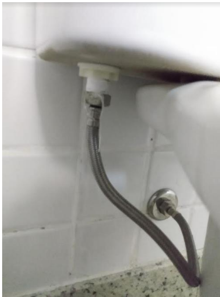
Foto 180: Visão detalhada Cabine 01 – Tubo de ligação Vaso/parede
