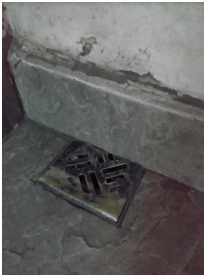
Foto 49: Visão detalhada Cabine 02 – feminino - Ralo (sem grelha anti-insetos)
