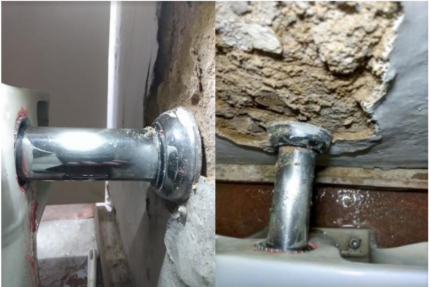
Fotos 149 e 150: Visão detalhada Cabine 01 – Feminino – Espude (vazamento, infiltração, desprendimento de reboco)
