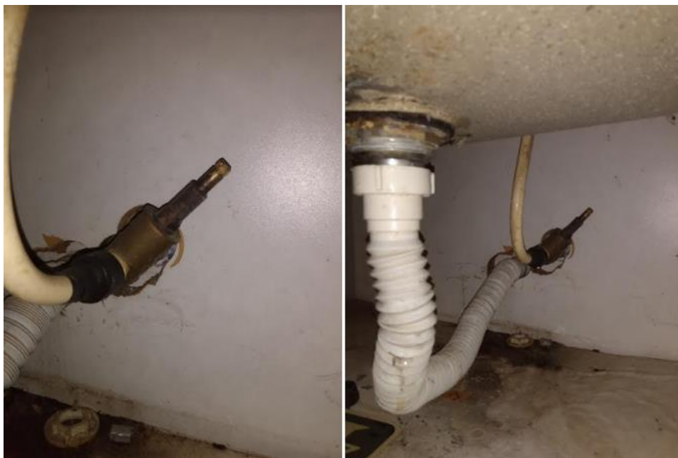
Visão Detalhada - Registro e vazamento sifão
