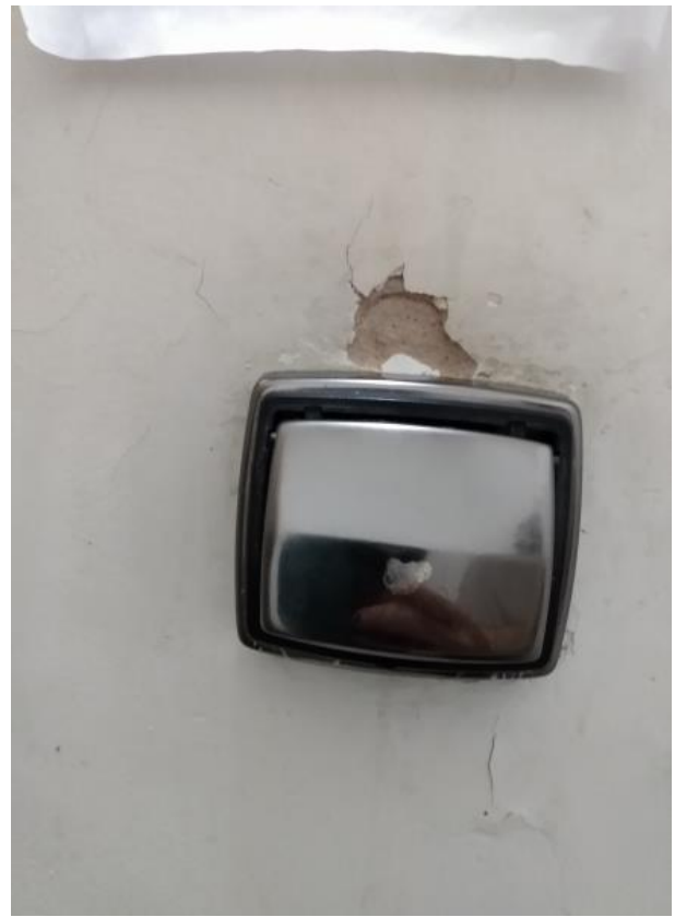
Fotos 34 e 35: Visão detalhada Cabine 01 – Masculino - descarga; desprendimento de reboco em razão da umidade; base do vaso sanitário.
