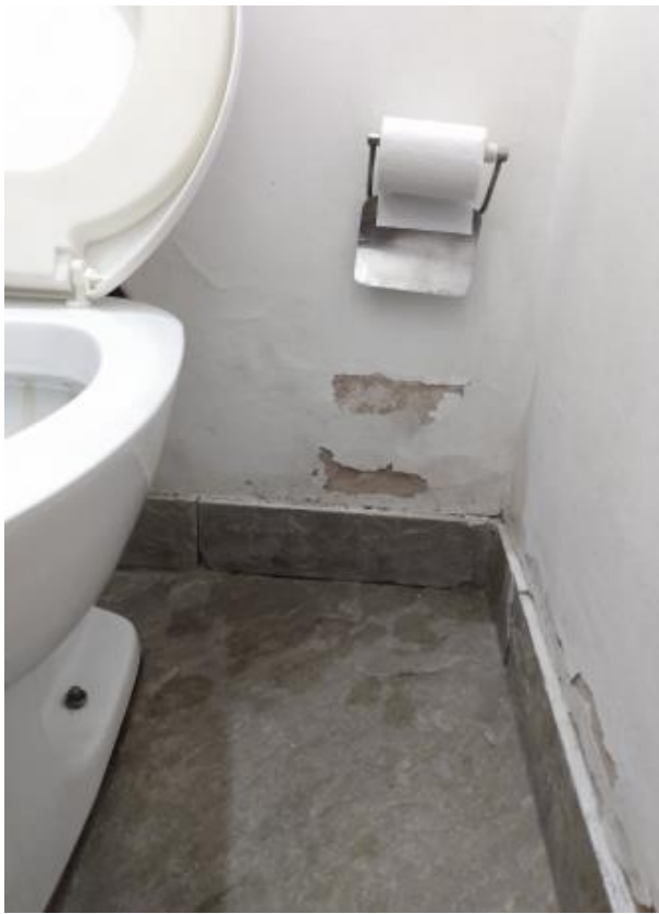
Fotos 34 e 35: Visão detalhada Cabine 01 – Masculino - descarga; desprendimento de reboco em razão da umidade; base do vaso sanitário.
