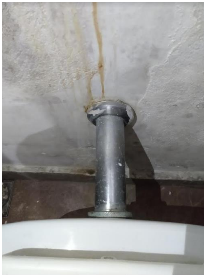
Foto 10: Visão detalhada Cabine 01 – Masculino (Espude)
