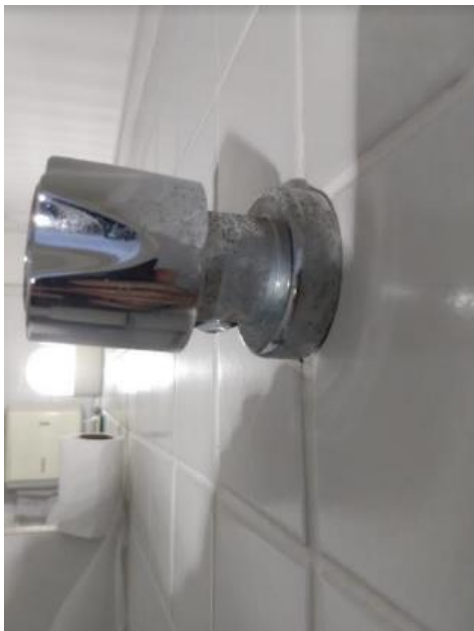
Foto 135 e 136: Visão detalhada Cabine 02 – Feminino – Registro (vazamento)
