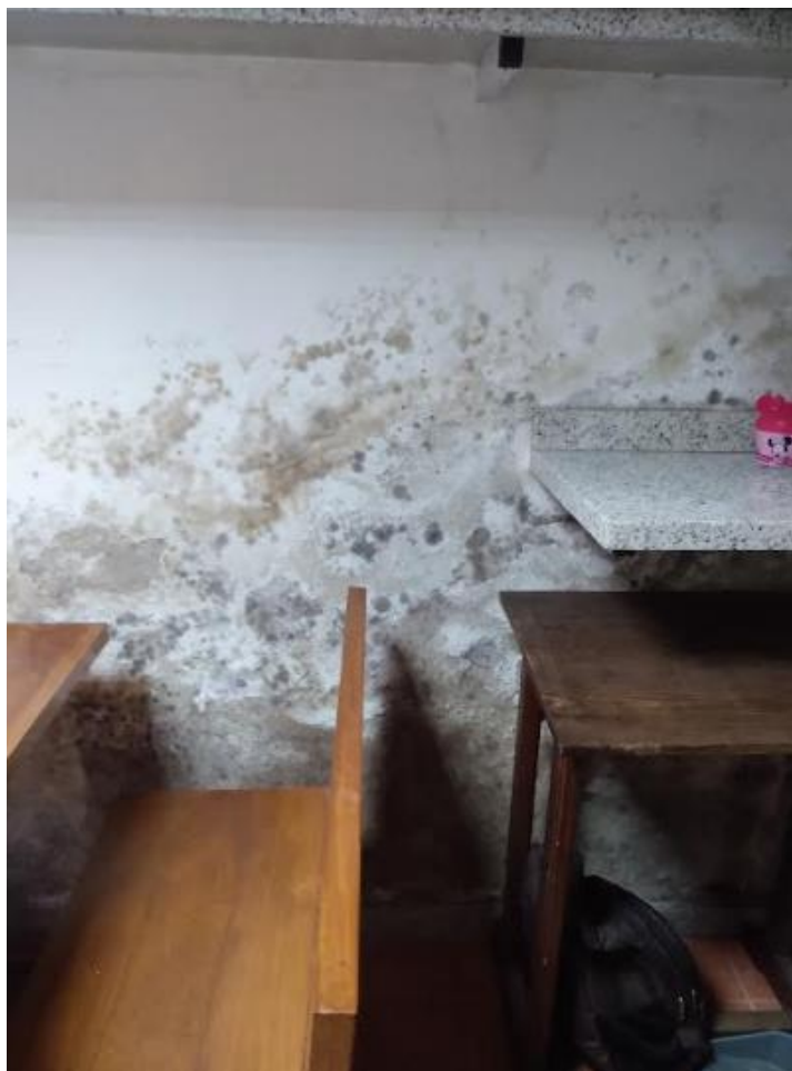
Foto XX: Visão detalhada – marca de infiltração e mofo - refeitório anexo II (infiltração oriunda de instalação de torneira na área da garagem)
