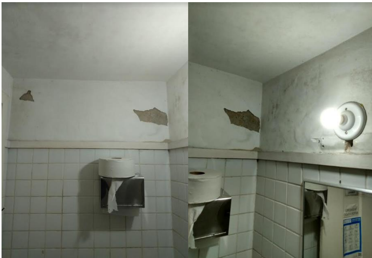
Fotos 77 e 78: Visão detalhada – Cabine 2 – Feminino – Desprendimento de Reboco causada por infiltrações e mofo
