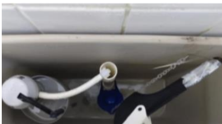
Foto 134: Visão detalhada Cabine 02 – Feminino – Sistema acoplado (danificado)
