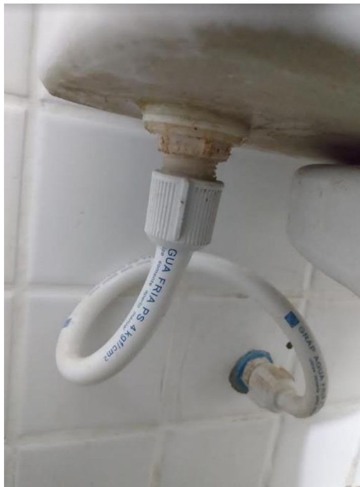
Foto 190: Visão detalhada Cabine 01 – Tubo de ligação Vaso/parede
