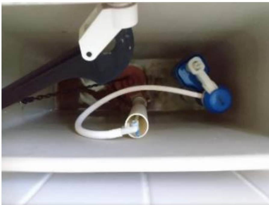
Foto 119: Visão Detalhada cabine 01 - Sistema Acoplado danificado
