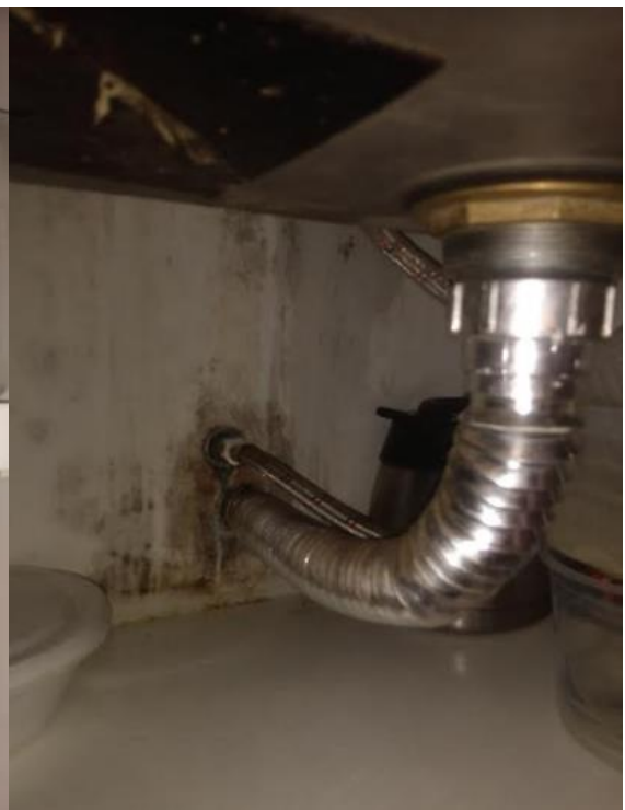
Fotos XX e XX: Visão detalhada - Sifão - Pontos de infiltração e desprendimento de reboco
