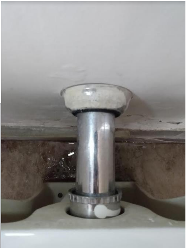
Foto 163: Visão detalhada Cabine 02 – Masculino – Tubo de ligação vaso/parede - espude (vazamento)
