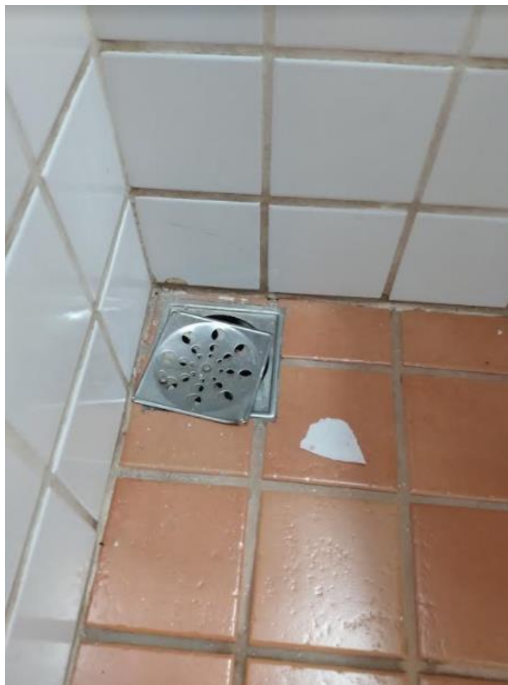
Foto 79: Visão detalhada – Cabine 2 – Feminino – Ralo sem grelha anti-insetos
