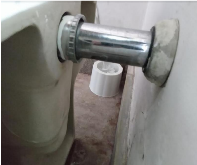
Foto 163: Visão detalhada Cabine 02 – Masculino – Tubo de ligação vaso/parede - espude (vazamento)
