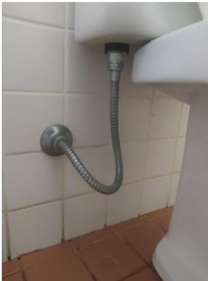
Foto 131: Visão detalhada Cabine 02 – Feminino – Tubo de ligação vaso sanitário/parede
