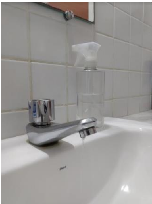
Fotos 123 e 124: Visão Detalhada cabine 01 - Torneira (com vazamento)
