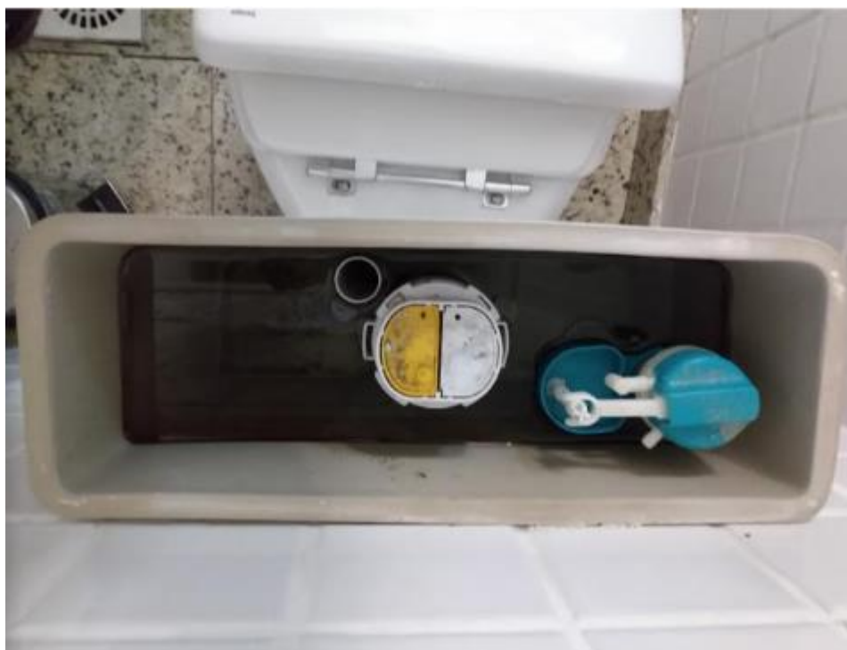
Fotos 181: Visão detalhada Cabine 01 – Sistema acoplado de descarga
