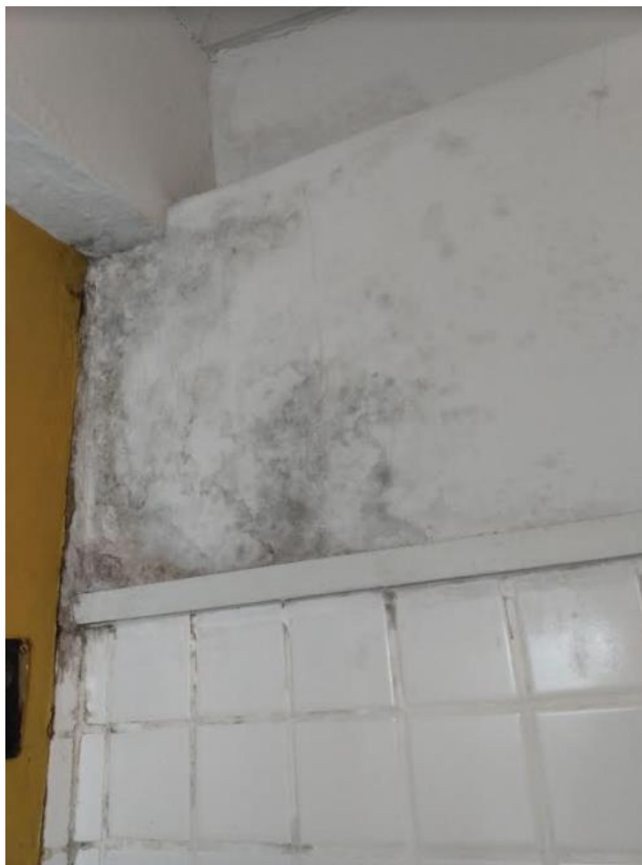
Fotos 186: Visão detalhada Cabine 01 – Ponto de Infiltração
