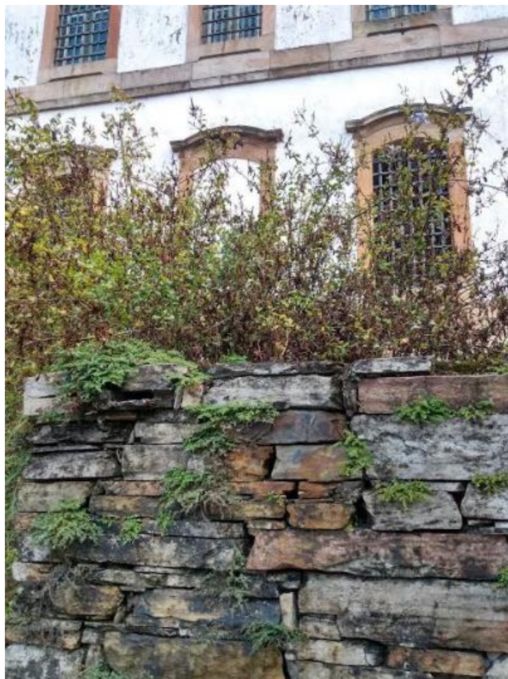
Foto XX: Visão detalhada - Banheiro do Anexo I – Vegetação Espessa sobre a laje
