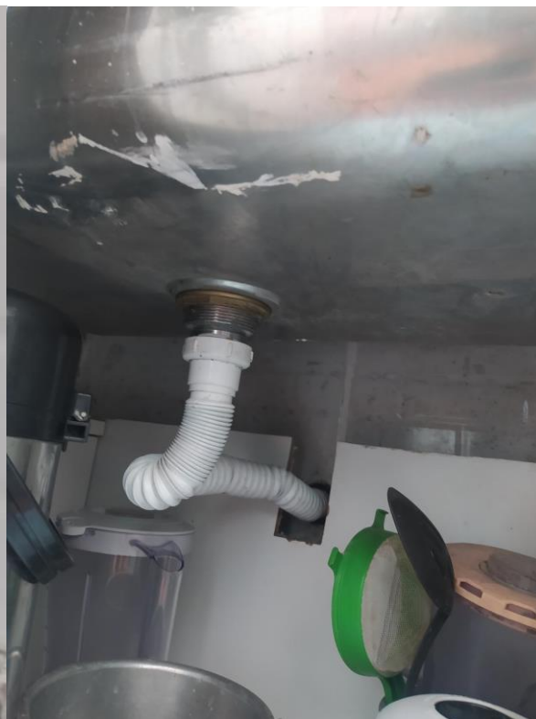
Foto XX: Visão detalhada – Torneira Pia - Refeitório Anexo II Foto XX: Visão detalhada - Sifão pia - Refeitório Anexo II
