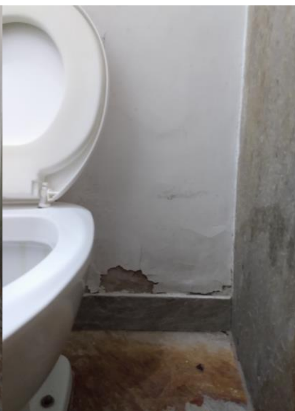
Fotos 46 e 47: Visão detalhada Cabine 02 – feminino – Vaso Sanitário; desprendimento de reboco
