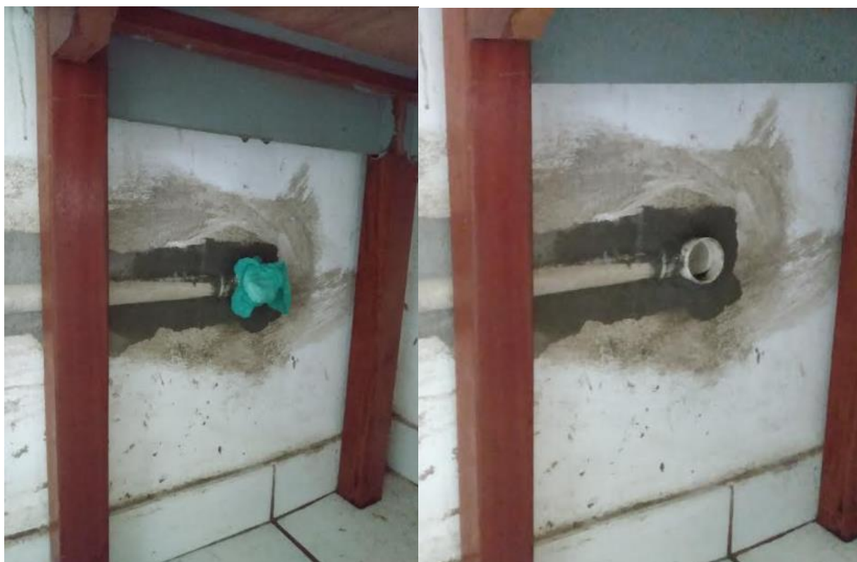
Fotos XX e XX: Foto XX: Visão detalhada canos com vazamento
