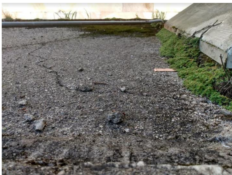
Foto XX: Visão detalhada – Laje do Banheiro do Anexo I – Existência de rachaduras na laje; Existência de musgo
