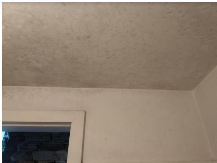
Foto 67: Visão Detalhada Cabine 1 – Masculino – Pontos de Infiltrações e Mofo
