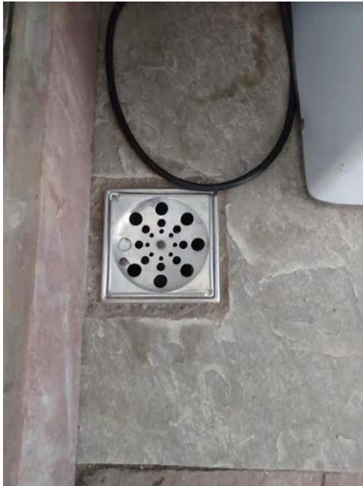
Foto XX: Visão detalhada ralo com grela não fixada
