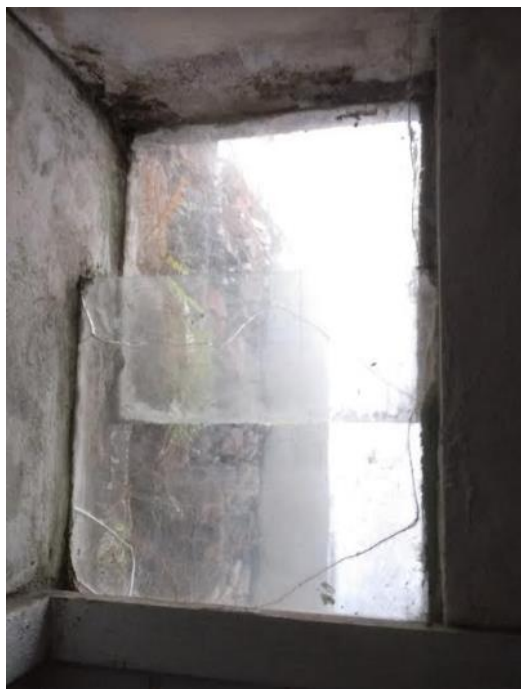
Fotos XX: Visão detalha Cabine 1 – masculino – Pontos de infiltração e mofo; rachaduras nos vidros
