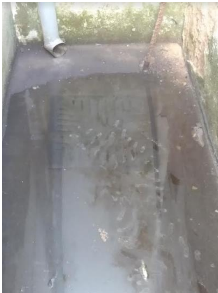
Foto XX: Visão detalhada: Corredor lateral – Anexo II – Detalhe empoçamento - ralo com entupimento (desentupimento dos ralos)
