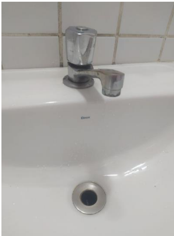
Foto 94: Visão detalhada Cabine 01 – Masculino – Torneira bamba
