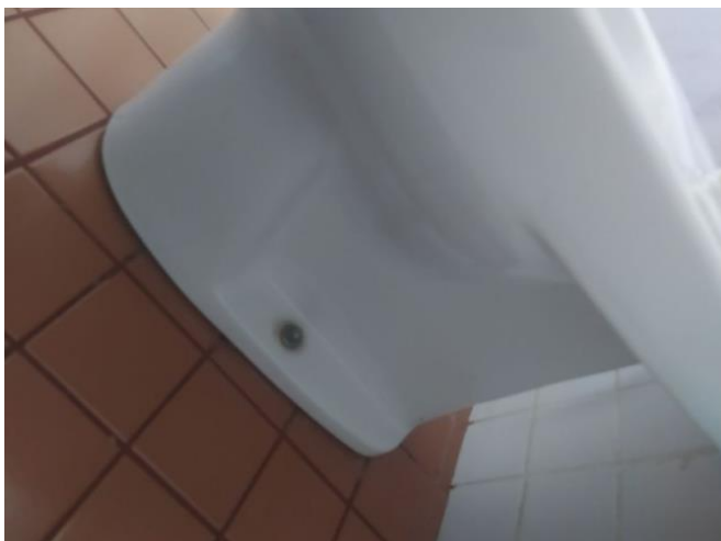
Fotos 129 e 130: Visão detalhada Cabine 02 – Feminino – Base do Vaso Sanitário (vazamento)
