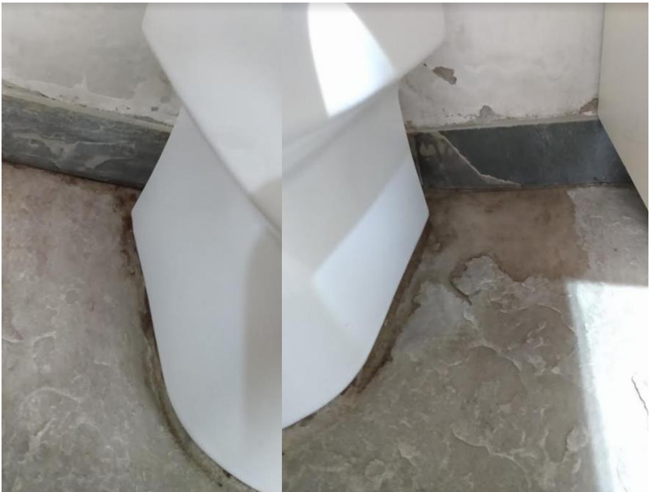
Fotos 164 e 165: Visão detalhada Cabine 02 – Masculino – Base Vaso Sanitário (vazamento e empoçamento)
