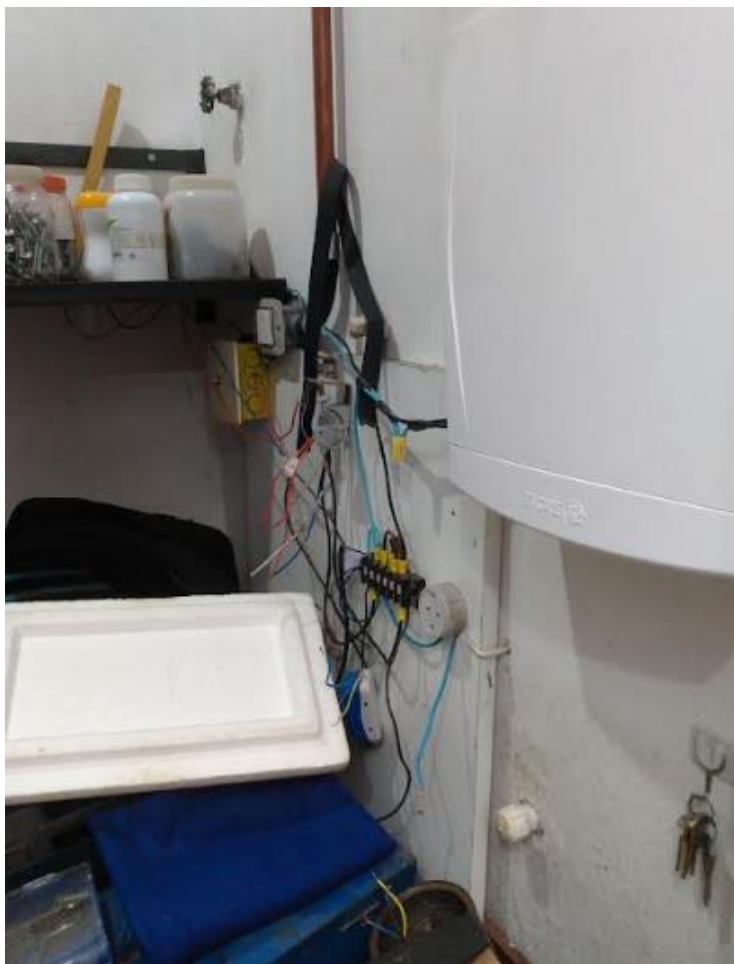
Foto XX: Visão detalhada – Registro (Danificado, ele é o motivo dos vazamentos), e ponto hidráulico desativado
