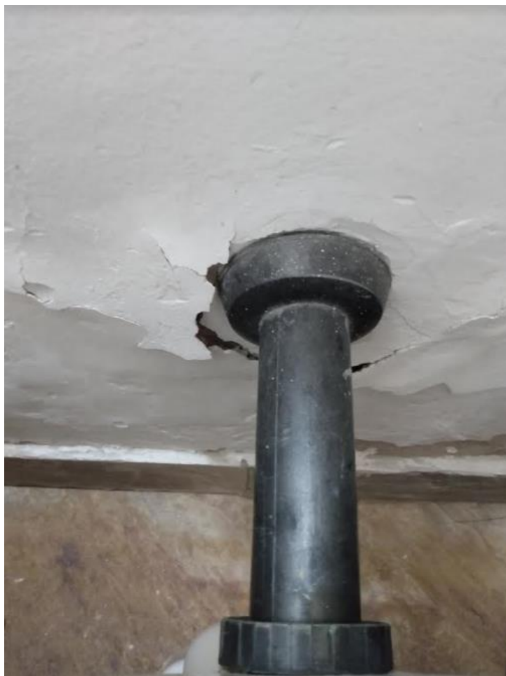
Foto 51: Visão detalhada Cabine 02 – feminino - Espude e desprendimento de reboco
