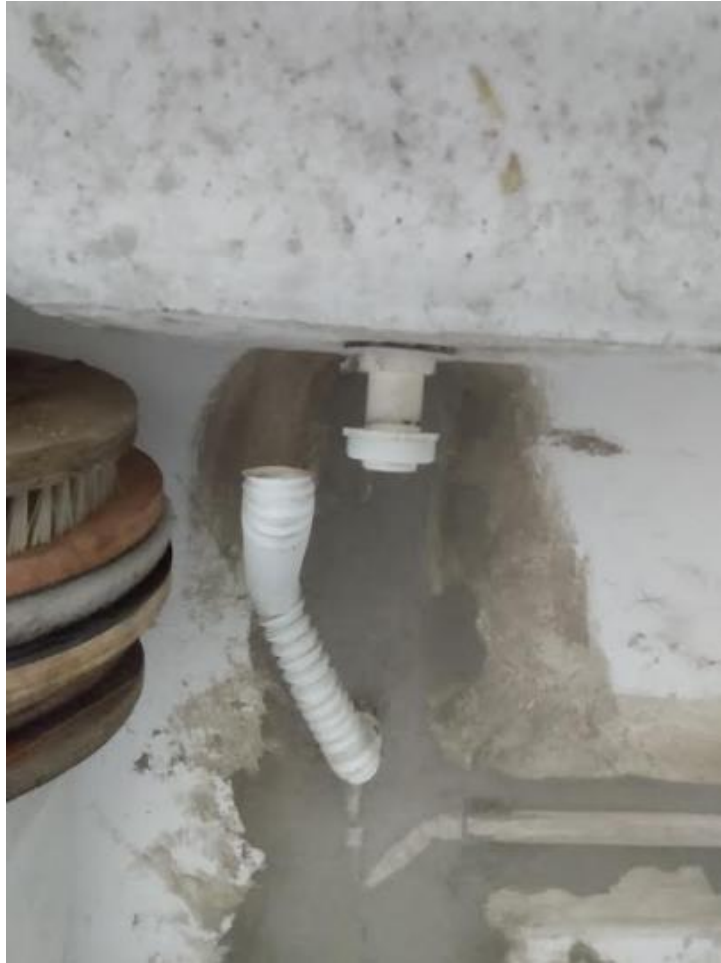
Foto XX: Visão detalhada - Sifão com rompimento
