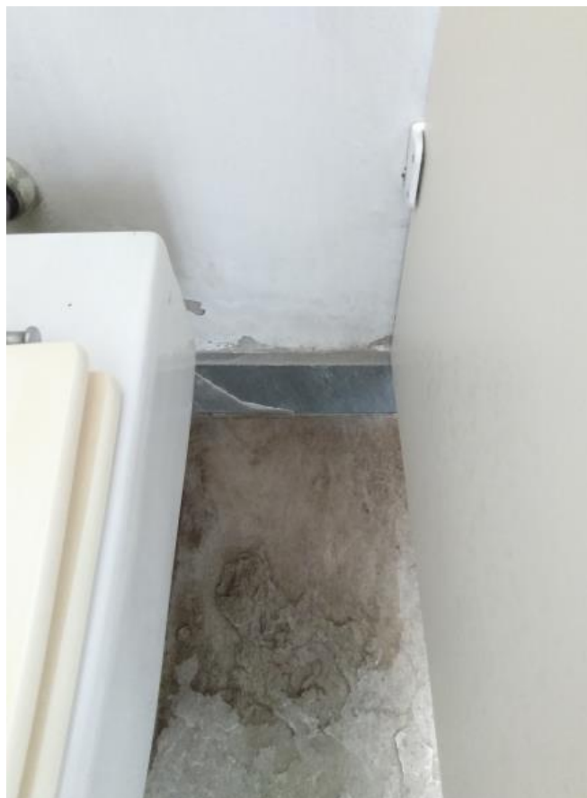
Fotos 164 e 165: Visão detalhada Cabine 02 – Masculino – Base Vaso Sanitário (vazamento e empoçamento)
