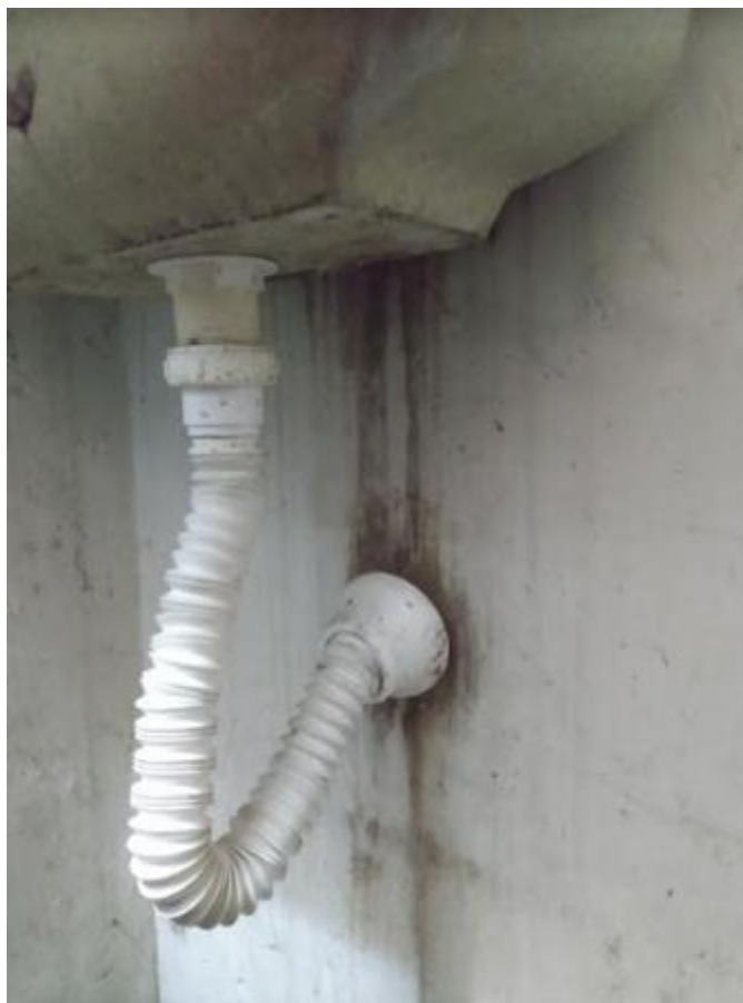
Detalhe Sifão - Vestiário Vigias – marcas de vazamento rejunte da pia
