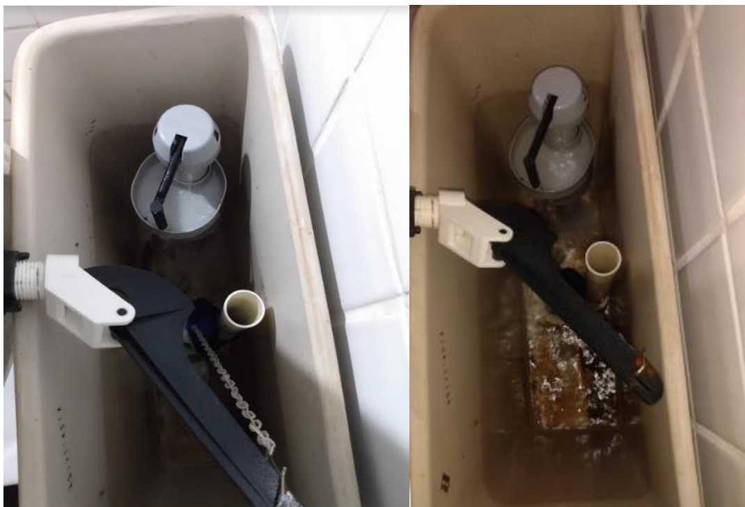
Fotos 89 e 90: Visão detalhada Cabine 01 – Masculino - Sistema acoplado do vaso sanitário danificado
