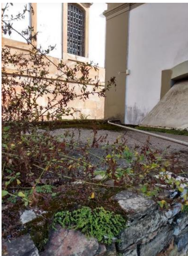
Fotos XX: Visão detalhada – Laje do Banheiro do Anexo I – Vegetação Espessa sobre a laje
