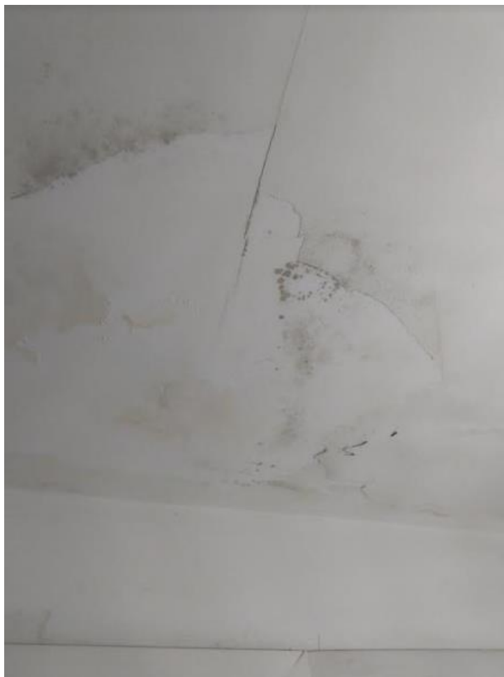
Foto 140: Visão detalhada Cabine 02 – Feminino – pontos de mofo
