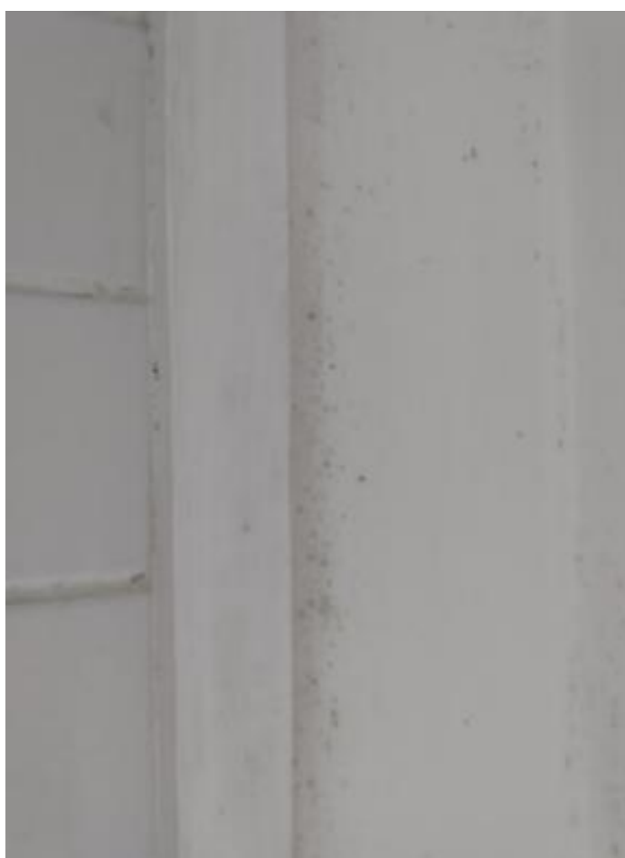
Fotos 125 e 126: Visão Detalhada cabine 01 - pontos de mofo em decorrência de umidade
