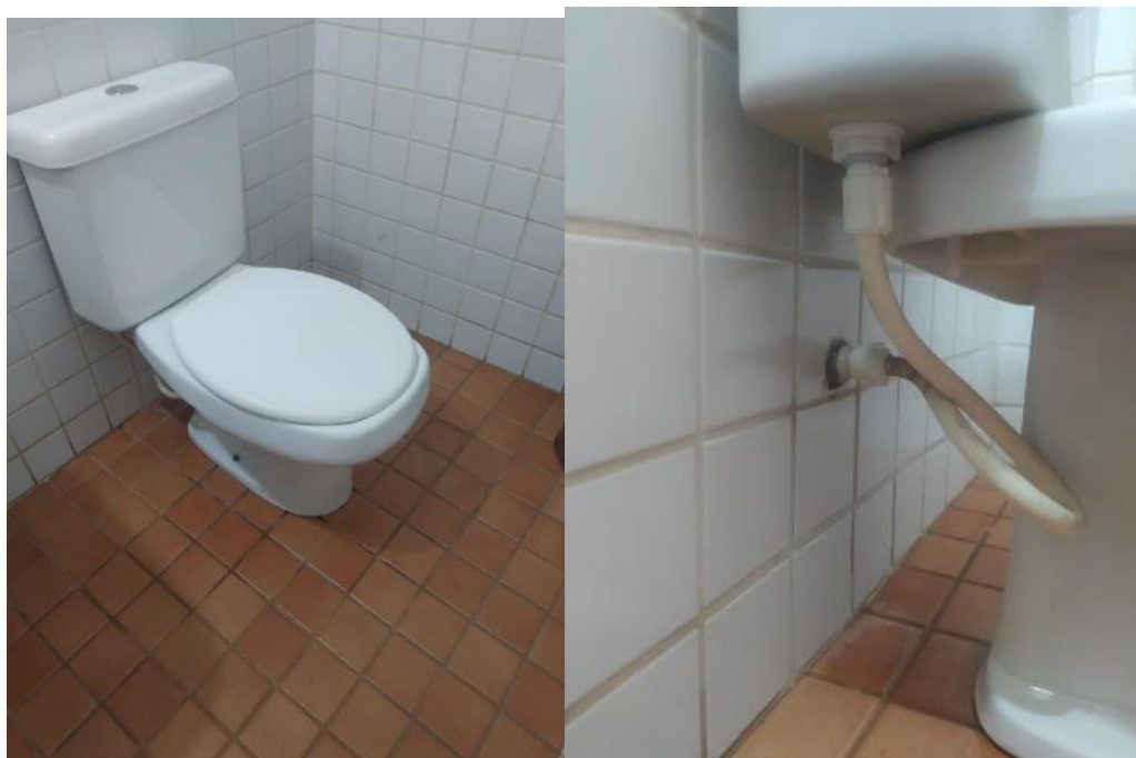
Foto 72 e 73: Visão detalhada – Cabine 2 – Feminino – Vaso Sanitário, Tubo de Ligação Vaso-Parede
