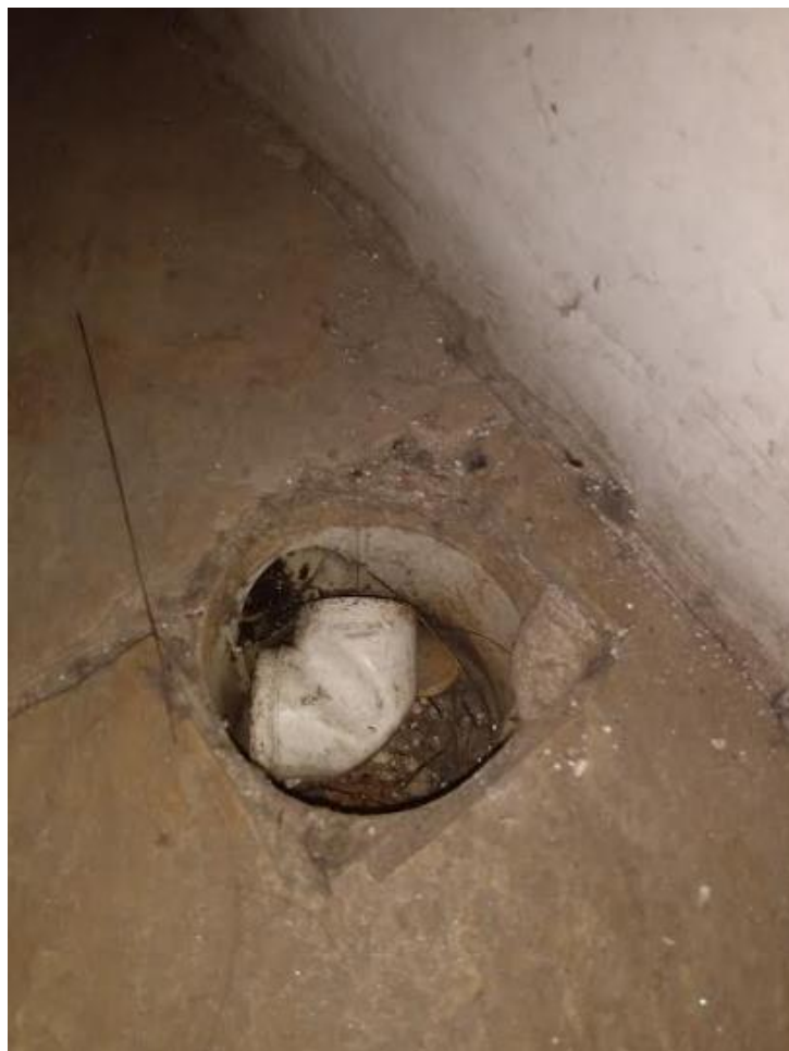
Visão Detalhada – Ralo Sem Grelha Anti-inseto e exalando mal odor
