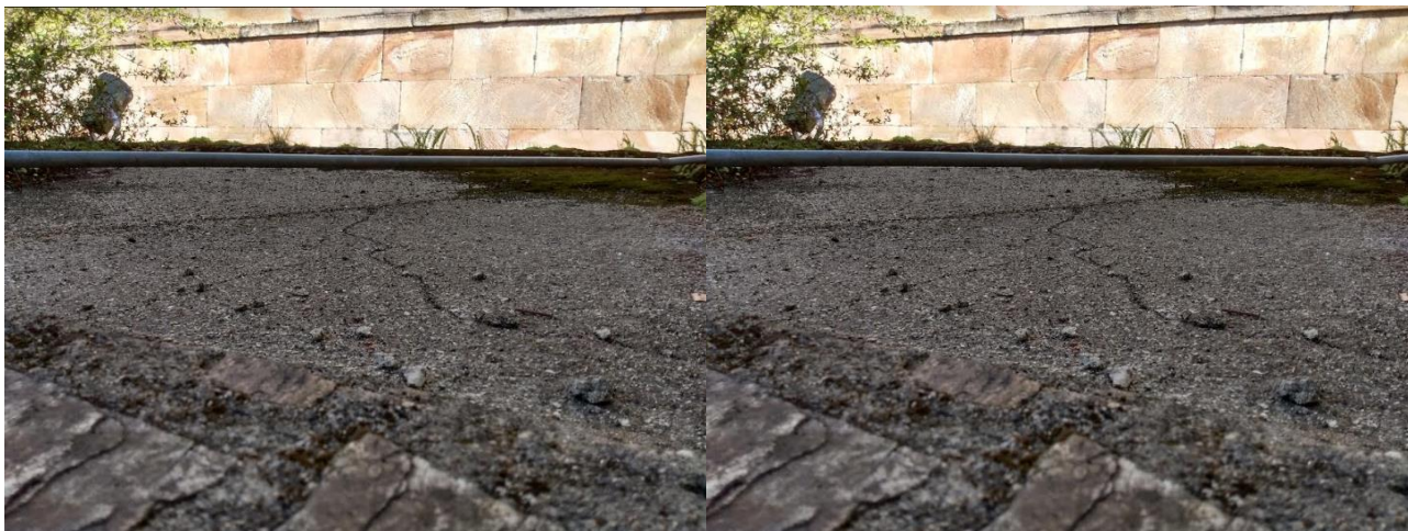
Fotos XX e XX: Visão detalhada - Laje do Banheiro do Anexo I – Existência de rachaduras na laje
