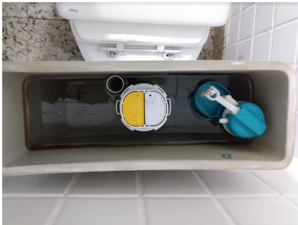
Fotos 191: Visão detalhada Cabine 01 – Sistema acoplado de descarga
