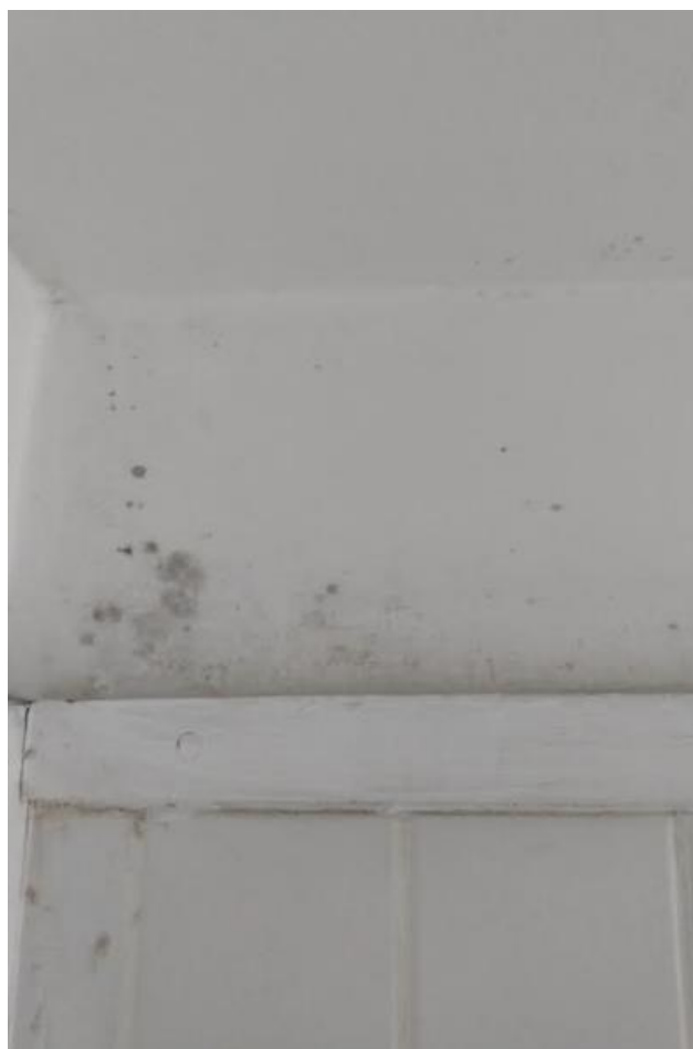
Fotos 125 e 126: Visão Detalhada cabine 01 - pontos de mofo em decorrência de umidade
