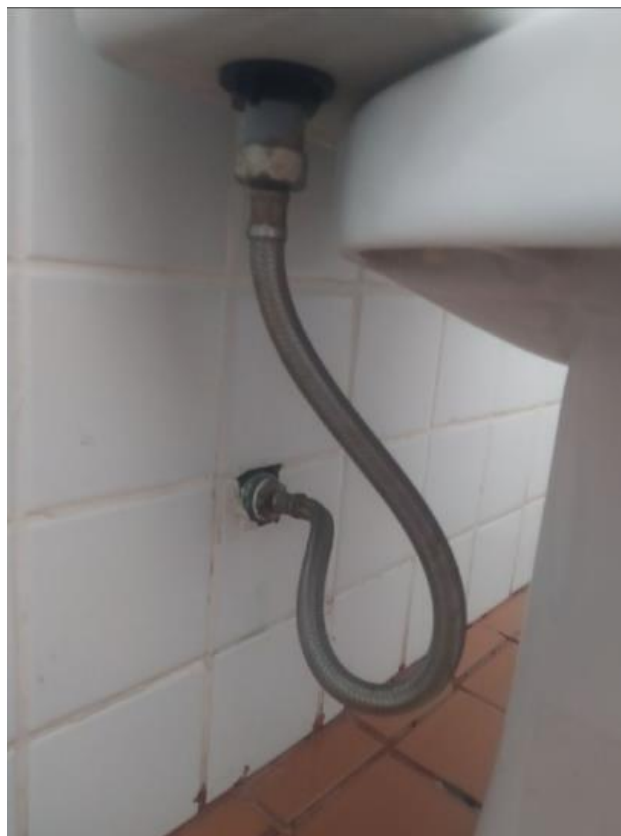
Foto 103: Visão detalhada Cabine 02 - Cano de ligação vaso/parede
