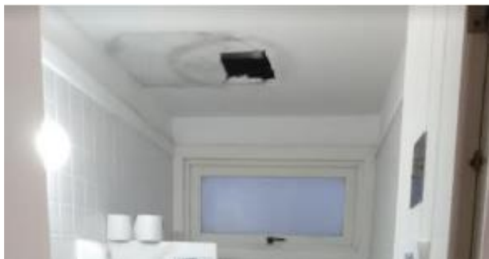
Foto 100: Visão detalhada Cabine 02 – Feminino - Buraco no teto de gesso
