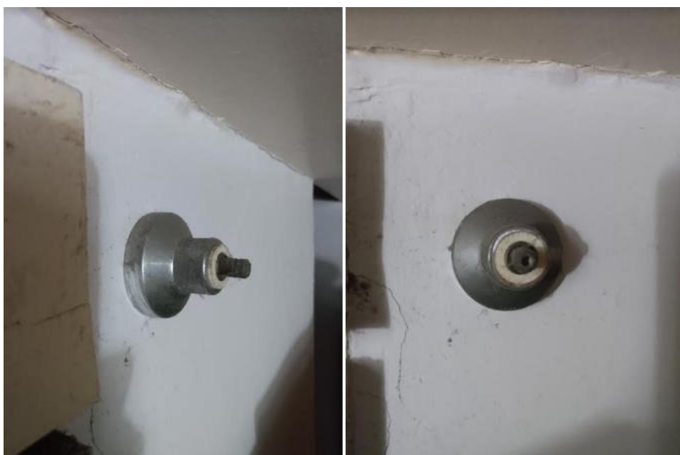
Detalhe Registro 1 – Sem a válvula externa ou borboleta, apresenta emperramento. Encontra-se em desuso.
