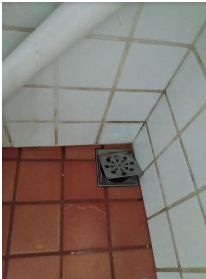
Foto 68: Visão Detalhada Cabine 1 – Masculino - Ralo sem grelha anti-insetos e empoçamento
