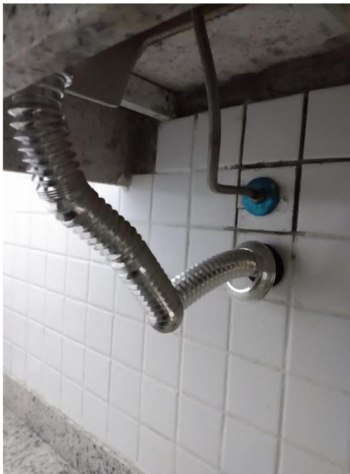
Fotos 195: Visão detalhada Cabine 01 – Sifão
