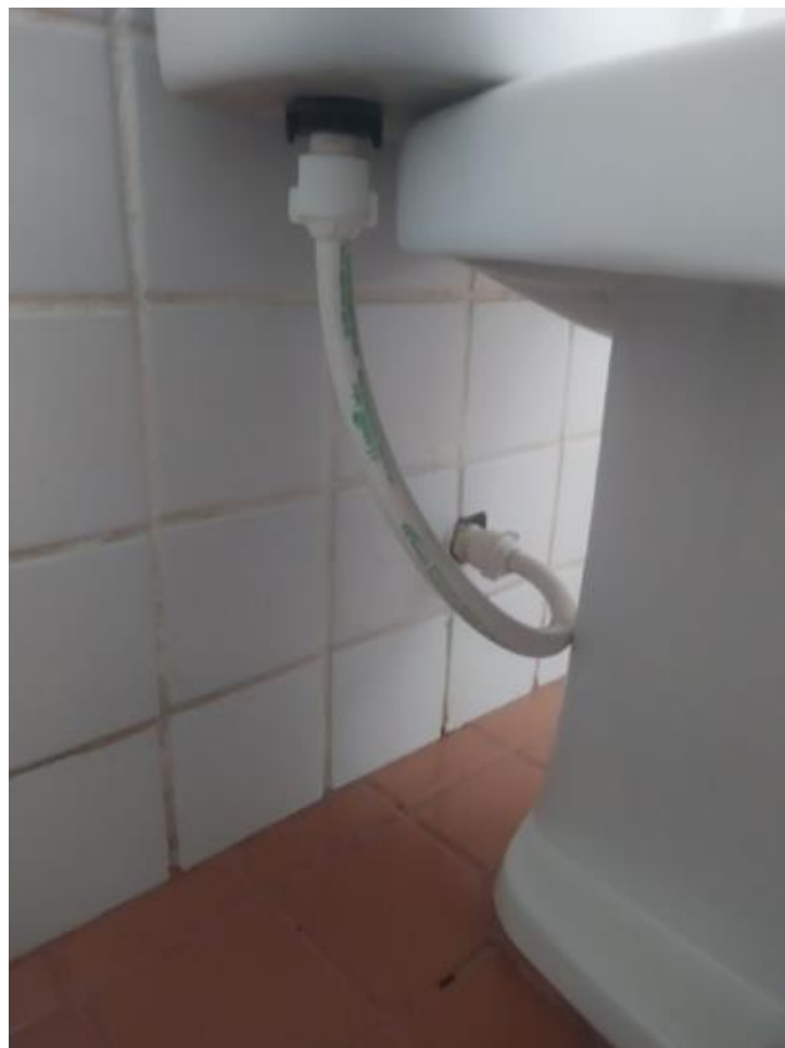
Foto 88: Visão detalhada Cabine 01 – Masculino - Tubo de Ligação vaso/parede
