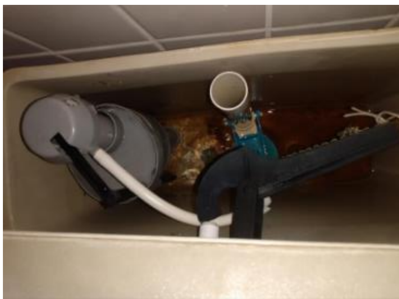
Foto 104: Visão detalhada Cabine 02 - Sistema Acoplado (danificado)
