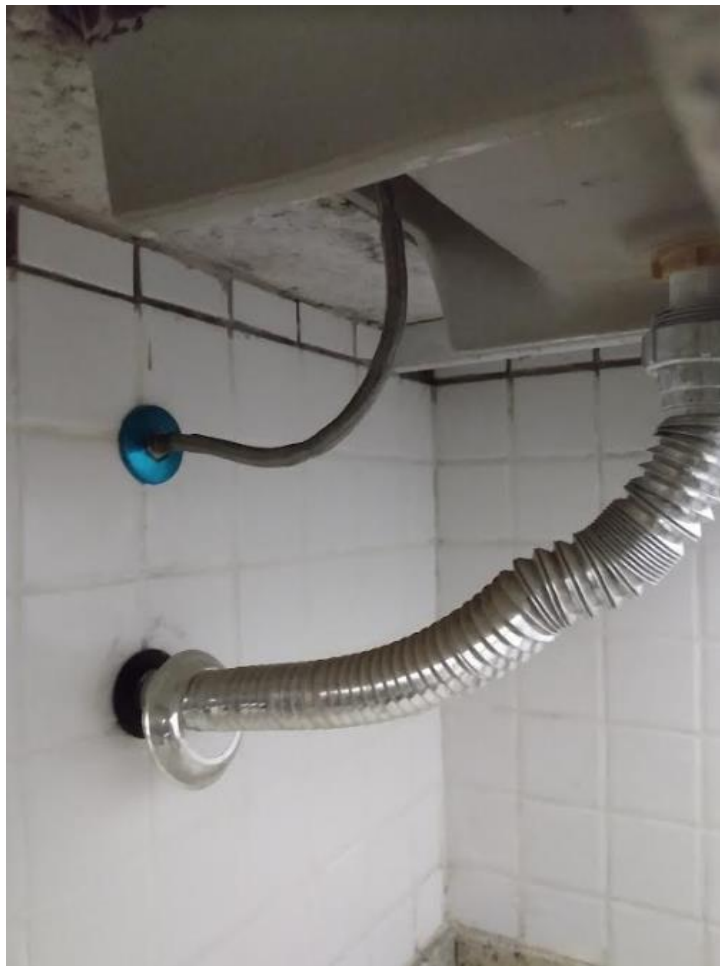
Fotos 185: Visão detalhada Cabine 01 – Sifão
