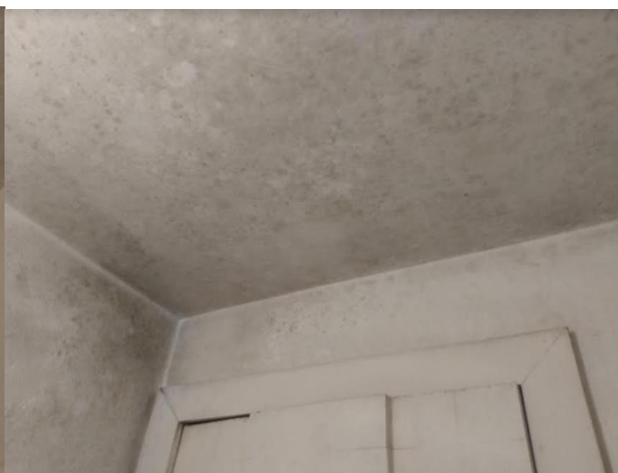
Foto 67: Visão Detalhada Cabine 1 – Masculino – Pontos de Infiltrações e Mofo
