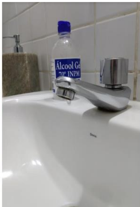
Fotos 123 e 124: Visão Detalhada cabine 01 - Torneira (com vazamento)
