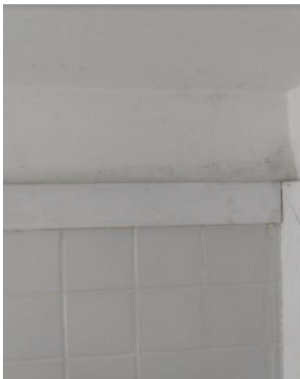
Foto 97: Visão detalhada Cabine 01 – Masculino – Ponto de mofo por umidade
