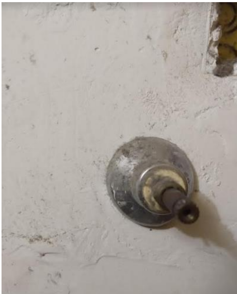
Detalhe Registro 2 – Registro sem a válvula externa ou borboleta, porém apresenta bom desempenho no funcionamento
