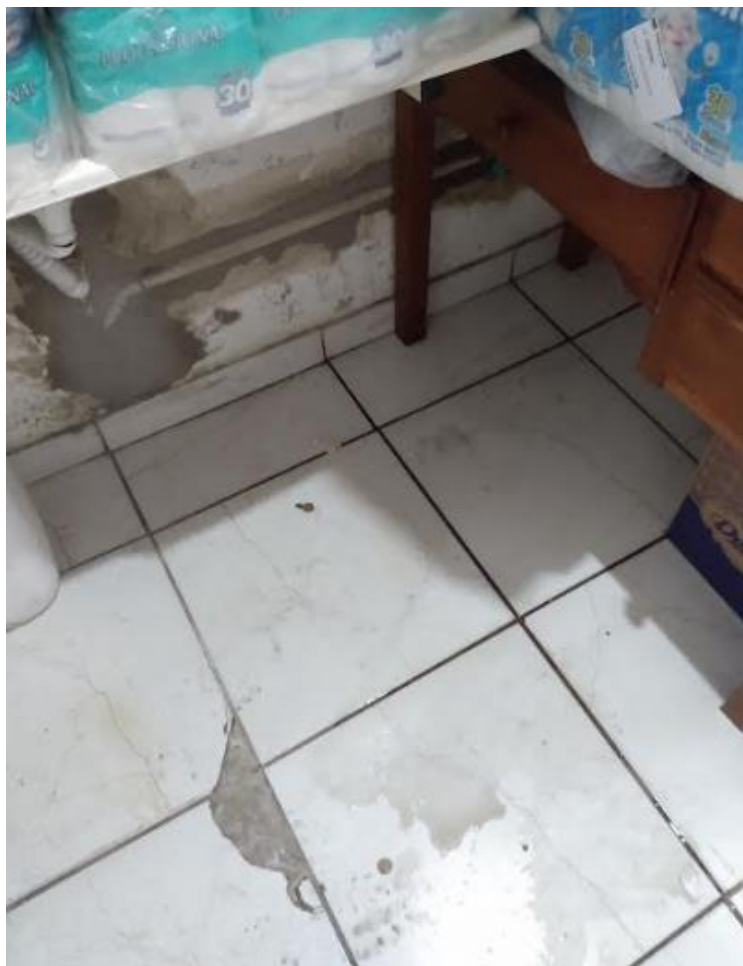
Fotos XX: Visão detalhada - área com empoçamento
