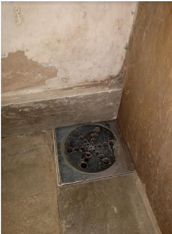
Foto 41: Visão detalhada Cabine 01 – Masculino – Ralo (sem grelha anti-insetos), desprendimento de reboco nas paredes
