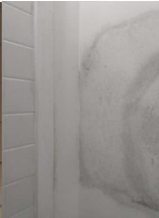
Foto 111: Visão detalhada – pontos de mofo por umidade (teto)
