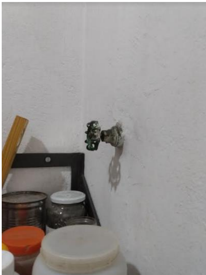
Foto XX: Visão detalhada – Registro (Danificado, ele é o motivo dos vazamentos)
