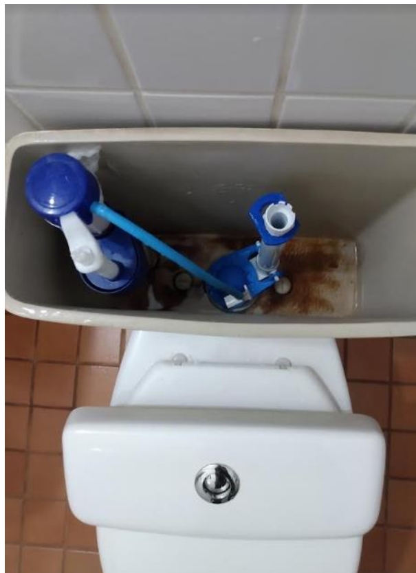
Foto 76: Visão detalhada – Cabine 2 – Feminino – Sistema acoplado danificado
