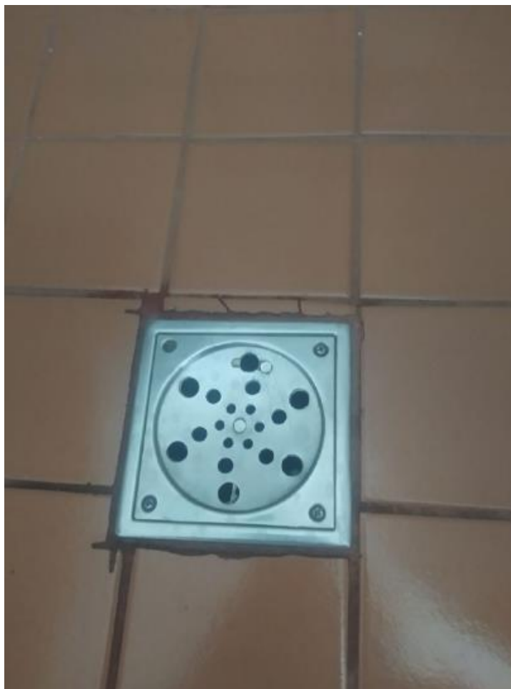
Foto 96: Visão detalhada Cabine 01 – Masculino - Ralo sem grelha anti-inseto
