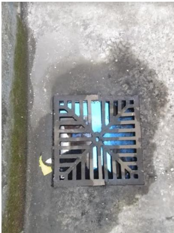
Foto XX: Visão detalhada – Corredor – ralo com entupimento
