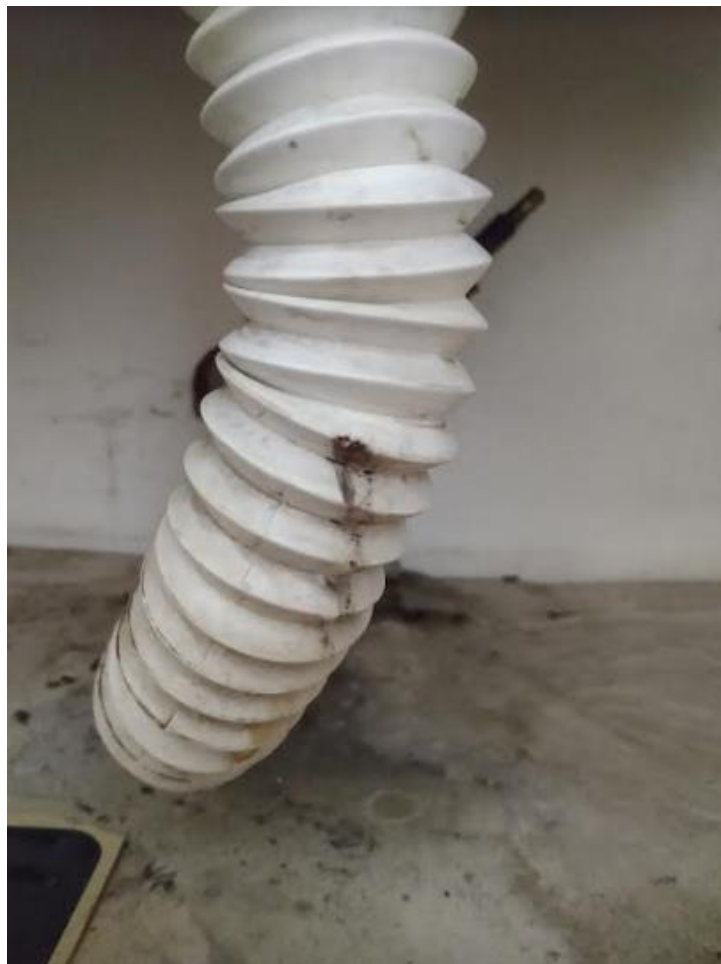
Visão Detalhada Sifão – Rompimento
