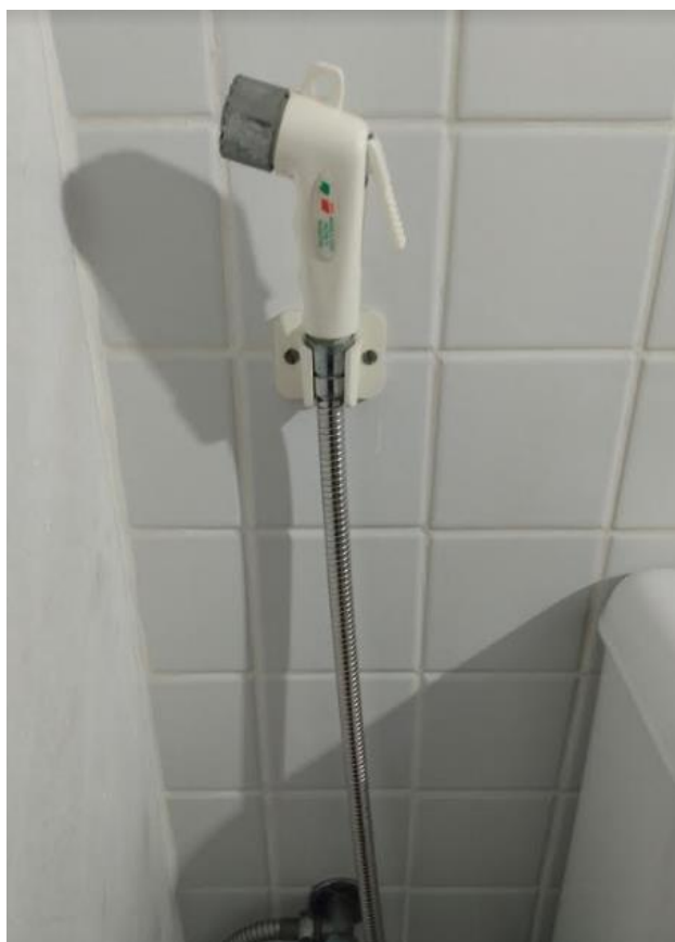
Foto 132: Visão detalhada Cabine 02 – Feminino – Ducha Higiênica (danificada)
