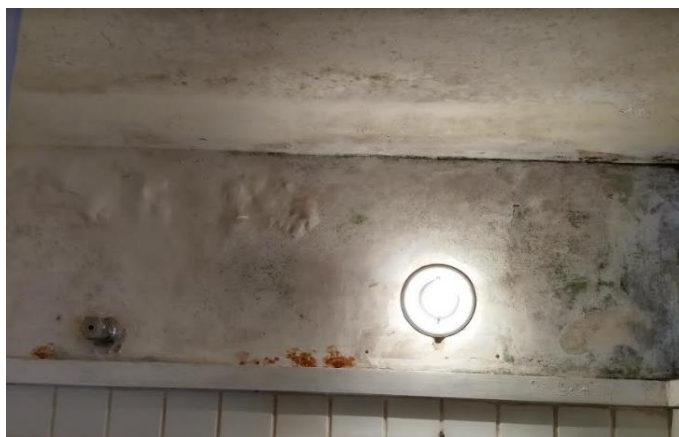
Fotos XX: Visão detalha Cabine 1 – masculino – Pontos de infiltração e mofo
