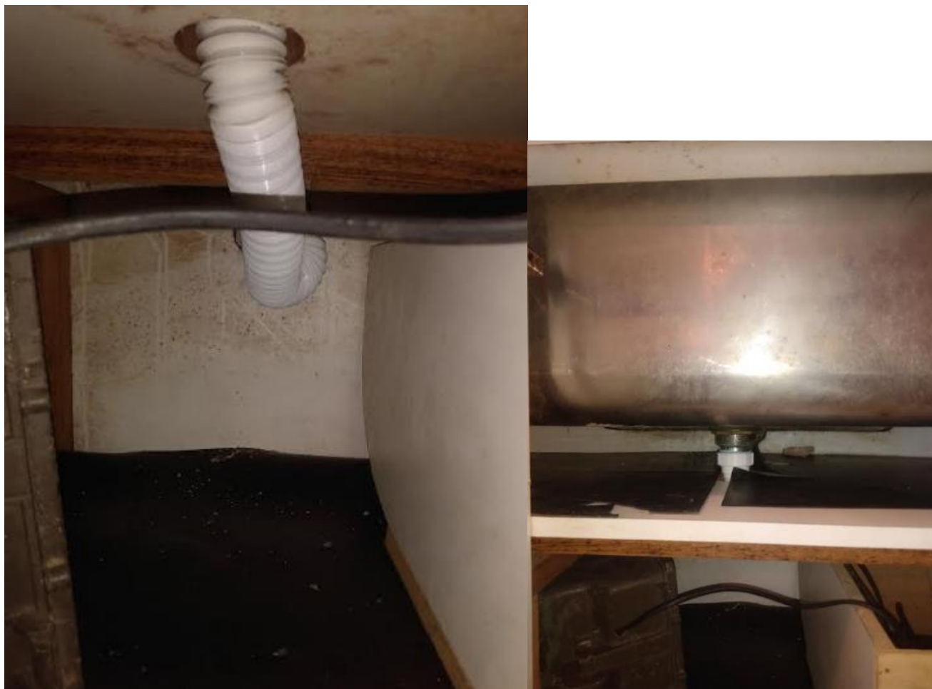
Fotos XX e XX: Visão Detalhada - Sifão pia do Laboratório
