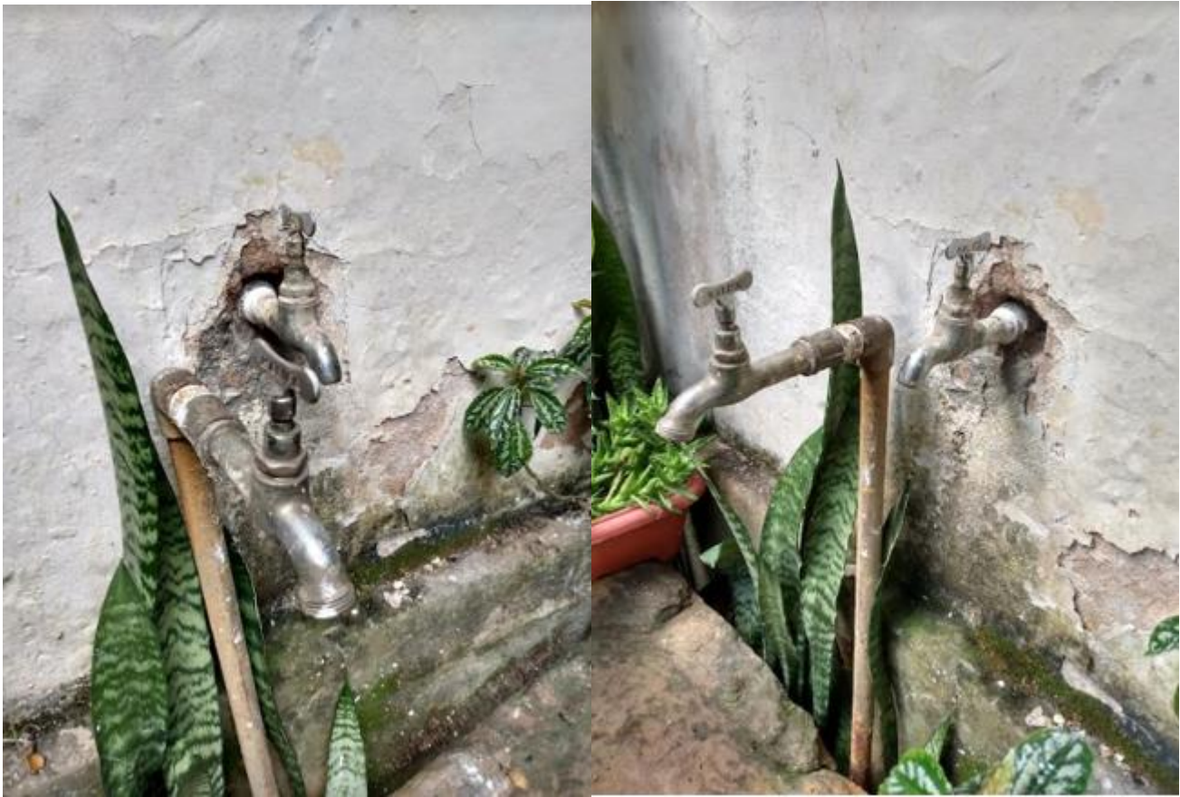
Fotos XX: Tanque e torneiras – Uma das torneiras apresenta danificação e entupimento.
