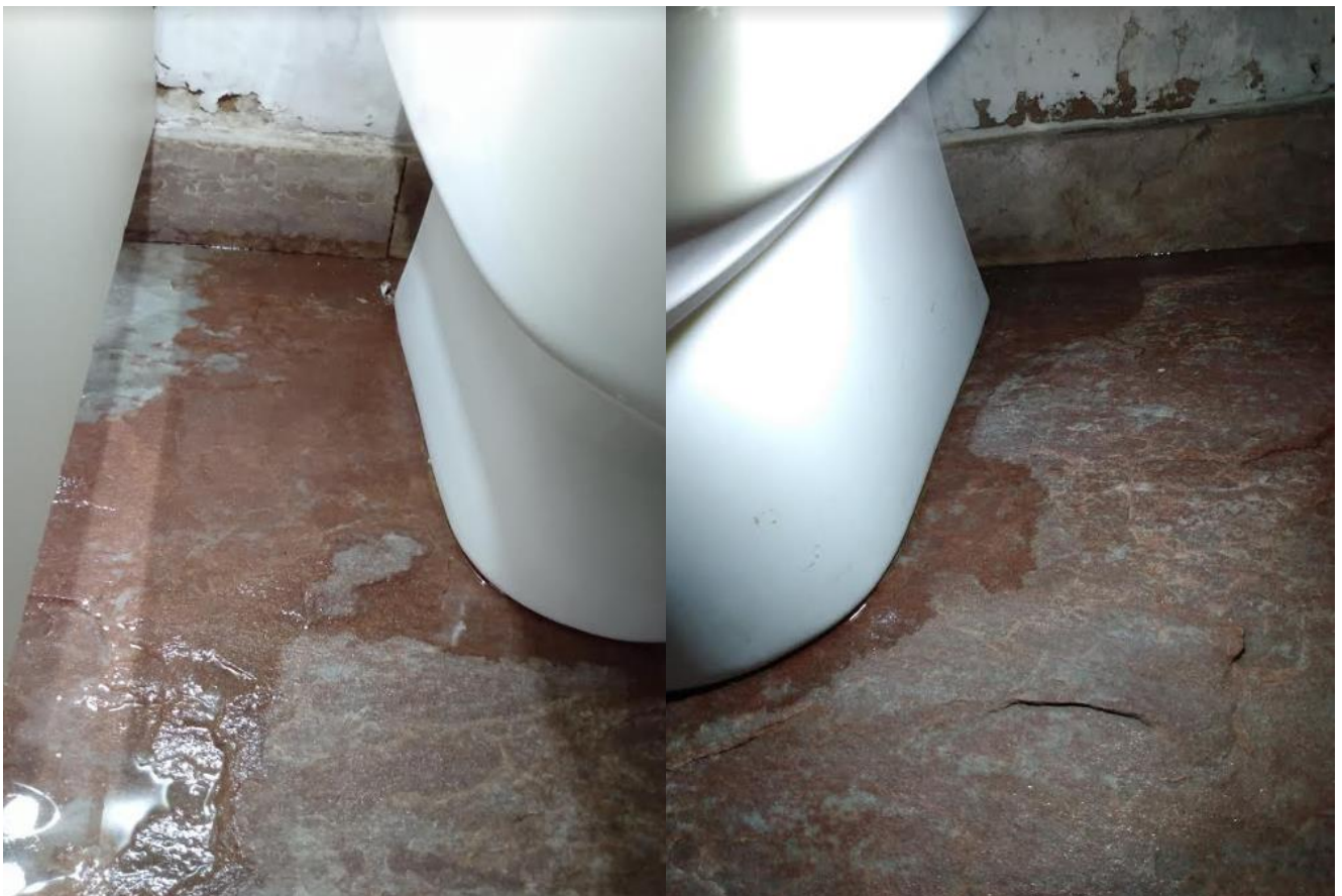
Fotos 149 e 150: Visão detalhada Cabine 01 – Feminino – Espude (vazamento, infiltração, desprendimento de reboco)
