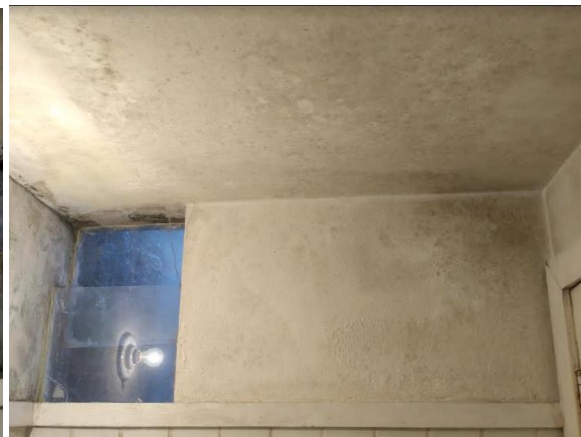
Fotos XX: Visão detalha Cabine 1 – masculino – Pontos de infiltração e mofo
