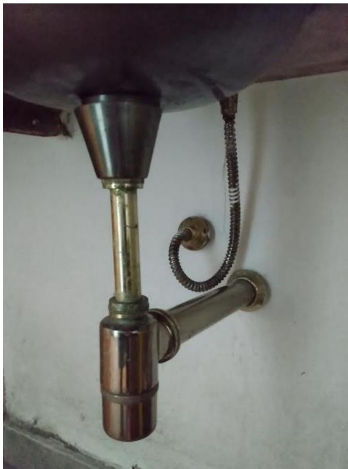
Foto 55: Visão detalhada Cabine 02 – feminino - Sifão
