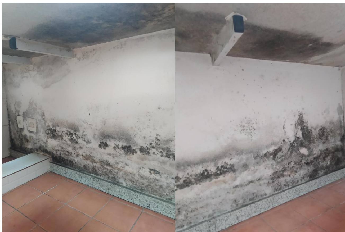
Foto XX: Visão detalhada – marca de infiltração e mofo - refeitório anexo II (infiltração oriunda de instalação de torneira na área da garagem)
