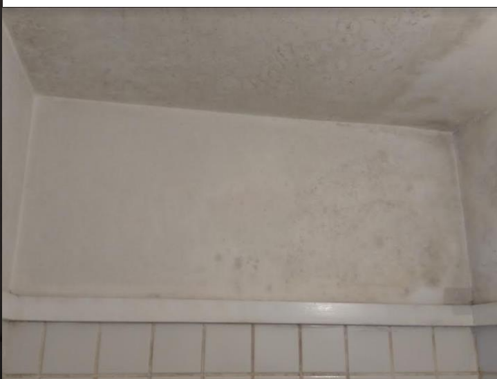
Fotos XX: Visão detalha Cabine 1 – masculino – Pontos de infiltração e mofo; rachaduras nos vidros
