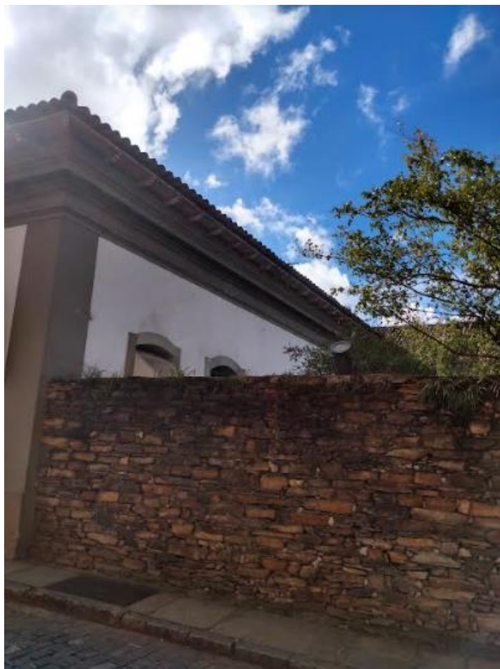
Foto XX: Visão geral - Fachada Externa Anexo I – Muro de pedra no qual se encontra, na parte interna, as instalações do banheiro do Anexo I – Ausência de calha na fachada e lateral esquerda do edifício do auditório
