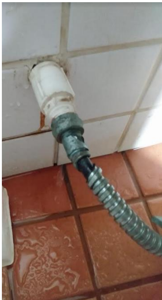
Foto 66: Visão Detalhada Cabine 1 – Masculino - Tubo de ligação com vazamento
