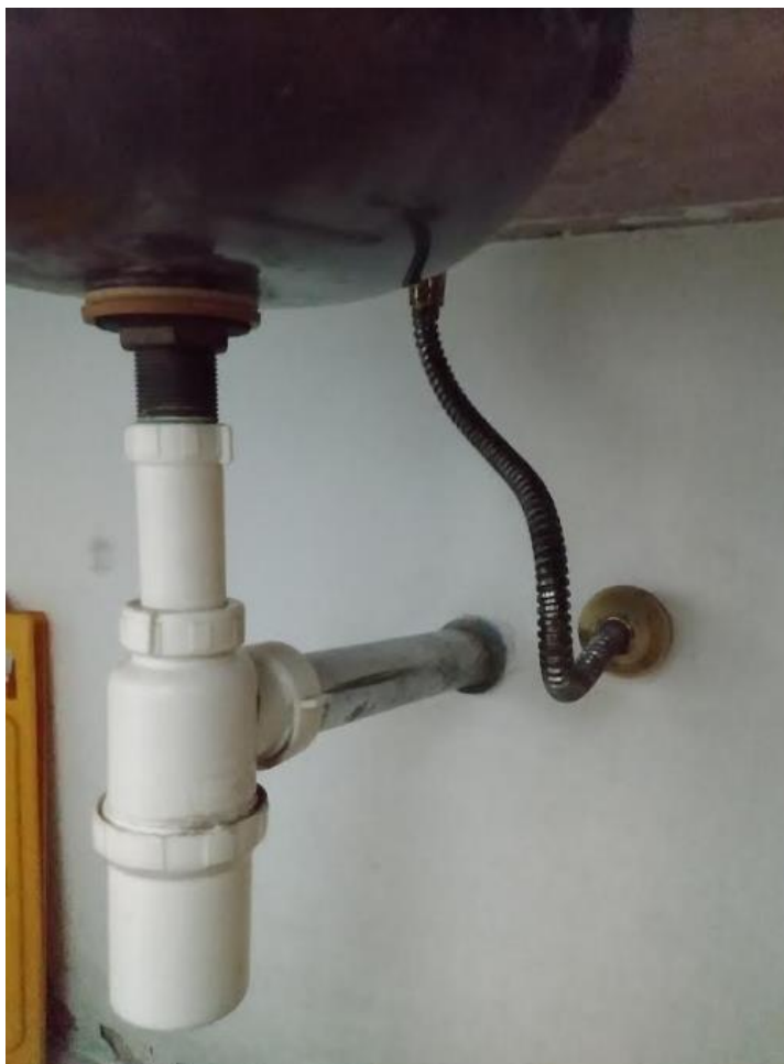
Foto 43: Visão detalhada Cabine 01 – Masculino – Sifão
