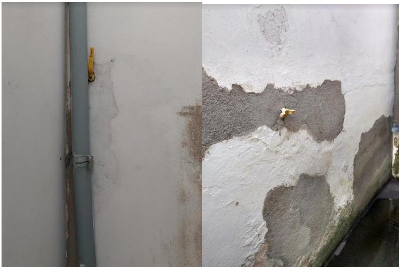
Foto XX: Visão geral - Corredor com marcas de infiltração nas paredes e desprendimento de reboco
