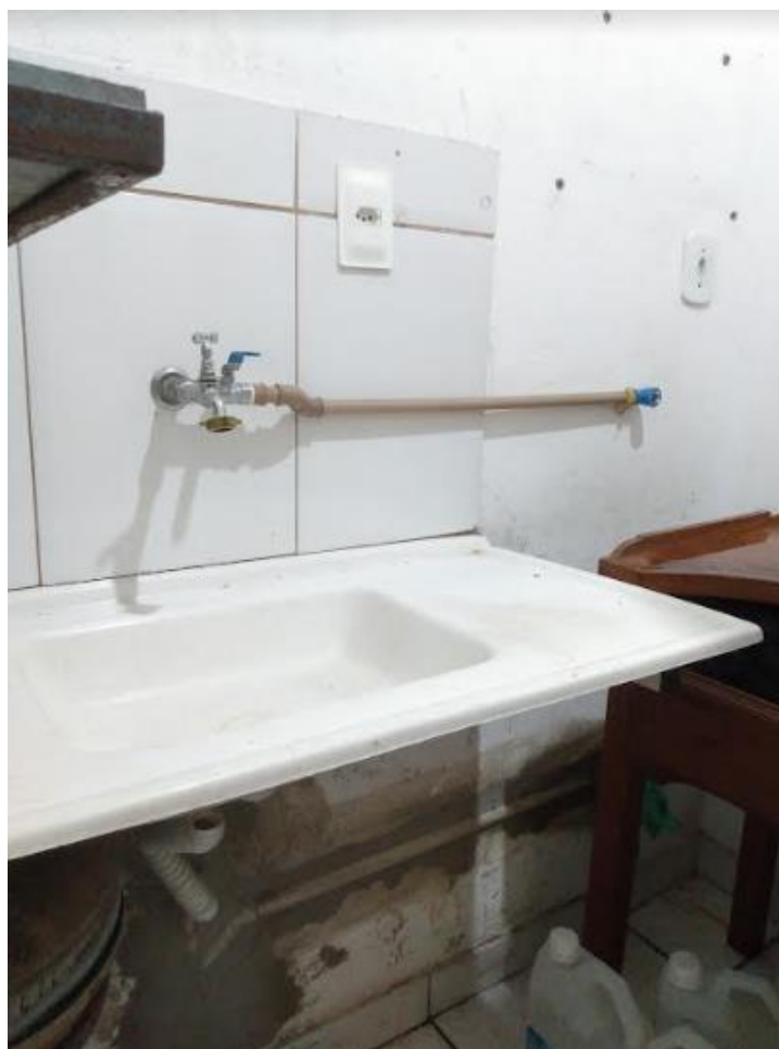
Foto XX: Visão detalhada - Pia área de limpeza, torneira e sifão (aparelho em desuso)
