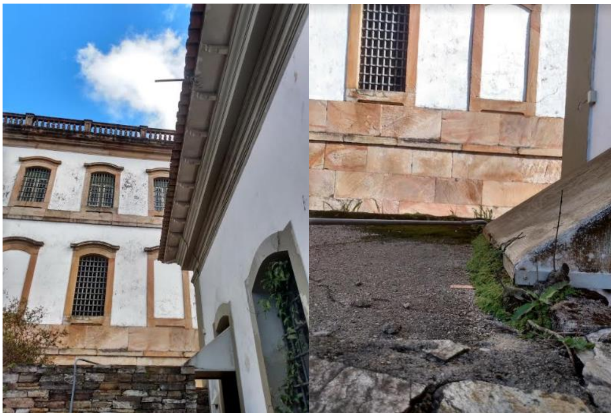
Fotos XX e XX: Visão detalhada – Ausência de calha no edifício do Auditório; Existência de toldo com desemboque sobre a laje da edificação do banheiro
