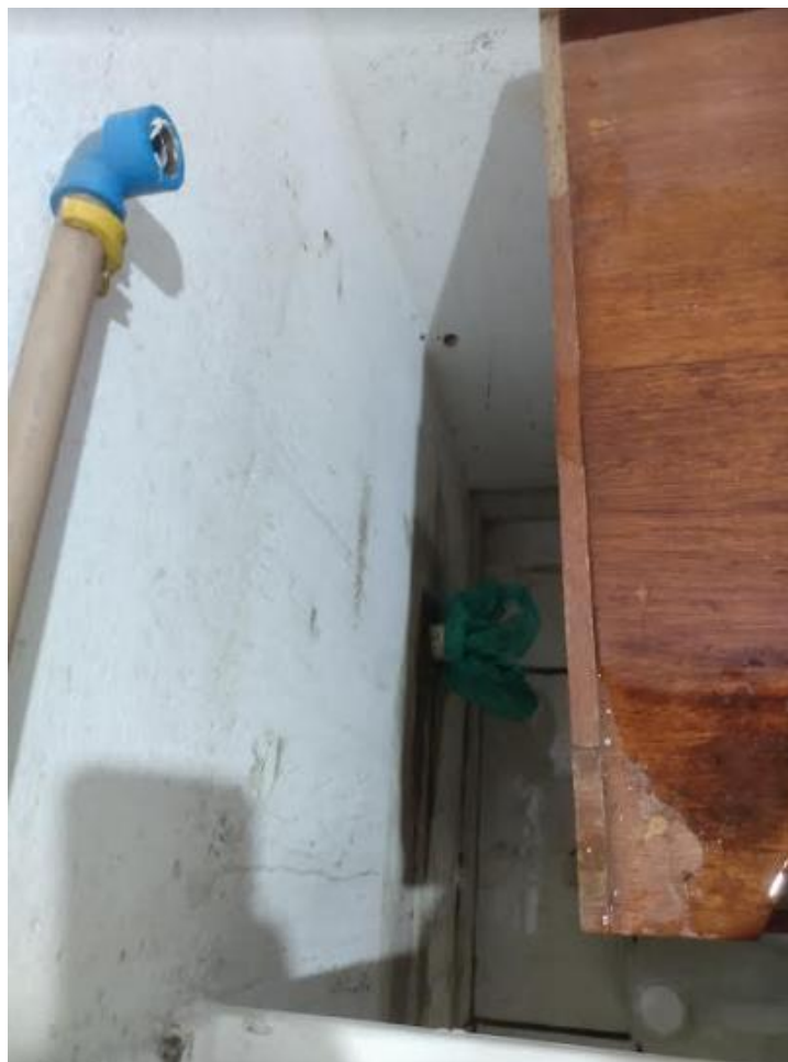
Foto XX: Visão detalhada canos com vazamento
