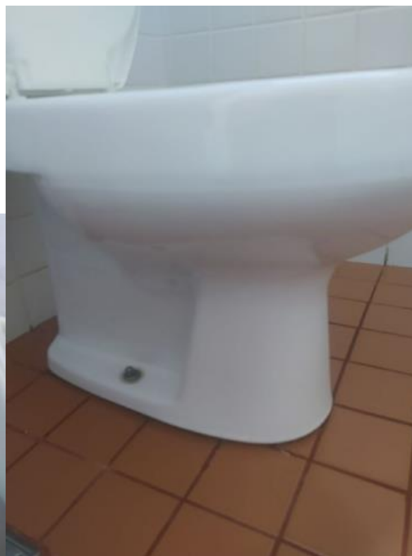
Fotos 129 e 130: Visão detalhada Cabine 02 – Feminino – Base do Vaso Sanitário (vazamento)
