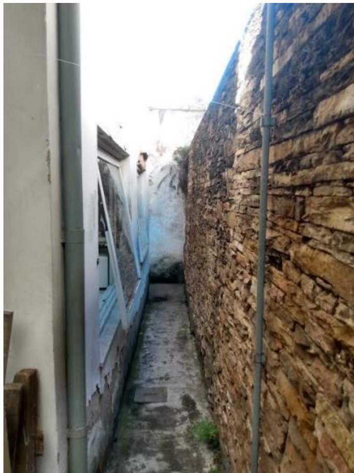
Foto XX: Visão geral - Corredor com marcas de infiltração nas paredes e desprendimento de reboco
