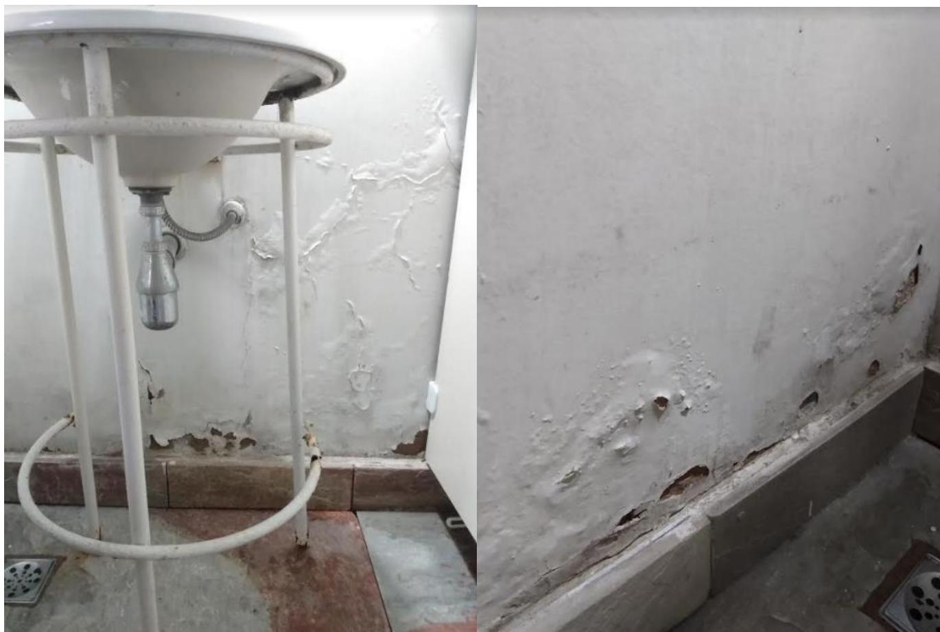
Fotos 160 e 161: Visão detalhada Cabine 01 – Feminino – Pontos de infiltração e desprendimento do reboco
