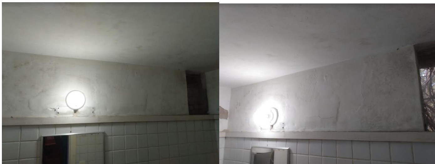
Fotos XX: Visão detalha Cabine 2 – feminino – Pontos de infiltração e mofo
