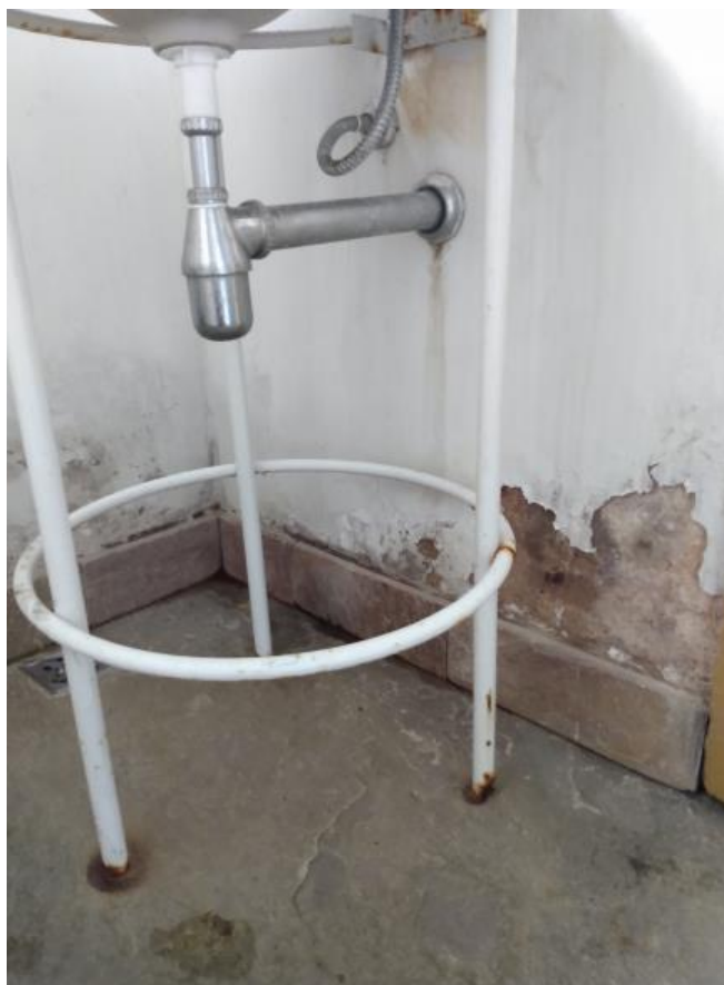
Foto 173: Visão detalhada Cabine 02 – Masculino – Ponto de infiltração e desprendimento do reboco
