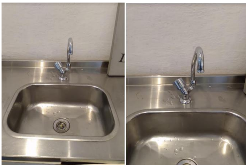
Visão Detalhada Pia e Torneira – Torneira apresenta frouxidão e está girando
