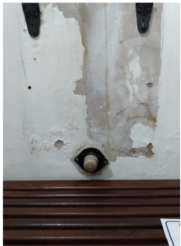
Fotos 23 e 24: - Visão detalhada Cabine 03 – registros desativados, ponto de descarga desativado e ponto de saída do antigo mictório desativado.
