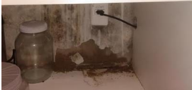
Fotos XX e XX: Visão detalhada - Sifão - Pontos de infiltração e desprendimento de reboco
