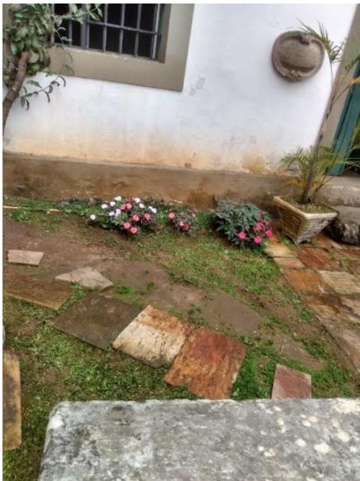
Foto XX: Visão detalhada – Ausência de marcas no solo causadas por queda d'água do ladrão
