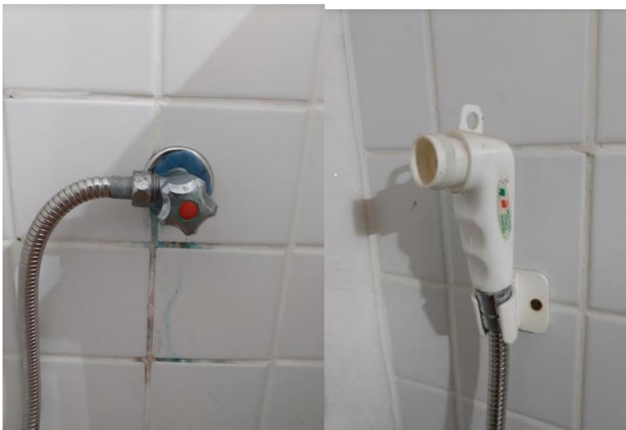
Fotos 106 e 107: Visão detalhada Cabine 02 - ducha higiênica danificada e apresentando vazamento
