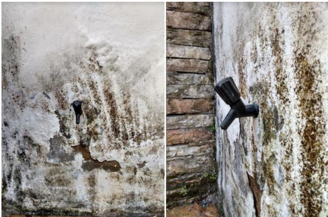
Fotos XX e XX: Visão detalhada – Pátio interno Anexo II – Torneira com infiltração
