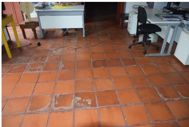
Figura 39 - Piso em lajotas de barro, térreo do MCHA. Foto: B. Fernandes, 2017.
