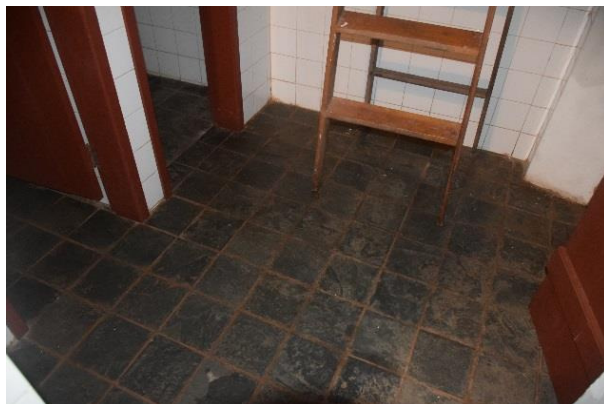
Figura 40 - Piso em ardósia, sanitários do MCHA. Foto: B. Fernandes, 2017.
