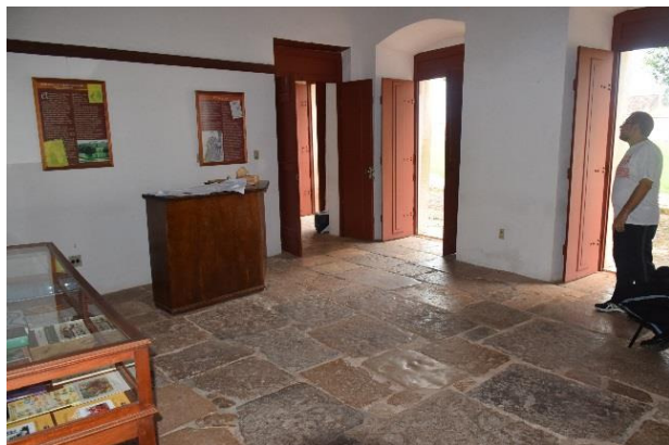
Figura 38 - Piso em lajões de lioz, térreo do MCHA. Foto: B. Fernandes, 2017.
