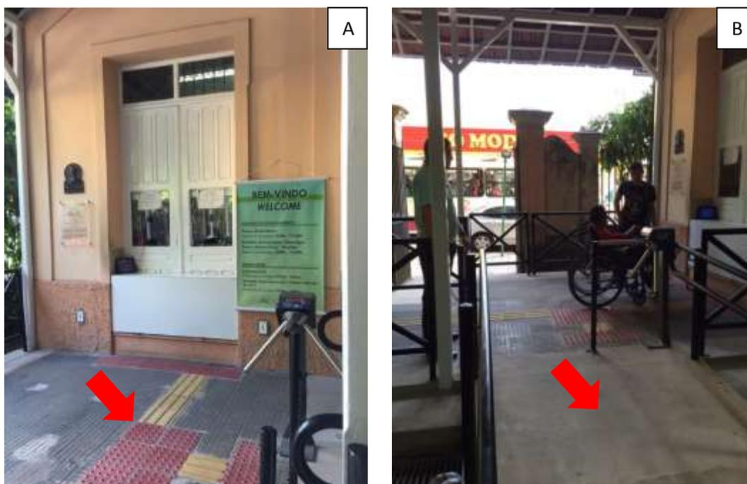
Figura 46 - A) Piso direcional para deficientes visuais; B) rampa com largura e declividade para maior acessibilidade de pessoas com restrições de mobilidade
