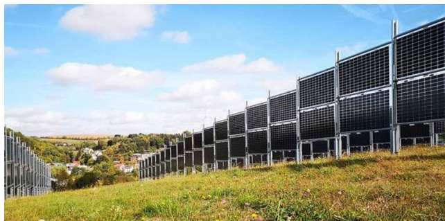
Figura 64 – Módulos FV bifaciais instalados verticalmente para aplicações como cercas
