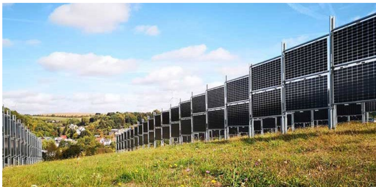
Figura 62 - Módulos fotovoltaicos bifaciais instalados verticalmente para aplicações como cercas
