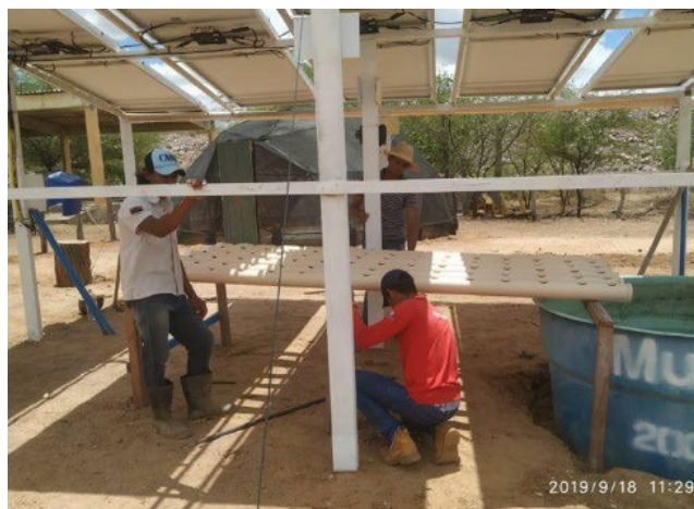
Figura 37 - Sistema agrivoltaico e montagem do sistema aquapônico abaixo dos módulos
