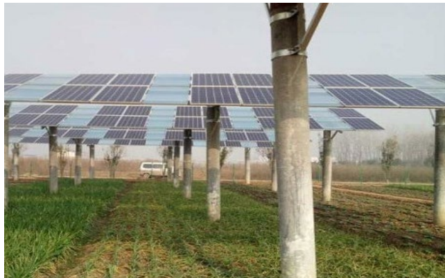
Figura 22 - Sistema agrivoltaico de iluminação uniforme (EAS), o novo projeto agrivoltaico chinês
