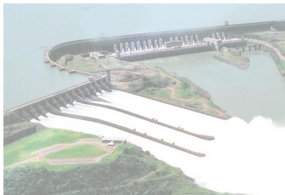
Usina Hidrelétrica de Itaipu (Itaipu Binacional/Divulgação)
