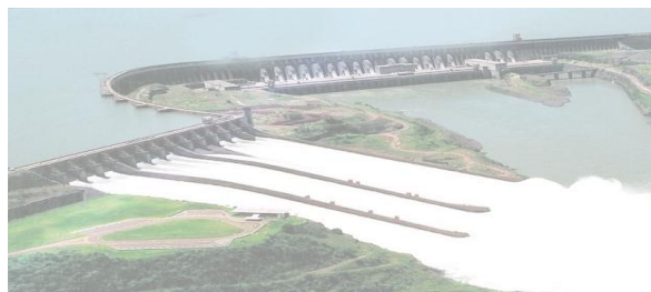
Usina Hidrelétrica de Itaipu (Itaipu Binacional/Divulgação)
