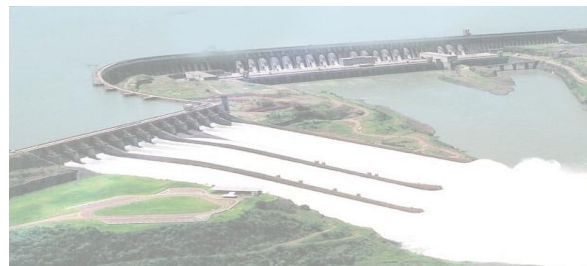
Usina Hidrelétrica de Itaipu (Itaipu Binacional/Divulgação)
