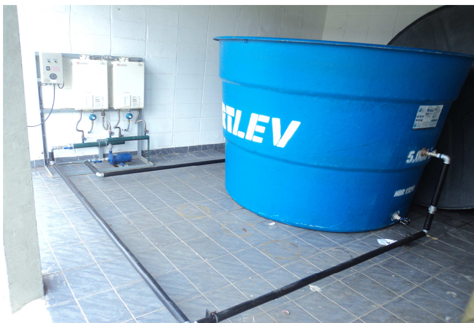
FOTO 15 – DETALHE DO SISTEMA DE AQUECIMENTO COM CIRCULAÇÃO DE ÁGUA ATRAVÉS DE UMA BOMBA EM UMA CAIXA DE ÁGUA
