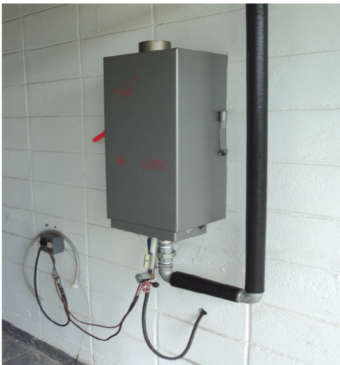
FOTO 05 – PAINEL DE COMANDO DA SAUNA QUEIMADORES
