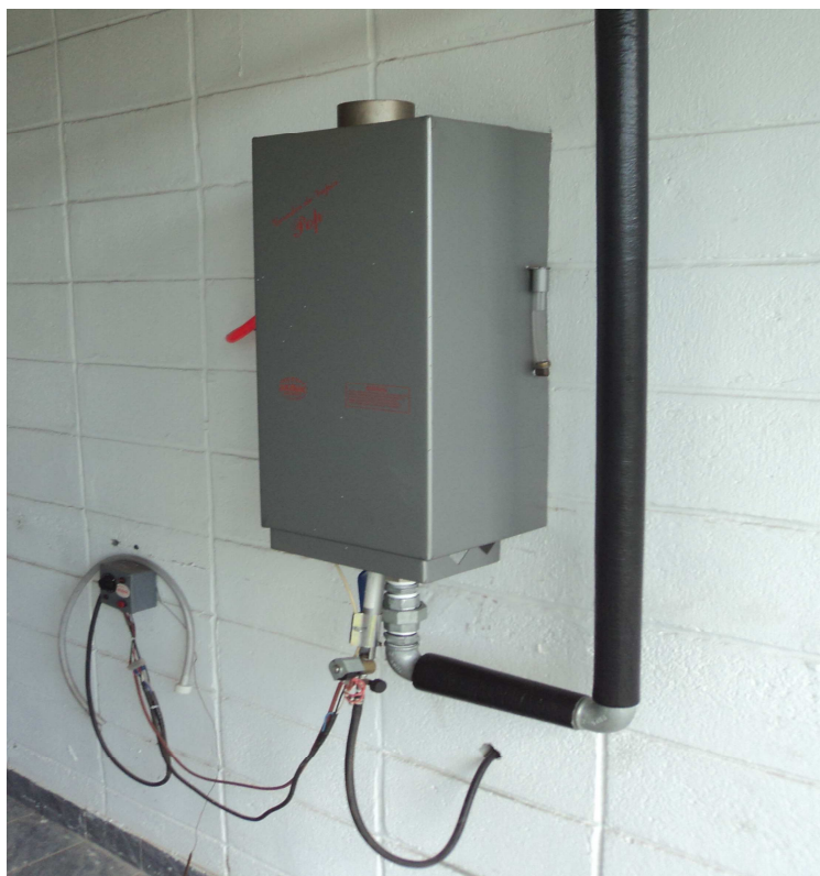
FOTO 23 – PAINEL DE COMANDO DA SAUNA QUEIMADORES
