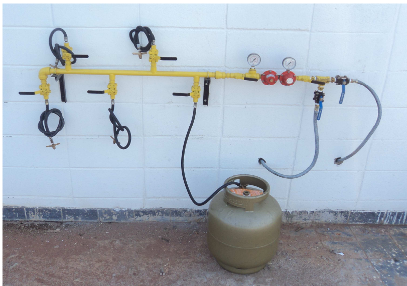
FOTO 12 – ALIMENTAÇÃO DO AQUECEDOR DE PISCINA
