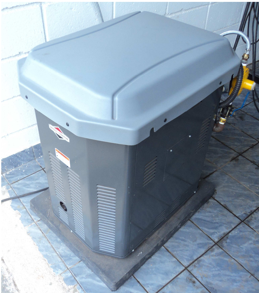
FOTO 04 – DETALHE DO GERADOR DE ENERGIA COM REGULADOR DE BAIXA PRESSÃO AMARELO
