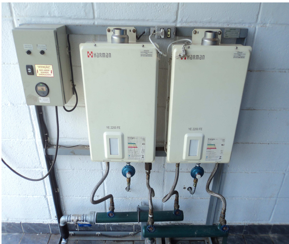
FOTO 14– DETALHE DO AQUECEDOR UTILIZADO SOMENTE O DA ESQUERDA DE BAIXA PRESSÃO COM REGULADOR DE PRESSÃO AZUL
