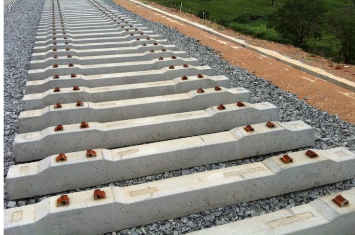
DORMENTE CONCRETO MONOBLOCO
