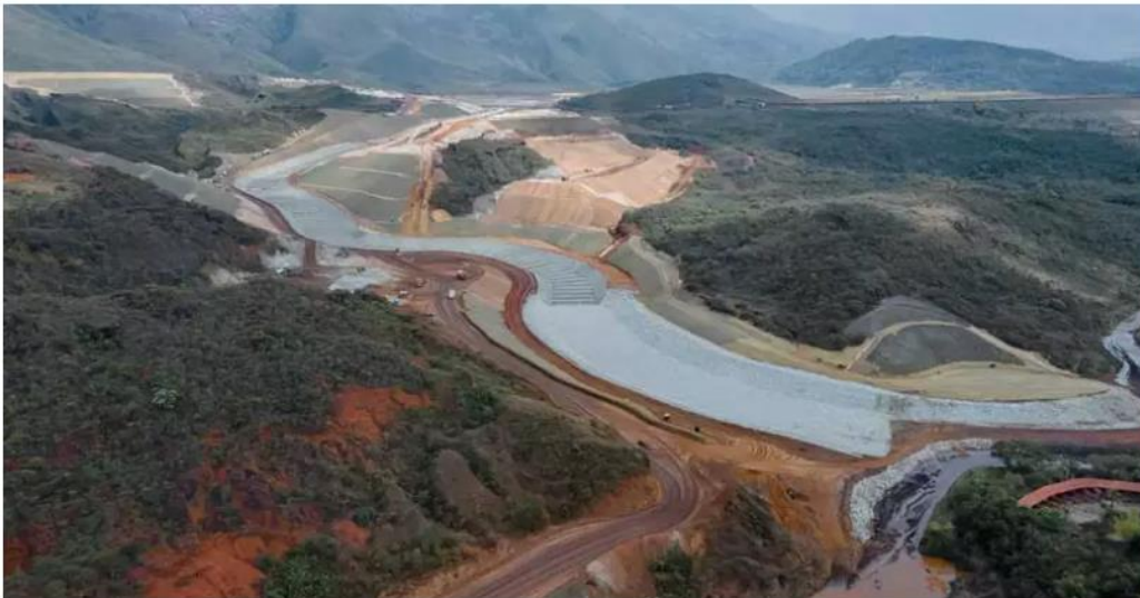
Vertedouro vai auxiliar na drenagem da estrutura, principalmente na época da chuva, evitando acúmulo de água e colaborando para a continuidade da eliminação do reservatório (foto: Vale/Divulgação)
