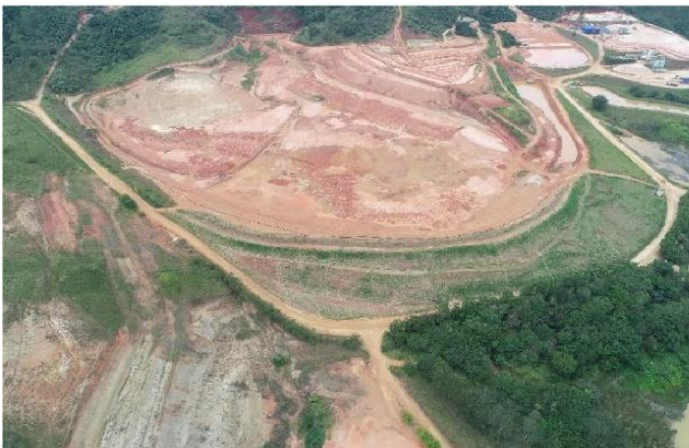
Fig 5. Barragem em fase de descaracterização na unidade ITA10, em Santa Isabel/SP
