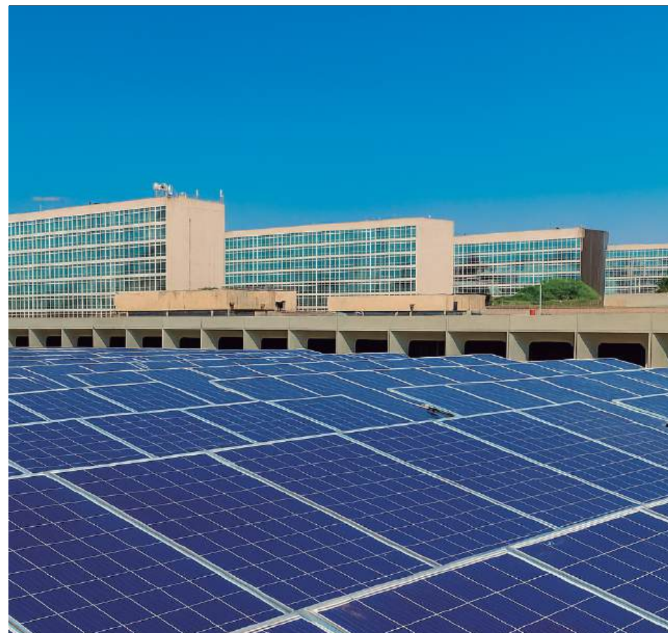
Figura 2.2 ■ Usina solar fotovoltaica do edifício do Ministério da Defesa, com mais de 1.600 painéis solares. Fonte: Portal Gov.br.
