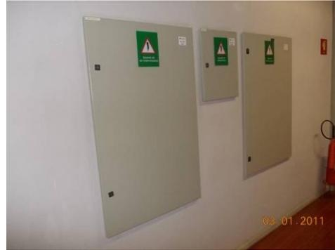
**Figura 1.11** – quadros de distribuição localizados nos pavimentos
