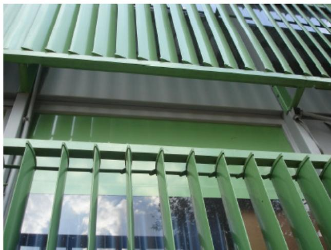
Figura 5 – *Brisés* verticais instalados na fachada Oeste.
