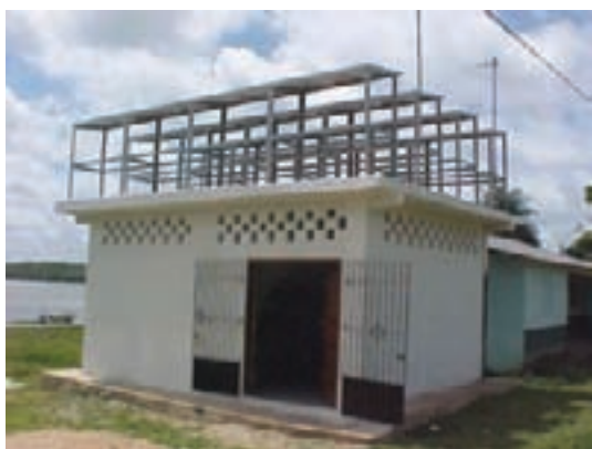
Casa de força e arranjo fotovoltaico sobre a mesma
