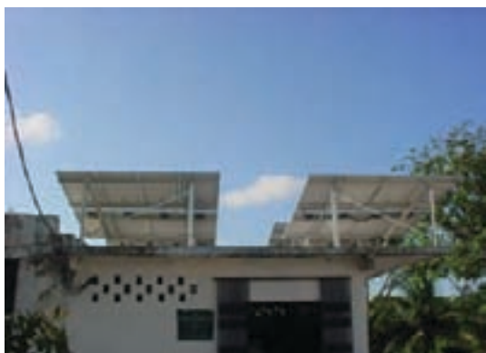
(a) Arranjo fotovoltaico sobre a casa de força
