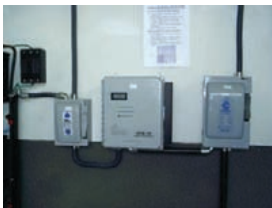
Chaves dos sistemas renováveis nas extremidades e retificador ao centro
