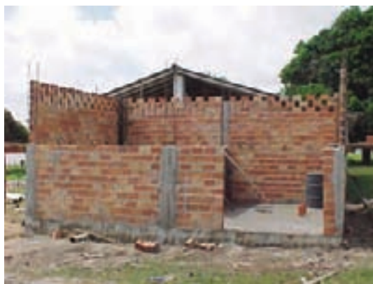
Casa de força em construção
