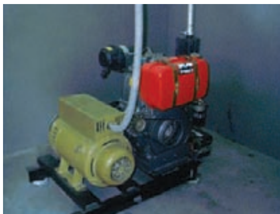
Figura 9.22 – Grupo gerador a diesel de 20 kVA sem sistema de controle
