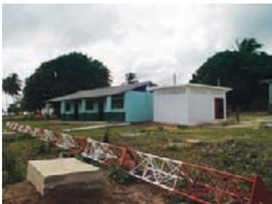
Torre do aerogerador montada no chão
