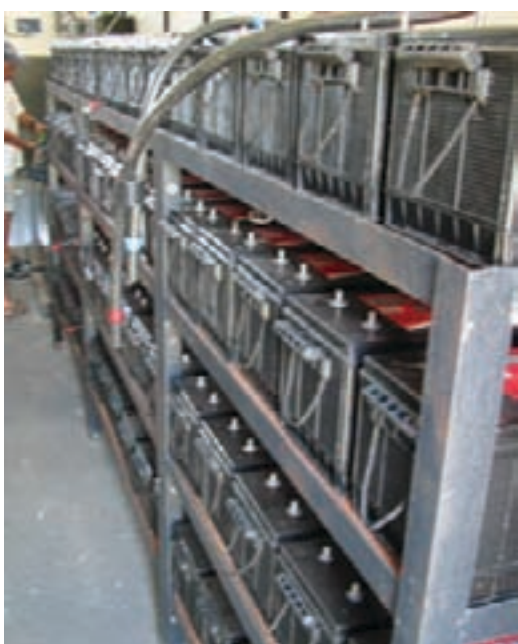
Banco de baterias sendo montado
