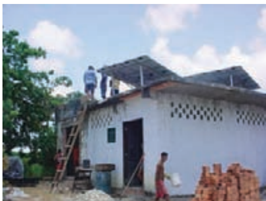
Casa de força sendo reformada (revitalização)
