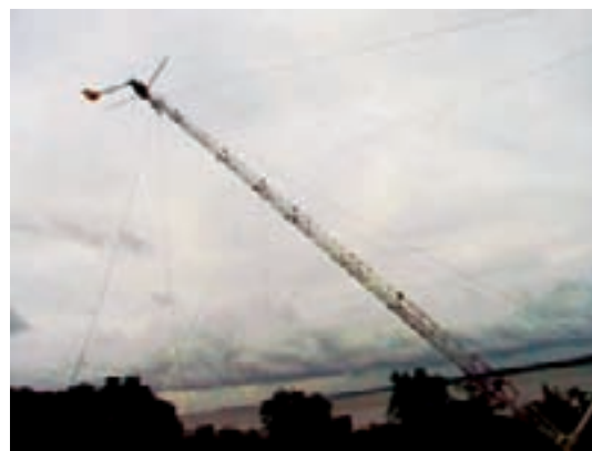
Conjunto aerogerador e torre sendo erguido
