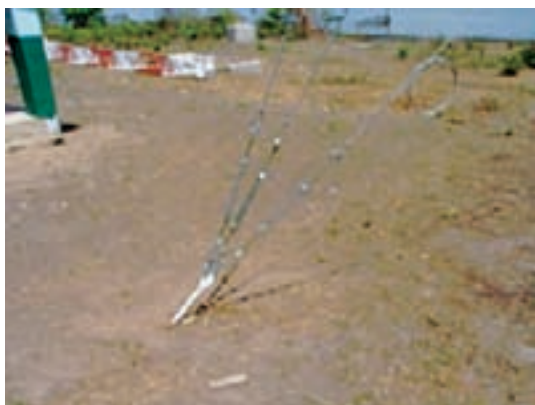
Cabos de sustentação da torre fixados nas âncoras por meio de esticadores
