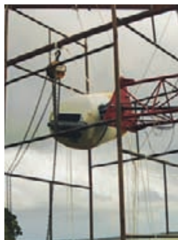
Aerogerador sendo montado no topo da torre
