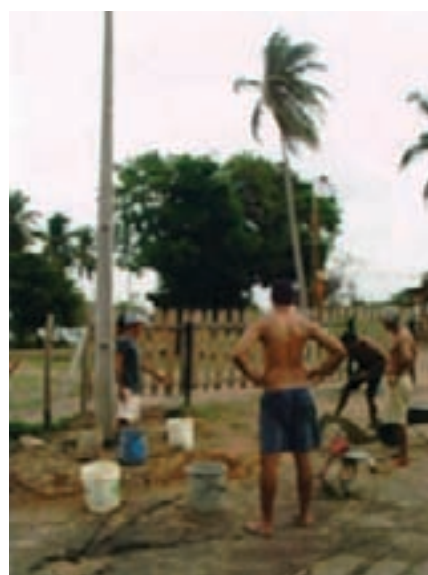
Fixação dos postes de concreto feita pelos moradores locais
