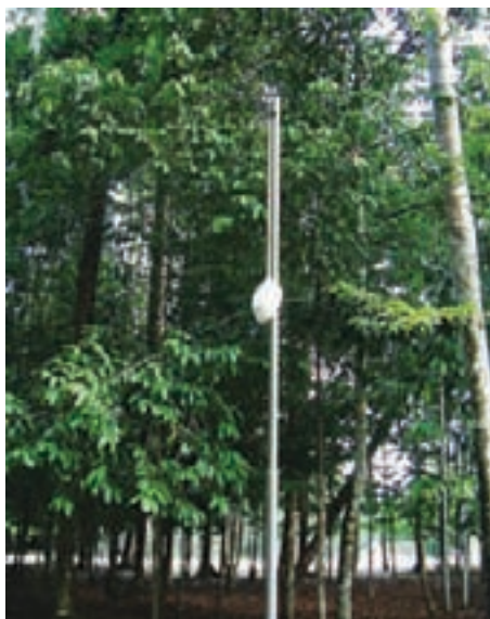
Figura 10.9 – Poste com braço da luminária danificado
