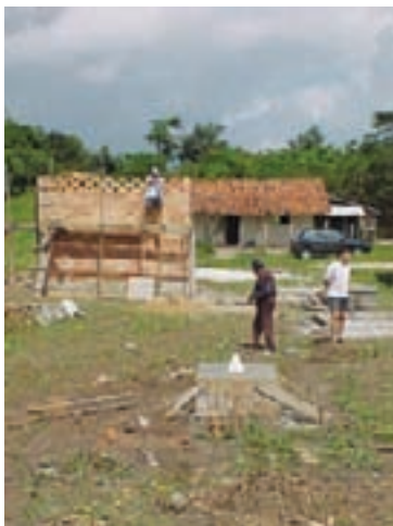
Casa de força, sendo construída e preparação das bases da torre do aerogerador
