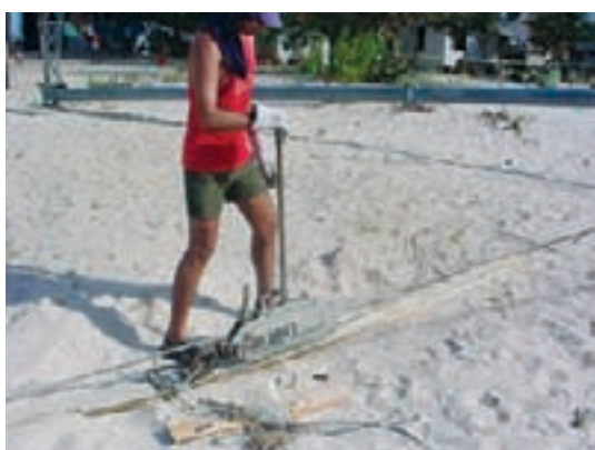
Tífor utilizado para abaixar e erguer o conjunto torre/aerogerador
