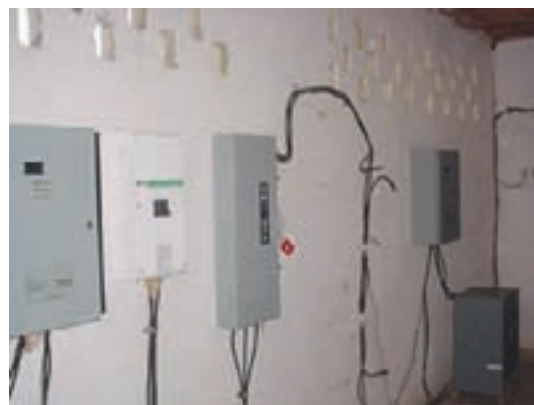
Chaves de proteção e retificadores da (configuração antiga)
