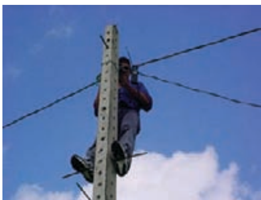
Instalação do cabeamento da minirrede de distribuição
