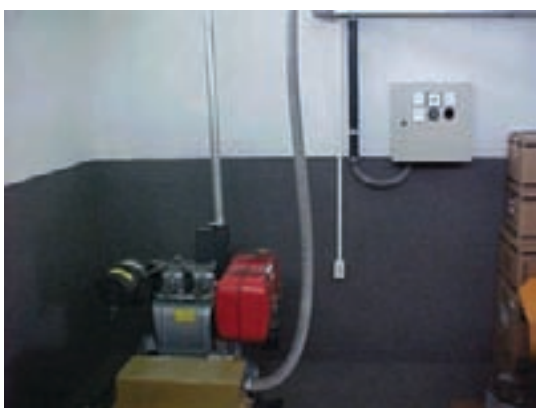
Grupo gerador a diesel e quadro de monitoração
