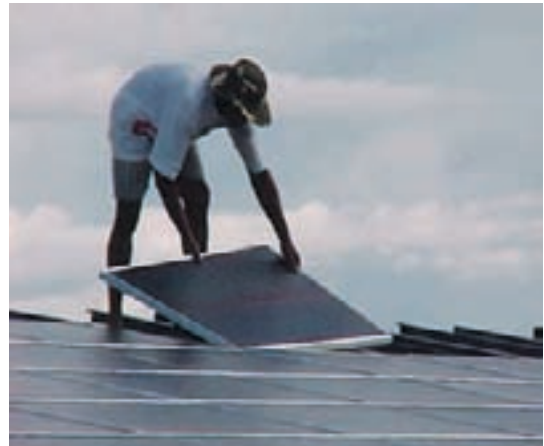
Montagem do arranjo fotovoltaico
