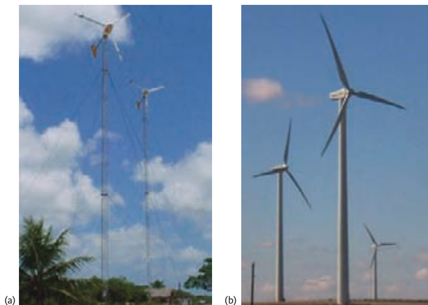
Figura 3.37 – Torres: (a) treliçadas; (b) tubulares
