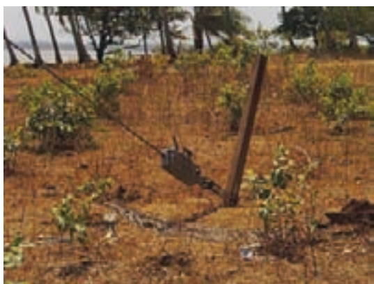
Tifor utilizado para o erguimento da estação
