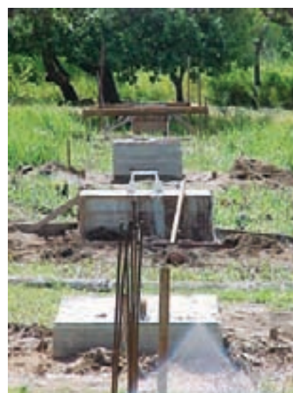
Bases da torre do aerogerador
