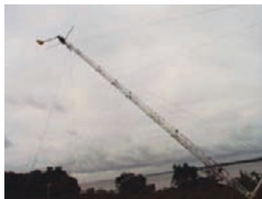
(e) Içamento do conjunto torre/aerogerador
