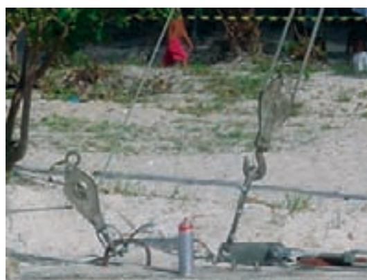
Roldanas utilizadas para redução de esforços
