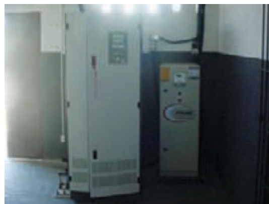
Inversor/retificador ao lado da USCA
