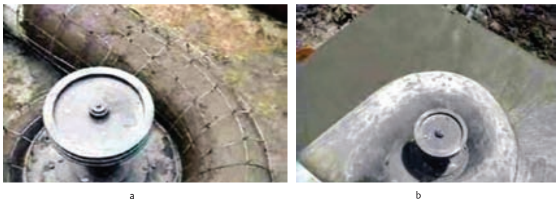
Figura 2.18 – Construção da caixa espiral pelo método “argila-perdida”: (a) molde em barro com armadura de ferro; (b) turbina com a caixa espiral já concretada.
