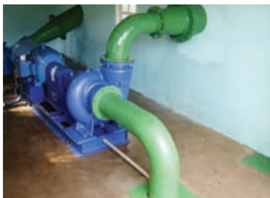
Figura 2.11 – Turbinas Hidráulicas desenvolvidas pela Unifei: (a) Michell-Banki e (b) Bomba Funcionando como Turbina – BFT
