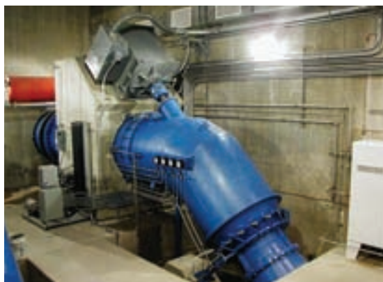
Figura 2.10 – Turbina Bulbo: (a) com rotor de pás móveis, gerador interno, a montante, sendo inspecionada na fábrica; (b) tipo tubular com acoplamento do gerador a jusante, em operação.
