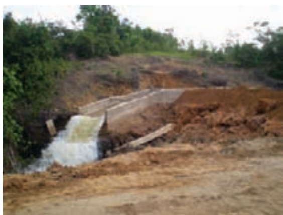
Figura 9.33 – Barragem em fase final, com a água já passando pelo vertedouro
