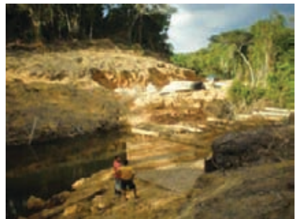
Figura 9.28 – Vista da área do futuro reservatório
