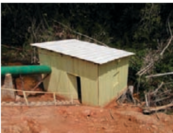
Figura 9.38 – Vista da casa de máquinas
