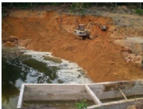
Figura 9.32 – Construção da barragem de terra
