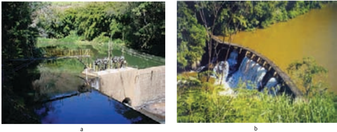
Figura 2.4 – Barragens: (a) da PCH Luiz Dias; (b) da PCH Piedade
