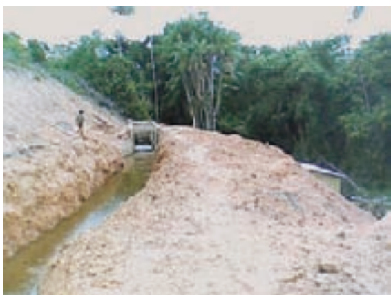
Figura 9.37 – Trecho final do canal de adução, com câmara de carga ao fundo
