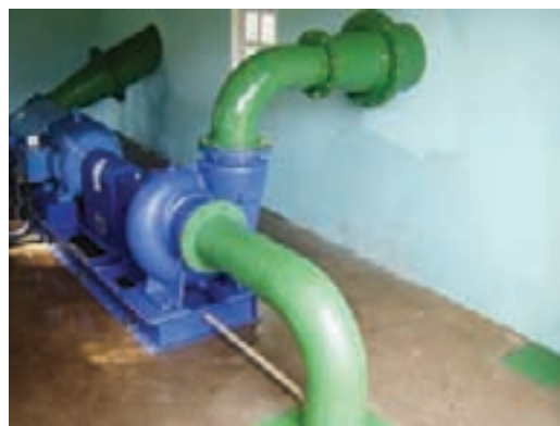
Figura 2.27 – Aspecto de um grupo gerador com BFT: (a) a BFT sendo instalada; (b) a BFT em operação
