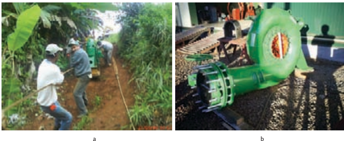
Figura 9.61 – (a) Vista da turbina sendo levada até a casa de máquinas; (b) Vista da turbina
