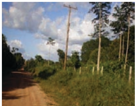
Figura 9.30 – Trecho da linha de distribuição em construção
