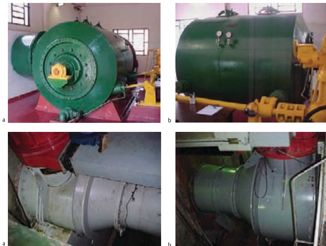
Figura 2.18 – Turbina Francis em caixa cilíndrica PCH Ponte Alta: (a) vista lateral; (b) vista frontal; (c) e (d) PCH Aripuanã, fabricação Neyrpic
