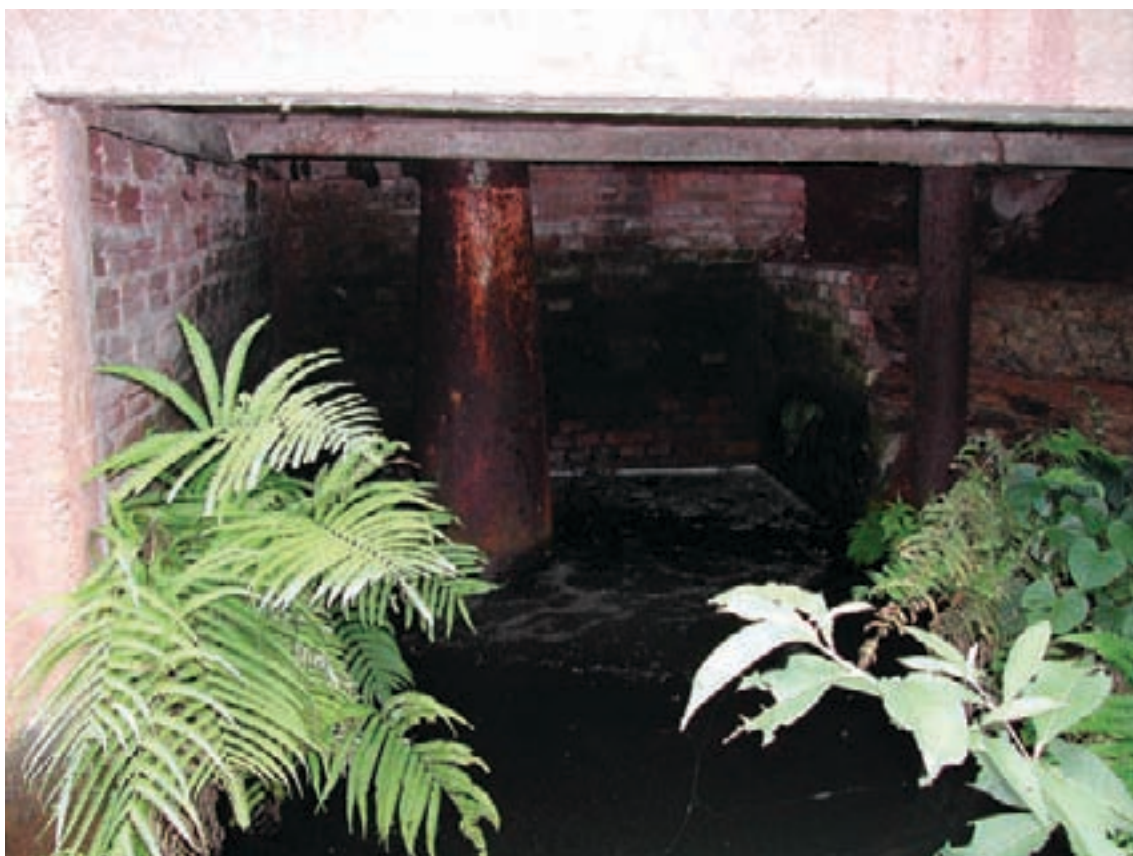
Figura 9.63 – Canal de fuga e tubo de sucção
