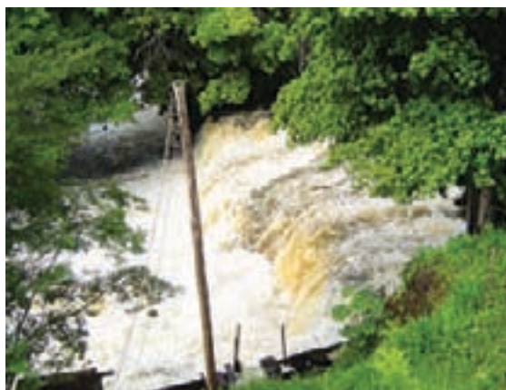
Figura 9.46 – Cachoeira do Aruã Vista jusante
