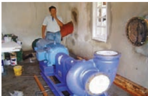
Figura 2.27 – Aspecto de um grupo gerador com BFT: (a) a BFT sendo instalada; (b) a BFT em operação
