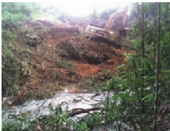
Figura 9.27 – Início da limpeza da área da barragem e chegada da estrada de acesso
