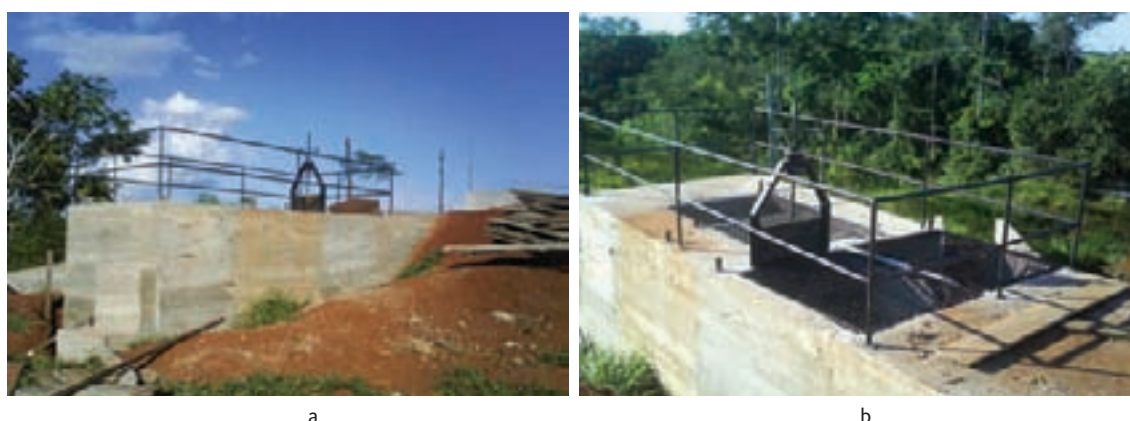
Figura 9.59 – (a) Vista da tomada d'água construída; (b) e em detalhe
