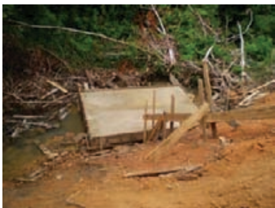
Figura 9.31 – Base da casa de máquinas concretada
