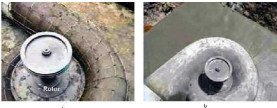
Figura 2.32 – Construção da caixa espiral pelo método “barro-perdido”: (a) molde em barro com armadura de ferro; (b) turbina com a caixa espiral já concretada
