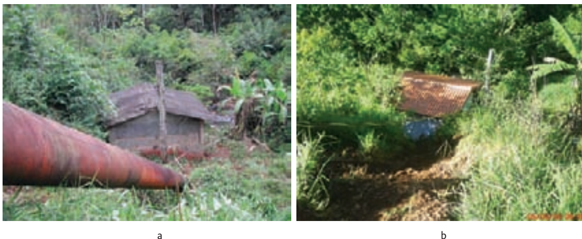
Figura 9.62 – (a) Vista da casa de máquinas existente; (b) Vista da nova casa de máquinas
