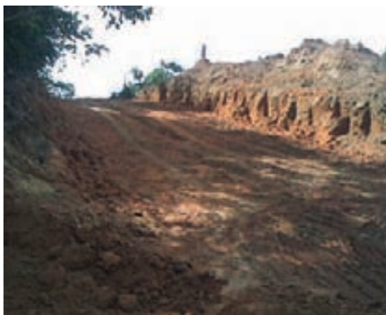
Figura 9.29 – Estrada de acesso na fase final
