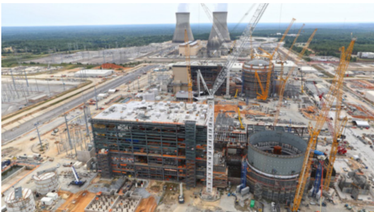
Figura 7 – Reatores Vogtle 1 e 2 em operação e Vogtle 3 e 4 em construção – Foto cortesia da empresa Southern Company
