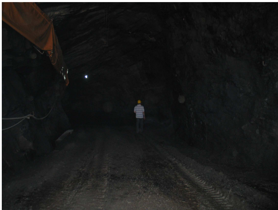
Figura 10.5 - Vista interna do túnel de mineração esmeralda – Mina Belmont.
