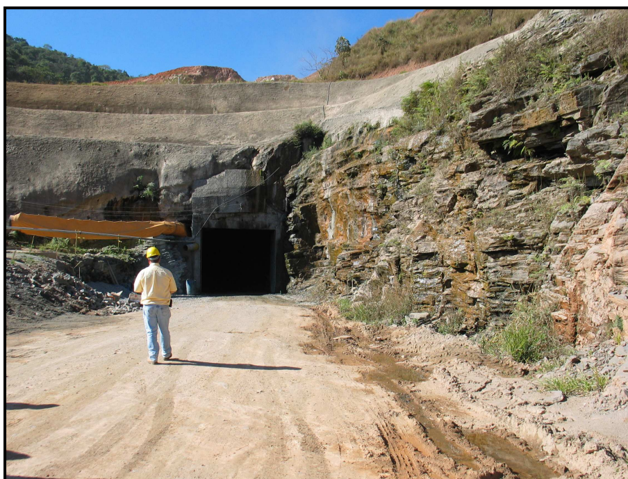
Figura 10.3 – Entrada de túnel, o qual permite trânsito de caminhões utilizados na retirada de minério – Mina Belmont.
