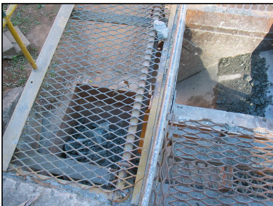
Figura 10.7 – Despejo em caçamba de minério retirado da Mina Belmont.
