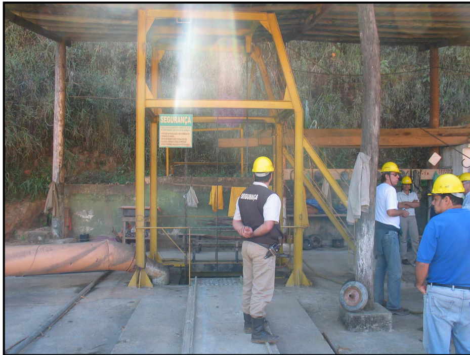
Figura 10.4 – Vista do poço elevador – Mina Belmont.
