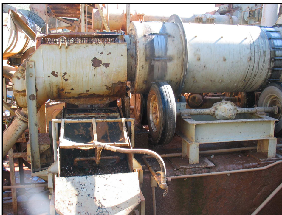
Figura 10.11 - Tromel no final da peneira primária e uma peneira secundária- Mina Belmont.
