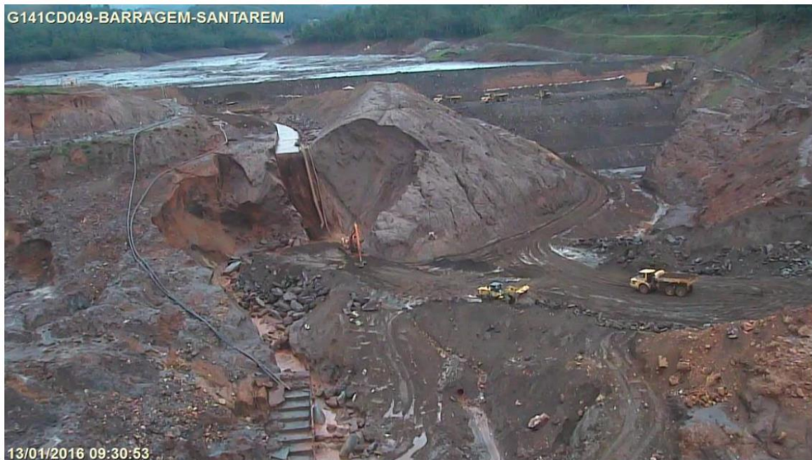
Figura 11 - Obras de reforço da estrutura na Barragem de Santarém
