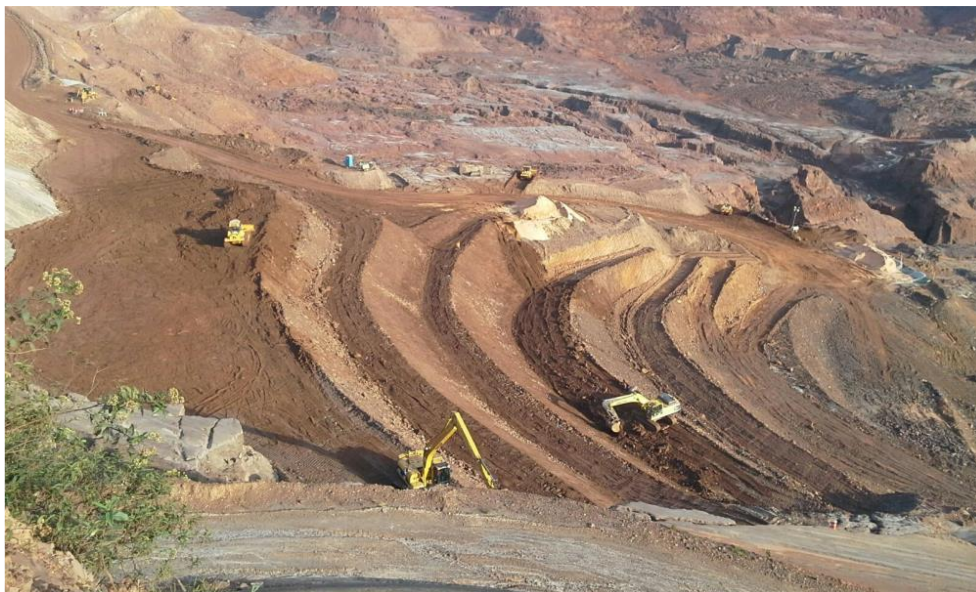
Figura 10 - Conclusão das obras no dique da Selinha (Fonte: Samarco)
