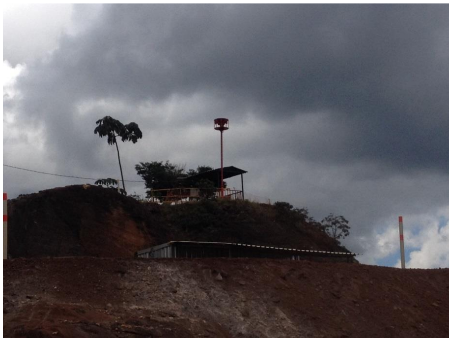
Figura 12 - Sistemas de sirenes instaladas na barragem de Germano
