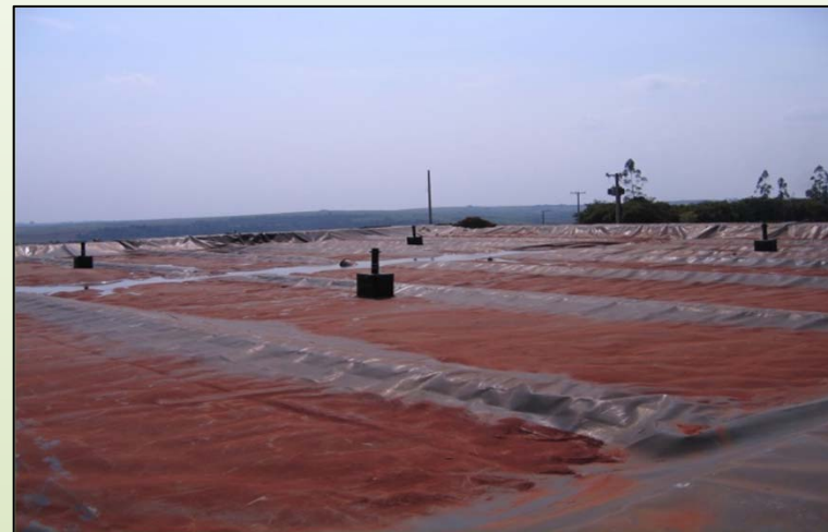
Lonas sendo instaladas para o biodigestor tubular na Usina Ester, Cosmópolis.
