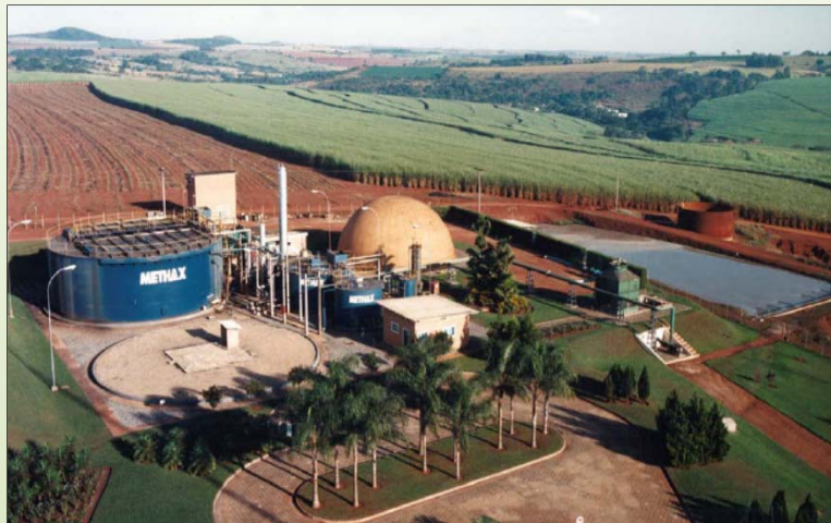
Planta de biodigestão anaeróbia de vinhaça da Usina São João, São João da Boa Vista.
