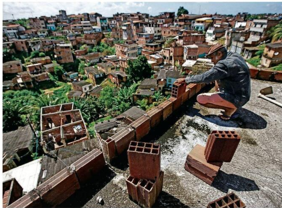
Antônio João dos Santos, 64, reforma sua casa na periferia de Salvador; auxílio emergencial movimenta pequena construção civil no Nordeste Raul Spinassé/Folhapress
