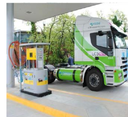
LNG filling station – Piacenza
