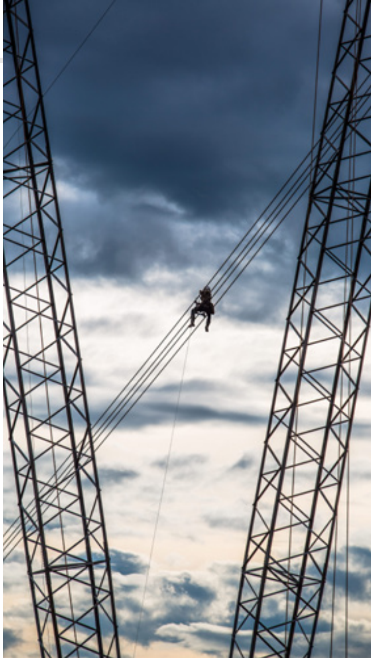
RECUPERAÇÃO DE TORRES DE TRANSMISSÃO – LT FOZ DO IGUAÇU-IVAIPORÃ (PR)
