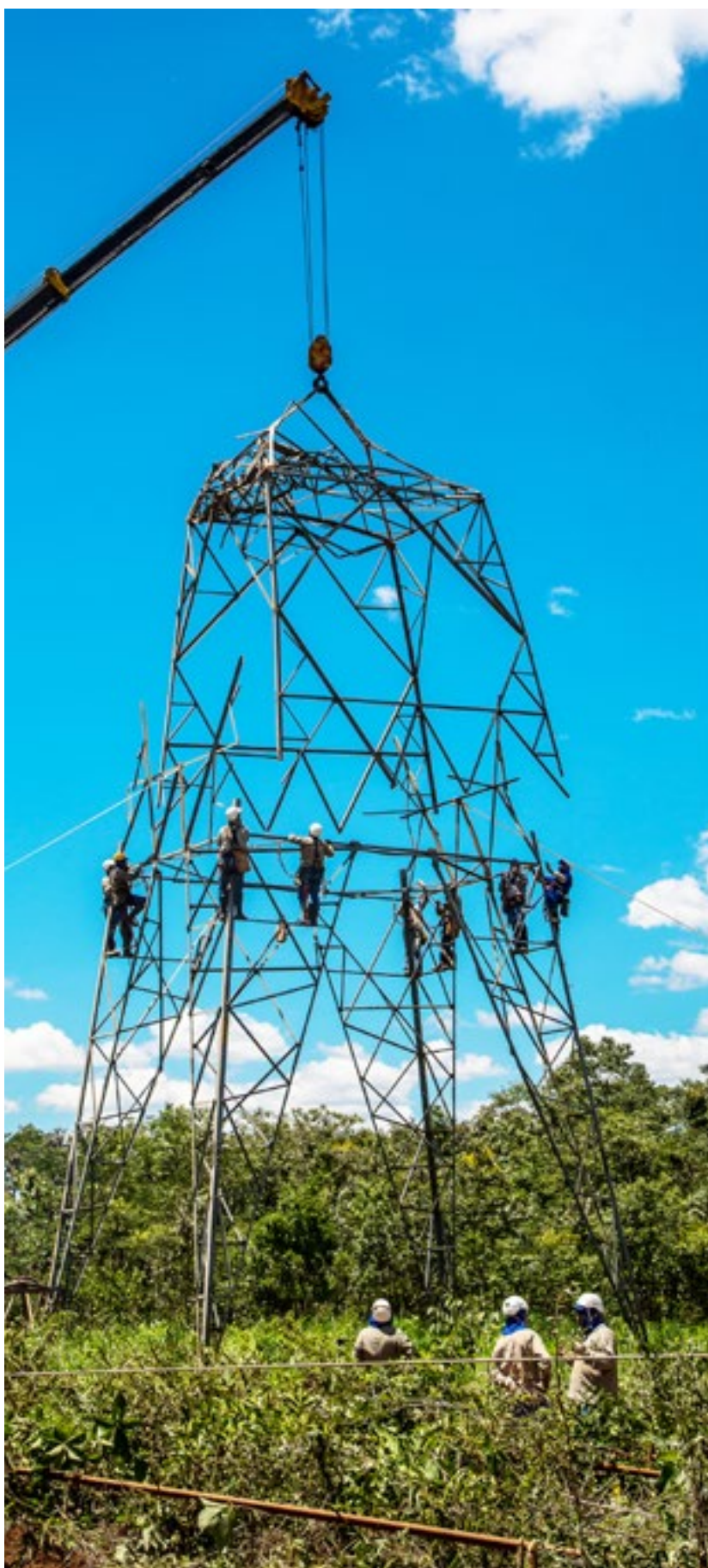
Recuperação de Torres - LT Itumbiara-Porto Colômbia (MG)
