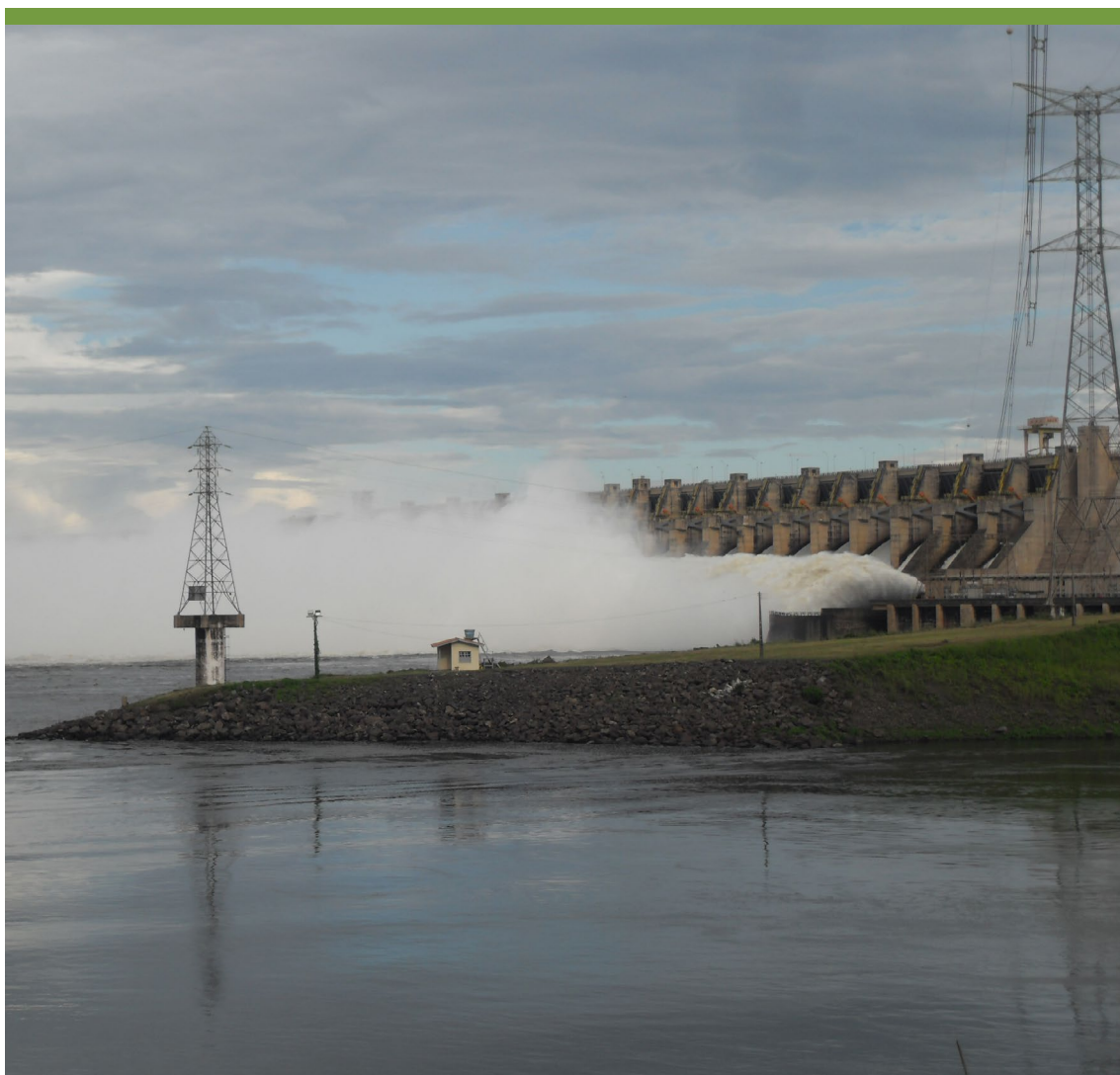
Usina Hidrelétrica de Tucuruí/PA. Foto: Diego Pereira
