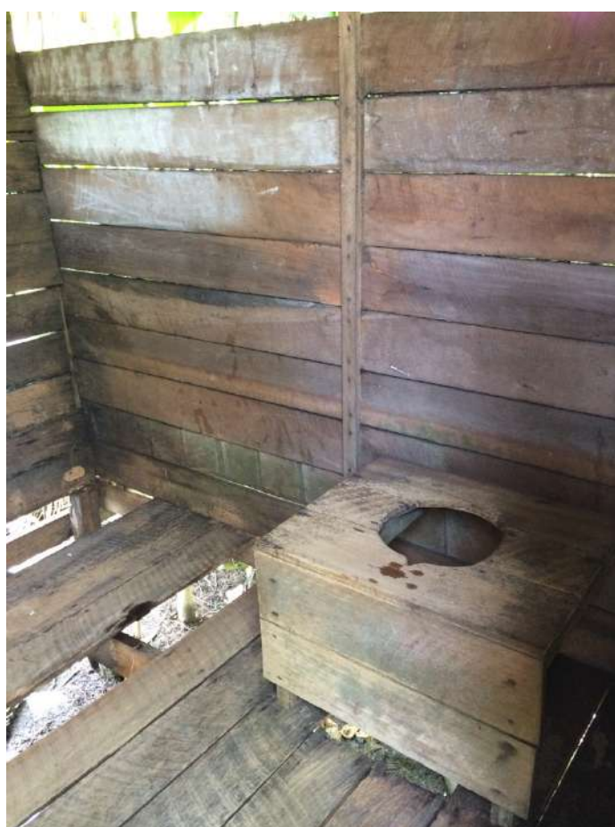
Foto 8. Forma de esgotamento sanitário direto no solo, em SPU em Limoeiro do Ajuru (PA)
