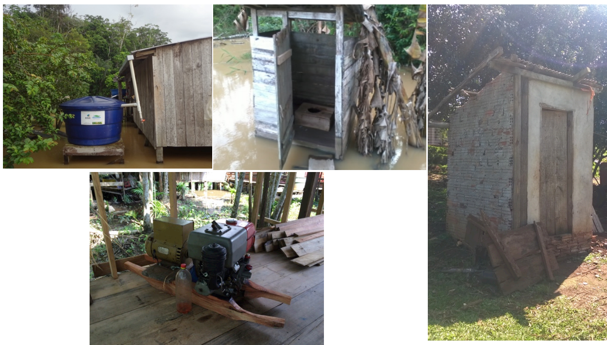
Figura 6. Infraestrutura e acesso a serviços básicos em algumas UTs. A. Captação de água da chuva em território ribeirinho; B. Falta de esgotamento sanitário, com descarte direto na água em Resex Médio Purus/AM; C. Banheiro com fossa rudimentar construído fora do domicílio; D. Gerador como fonte de energia.
