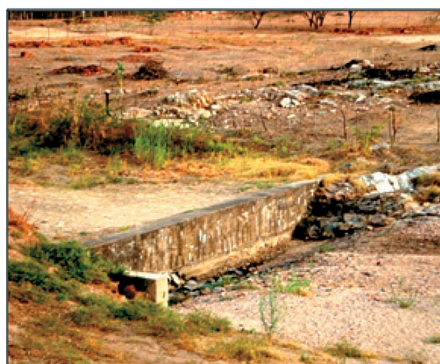
Figura 2.14: Processo de assoreamento na barragem do perímetro irrigado do Sabugi, município de Caicó.
