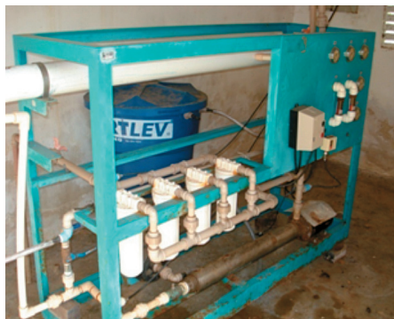
Figura 2.1: Dessorizador implantado na comunidade Barra da Espingarda
