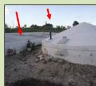
Detalhe da cisterna (calçadão e bomba).
