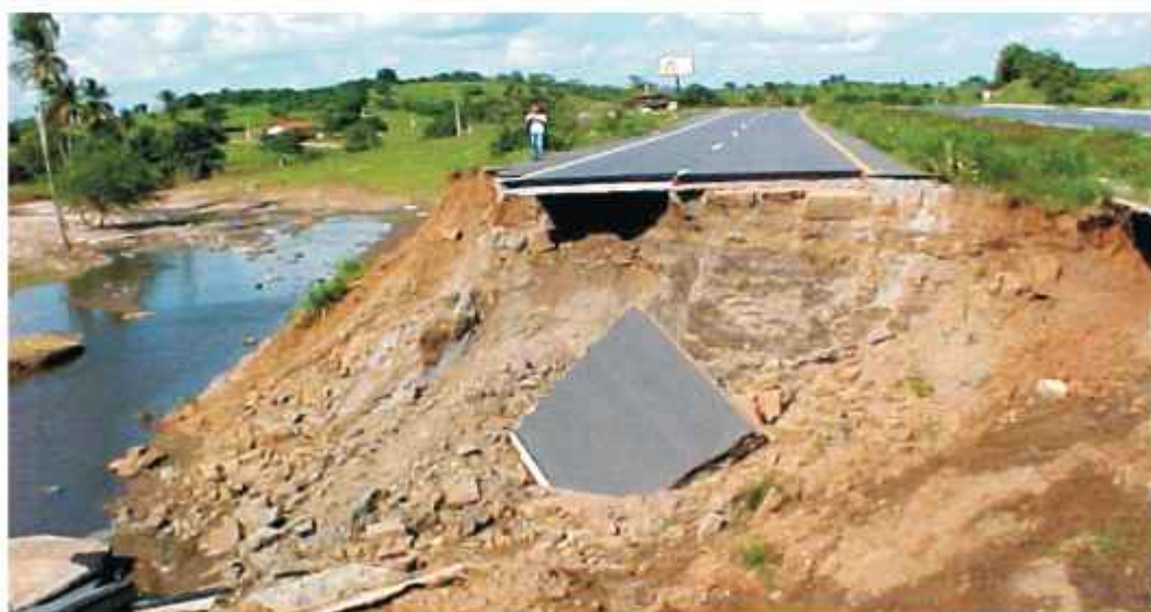
Foto 2 – Rompimento de duplicação da BR 230 proximidades de Riachão de Bacamarte/PB.
