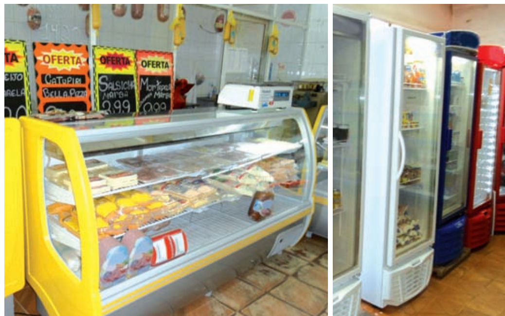
Balcões frigoríficos em supermercados, padarias e açougues ainda contêm passivos de CFCs que precisam ser recolhidos e corretamente destinados
