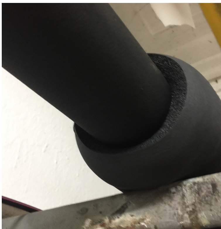
Figura 45 – Tubo de cobre com isolamento térmico completo
