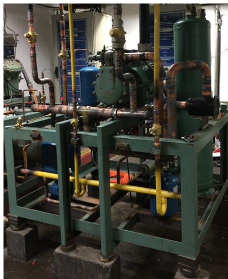
Figura 36 – Rack de resfriados em processo de montagem (vista traseira)
