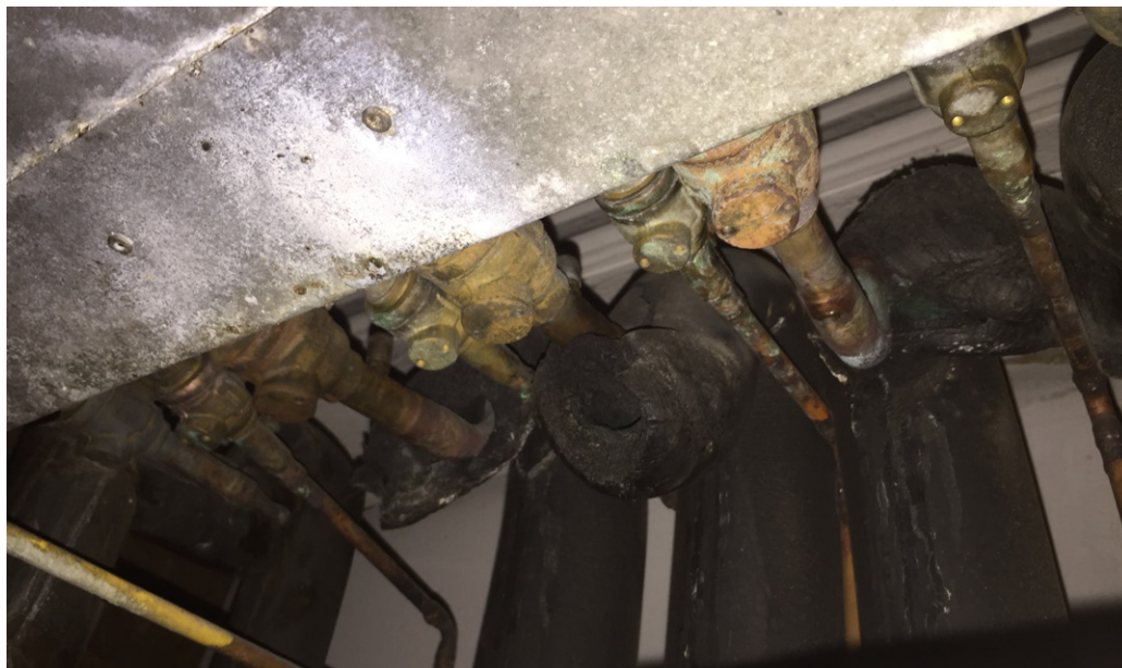
Figura 50 – Válvulas de serviço tipo esfera removidas da tubulação
