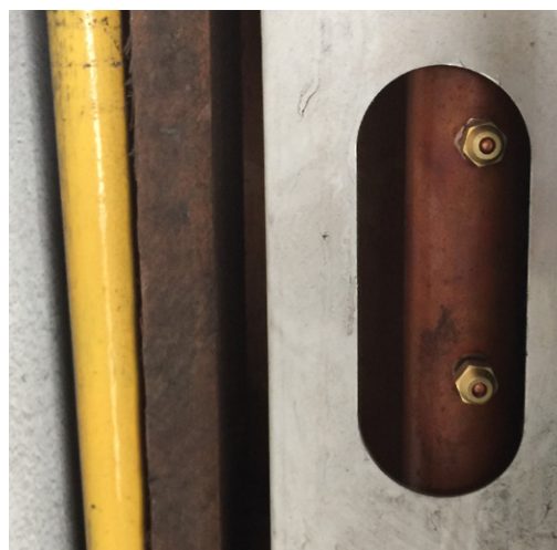
Figura 33 – Válvulas Schrader para tomada de pressão no condensador com porca sextavada e selo de cobre
