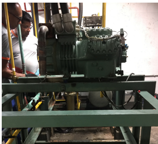
Figura 35 – Rack de resfriados somente com o compressor e sua estrutura para instalação dos novos componentes
