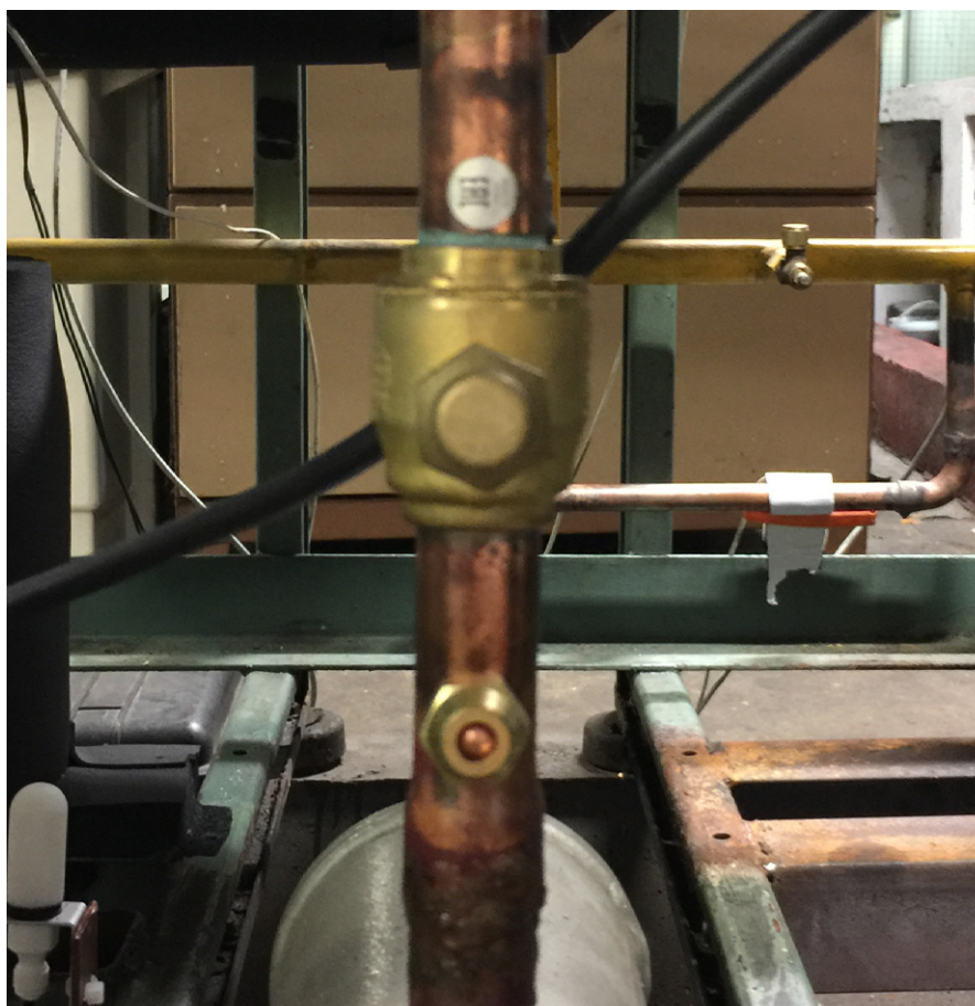
Figura 41 – Válvula esfera com porta de acesso
