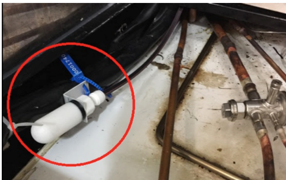
Figura 53 – Sensores de detecção de vazamento – Expositor de bebidas
