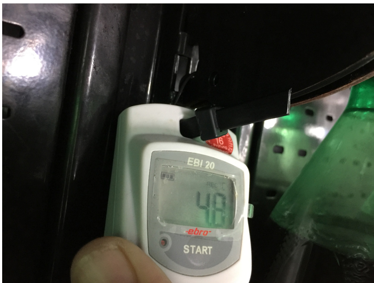
Figura 12 – Datalogger de temperatura instalado dentro do expositor de bebidas
