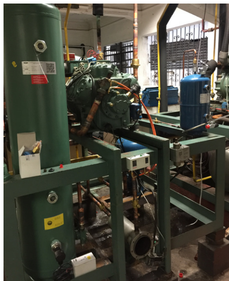
Figura 37 – Rack de resfriados em processo de montagem (vista frontal)
