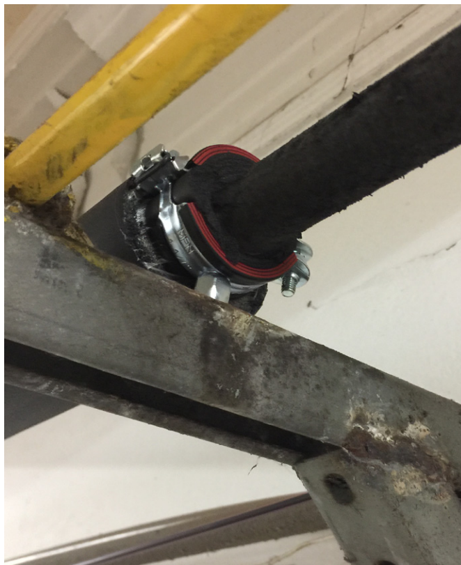
Figura 45 – Tubo de cobre com isolamento térmico completo
