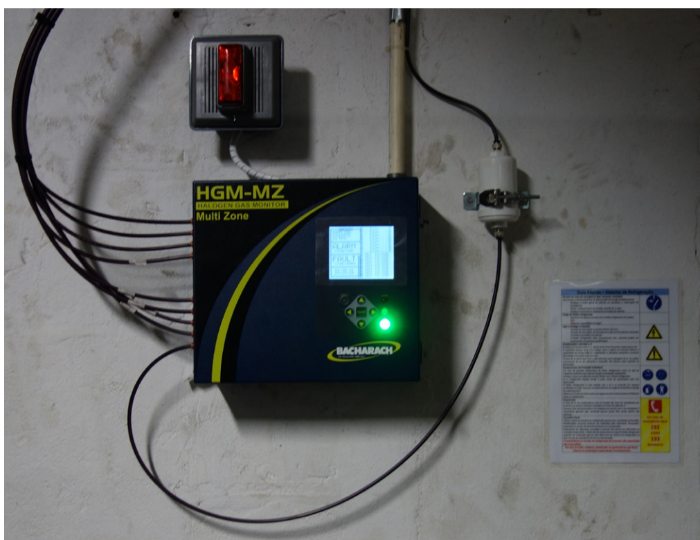
Figura 51 – Aparelho para detecção de vazamento com alarme sonoro e visual
