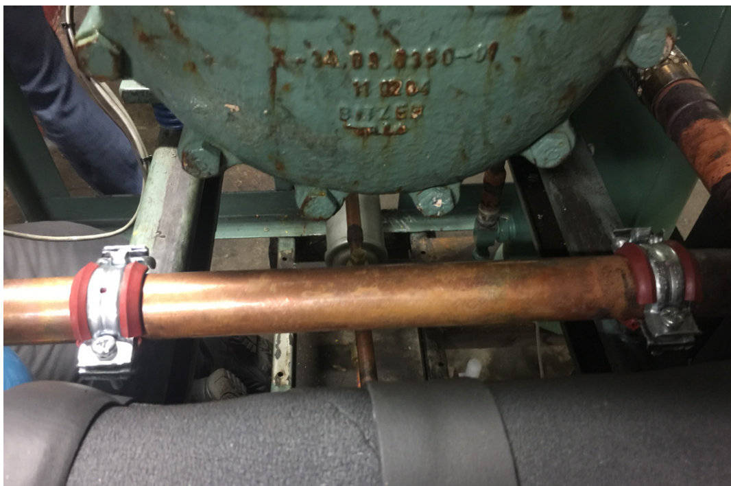
Figura 48 – Tubo de cobre (descarga) com apoios apropriados
