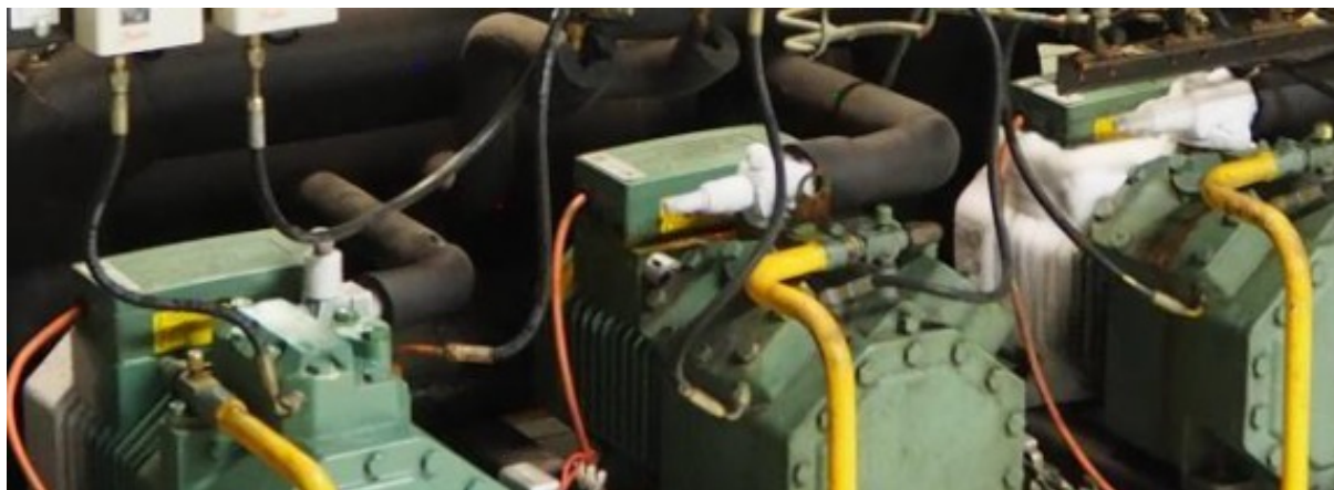
Figura 44 – Compressores em paralelo do ciclo C ( \text{CO}_2 )
