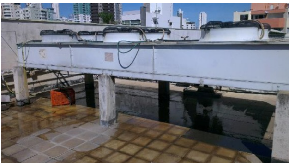
Figura 30 – Condensador para o ciclo de MT (HCFC-22)
