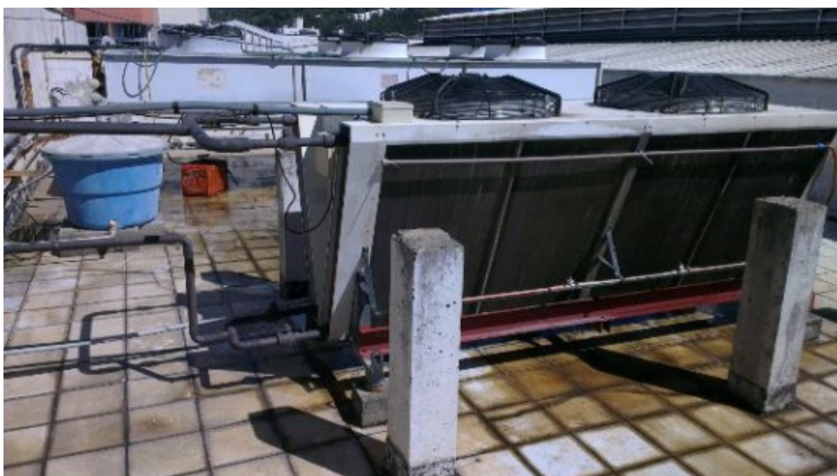
Figura 31 – Condensador em “V” para o ciclo de BT (HCFC-22)
