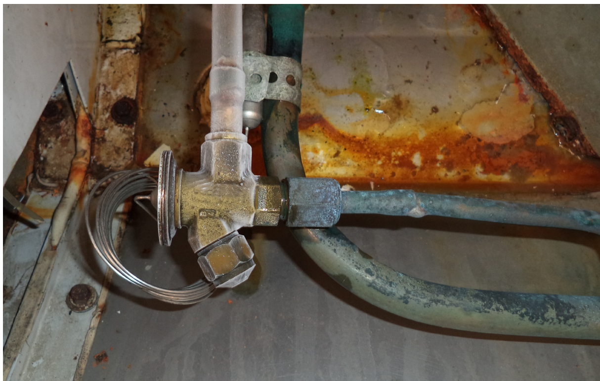
Figura 32 – Válvula de expansão do tipo flange manual
