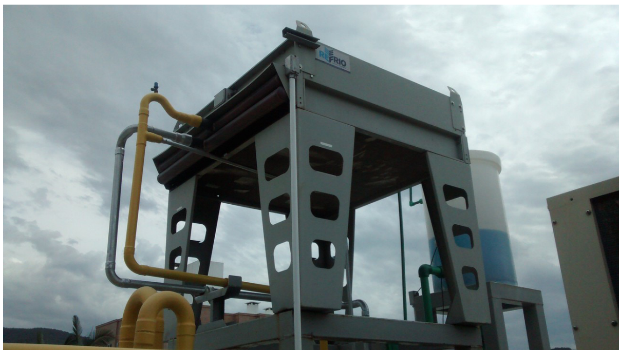
Figura 41 – “Desuperaquecedor” do ciclo com CO 2 com um ventilador
