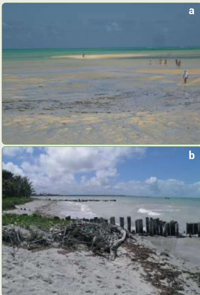
Figura 5.2 – Estrutura de contenção à erosão feita de tronco de coqueiro na Praia de Carne de Vaca
