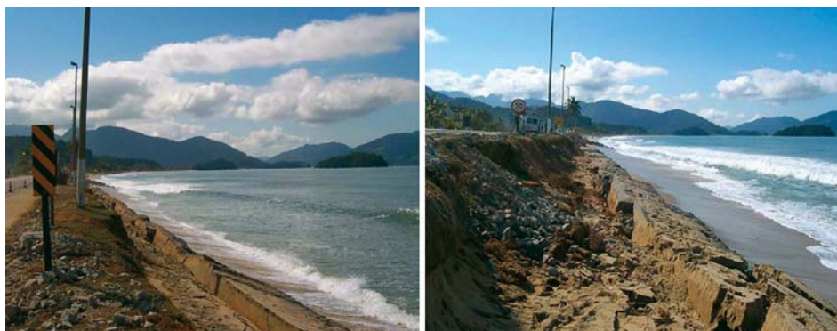
Figura 6 – Solapamento do muro de contenção em 2006
