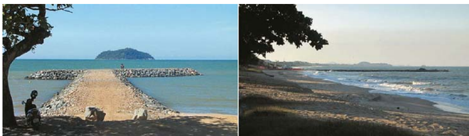
Figura 10 – Imagem mostrando diques construídos em 2011/2012, obra que faz parte, junto com novo aterro hidráulico, do atual projeto de recuperação da praia de Piçarras
