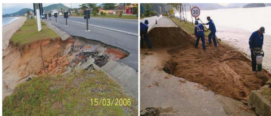
Figura 3 – Erosão decorrente na praia de Massaguaçu e início das obras do muro de contenção
