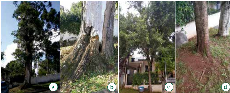
Figura 16.2 – Elevação de raízes e danos ao pavimento em calçadas arborizadas com: a e b) corticeira-da-serra ( Erythrina falcata ) em São Mateus do Sul – PR (elevação da raiz); c e d) guajuvira ( Cordia americana ) em Dois Vizinhos – PR (afioramento da raiz).
