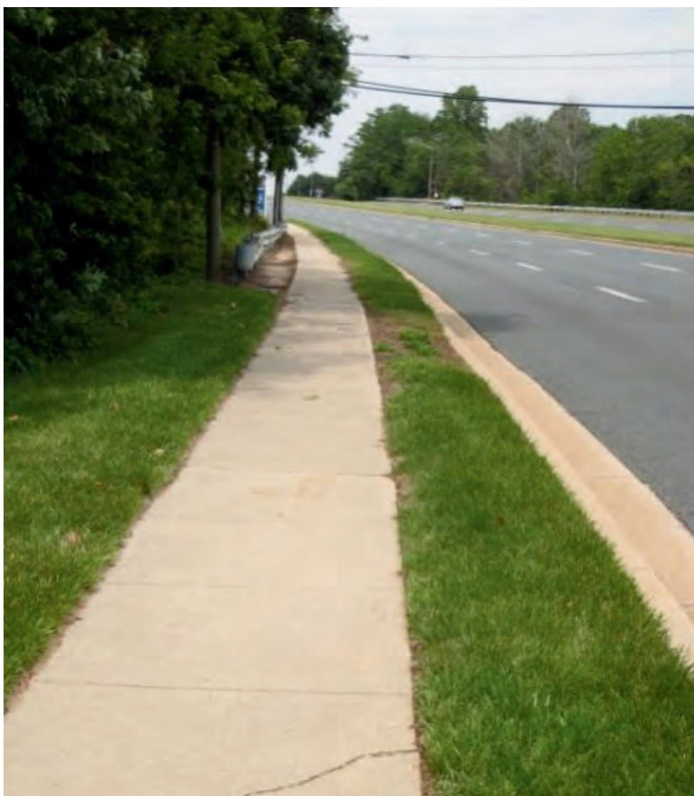
Figura 24.1 – Arborização e área para escoamento da chuva na calçada.
