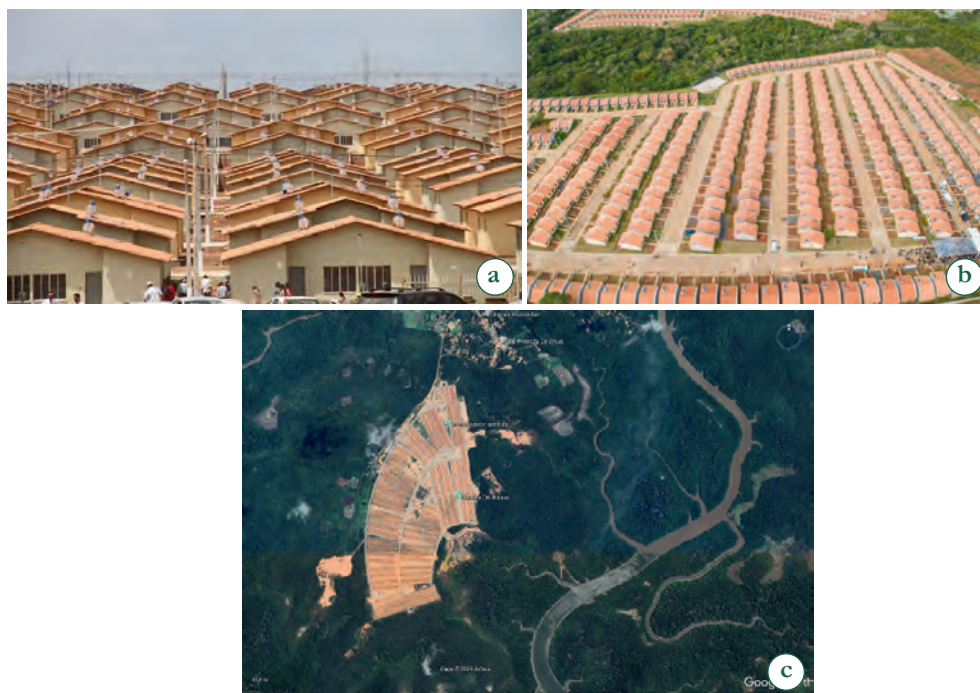
Figura 25.2 – a) Conjunto Habitacional entregue em 2021, em São Luís-MA; b) Conjunto MCMV sem nenhuma vegetação inserido em mata nativa desmatada; e c) Conjunto MCMV assentado em área de 85 hectares desmatados em mata nativa na região sul de São Luís, distante quase 15 km de comércio, escolas, saúde hospitalar e outros, e isolamento com um raio de 8 quilômetros sem nenhum outro adensamento.
