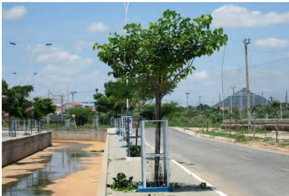
Figura 4.5 – Protetor de ferro (gradil) utilizado na arborização em Patos (PB).
