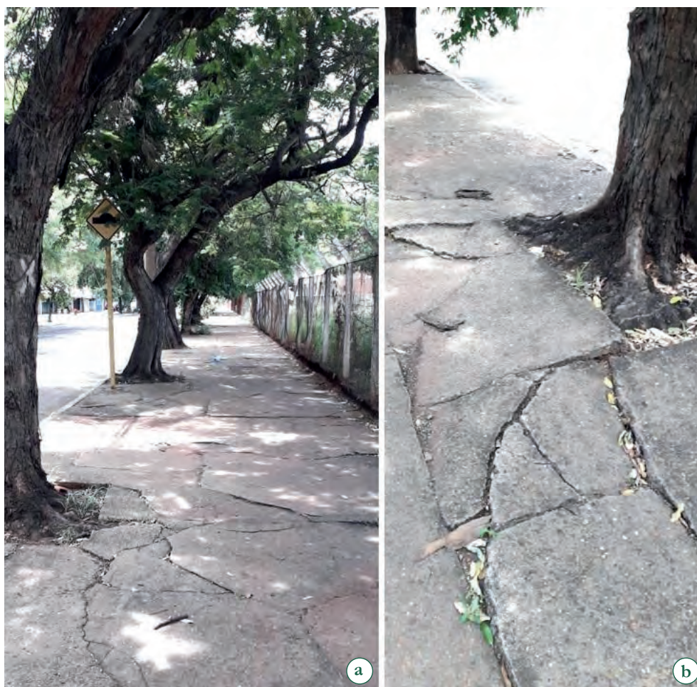
Figura 8.8 – a - b) imagens mostrando calçadas danificadas pelo sistema radicular de espécies arbóreas.
