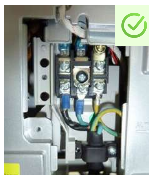
Figura 453 – Pré-ajuste ideal (calibrado) na fábrica para terminais de cabos isolados, conectores e conectores de topo
