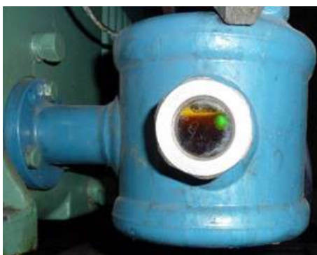
Figura 275 – Regulador do nível de óleo com condição de óleo contaminado
