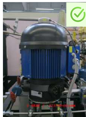
Figura 436 – Colocação e inserção de cabos de última geração nos terminais do compressor
