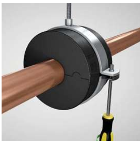
Figura 393 – Etapa 3 – Aperte os parafusos
