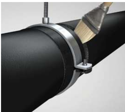
Figura 395 – Etapa 5 - Vedação da zona de contato
