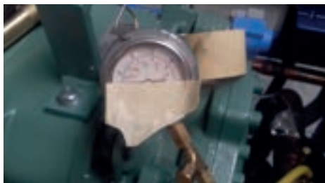
Figura 141 — Uso de um manômetro separado para marcação e monitoramento da pressão
